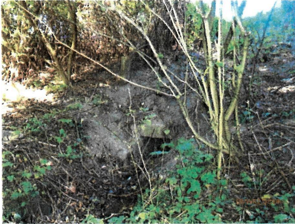
Przepust pod nasypem ulicy. woda płynąca przez przepust rozlewa się po powierzchni osuwiska, nawadniając grunt
