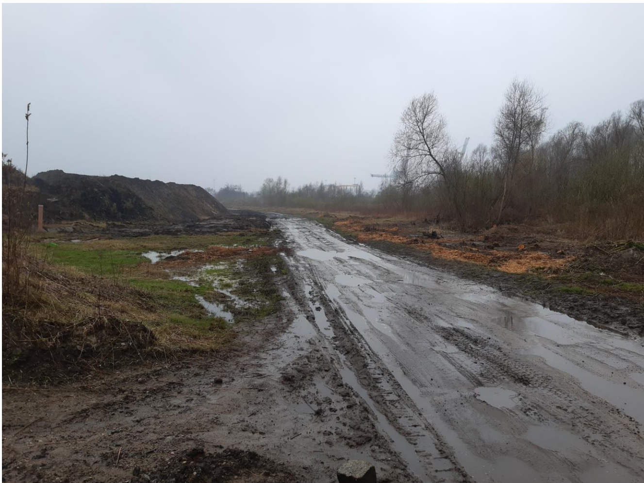
Zdj. 5. Droga istniejąca. Odcinek północny, 450 m na północ od punktu nr 1 planu sytuacyjnego. Widok w kierunku południowym.
