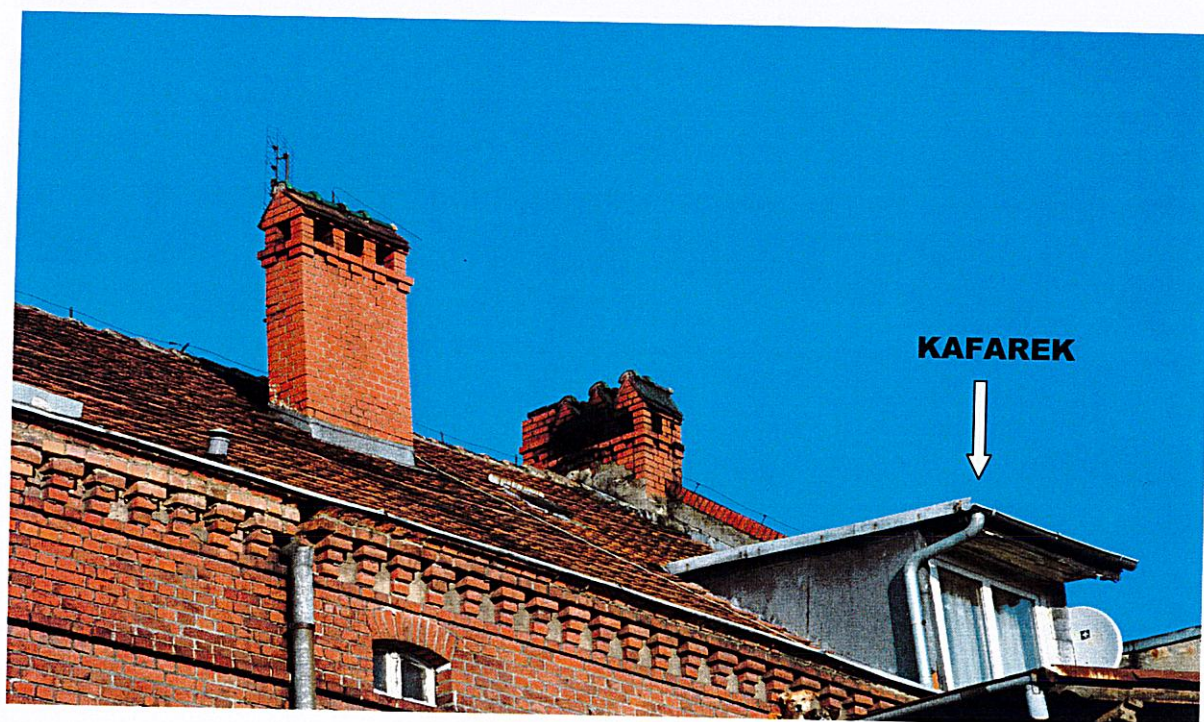
Fot. Nr 17. Kafarek pokryty papą , widok od strony elewacji wschodniej (ogrodowej).
