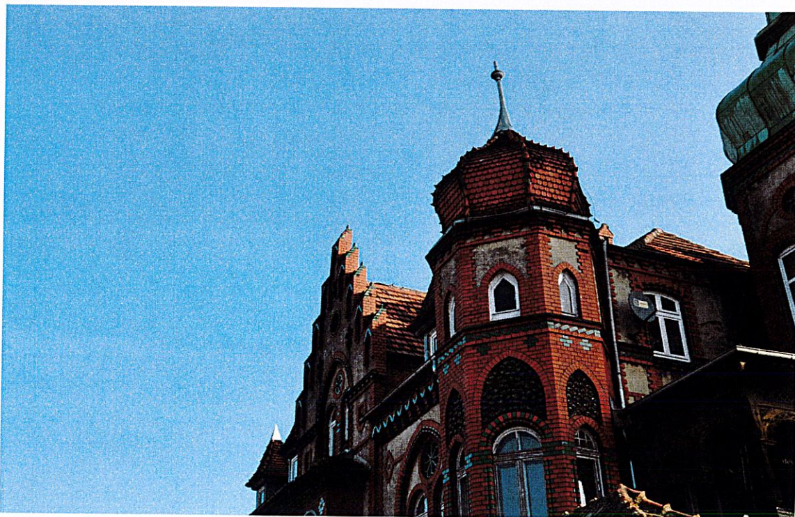
Fot. Nr 13. Wieżyczka, widok od strony południowo-zachodniego narożnika budynku.
