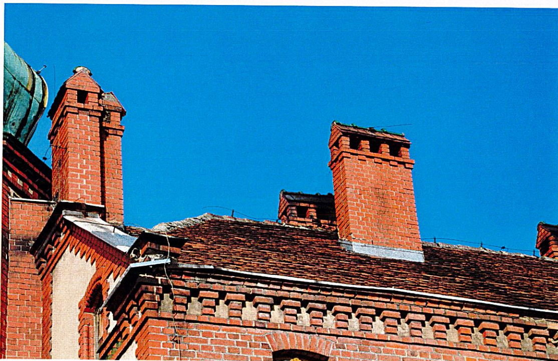
Fot. nr 8. Dach, widok od strony elewacji wschodniej.
