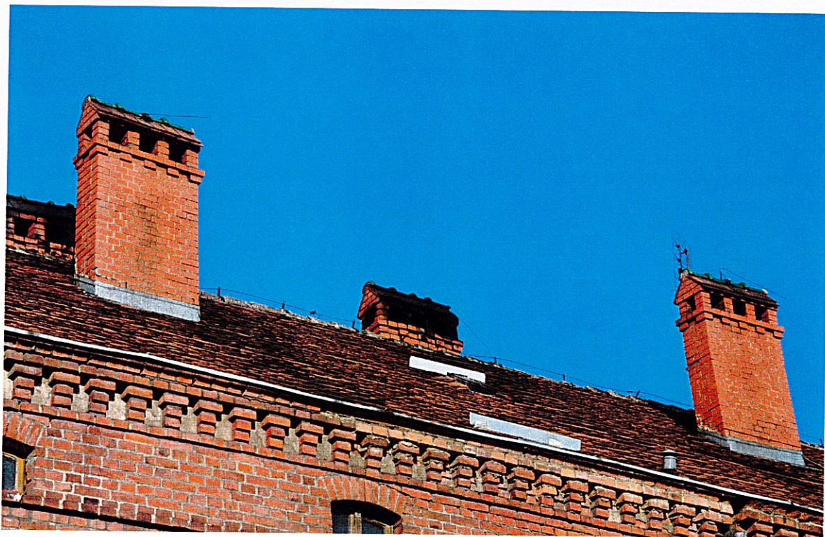
Fot. nr 19. Kominy, widok od str. elewacji wschodniej.
