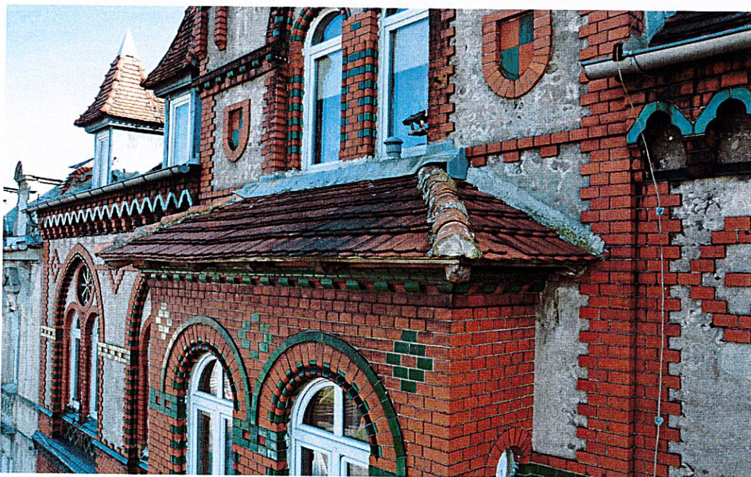
Fot. nr 9. Wykus, widok od strony elewacji frontowej.
