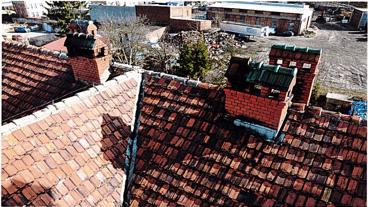
Fot. nr 21. Kominy – na pierwszym planie widoczne oryginalne czapki, wykonane z cegły klinkierowej, licowej w kolorze czerwonym, zwieńczone daszkami, krytymi ozdobną dachówką i ozdobnymi gąsiorami. Zarówno dachówka jak i gąsiorzy posiadają polewę w kolorze zielonym.
