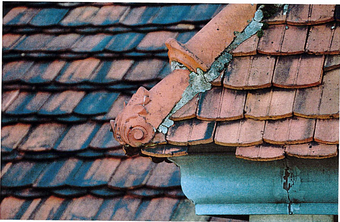
Fot. Nr 12. Lukarna, pokryta dachówką karpiówką ceramiczną wieżową w kolorze naturalnej czerwieni, układaną w łuskę, z gąsiorem butelkowym i gąsiorem kończącym ozdobnym. Widoczne oryginalne, profilowane obróbki blacharskie okapu z blachy tytanowo- cynkowej.
