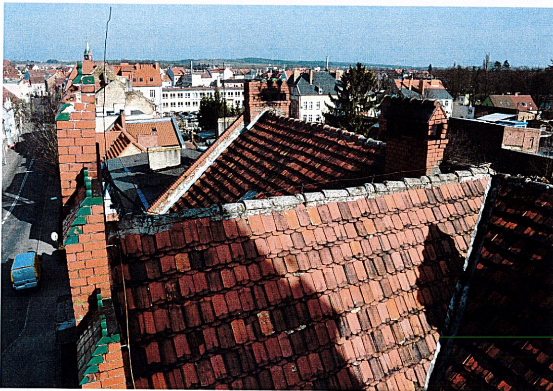
Fot. nr 7. Dach , widok z góry.
