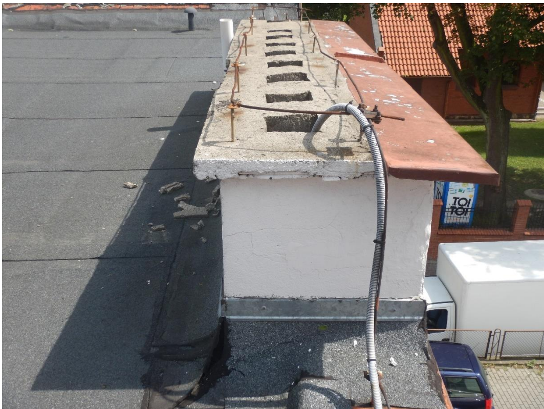
Fot.28 Dach płaski sali - obróbka komina
