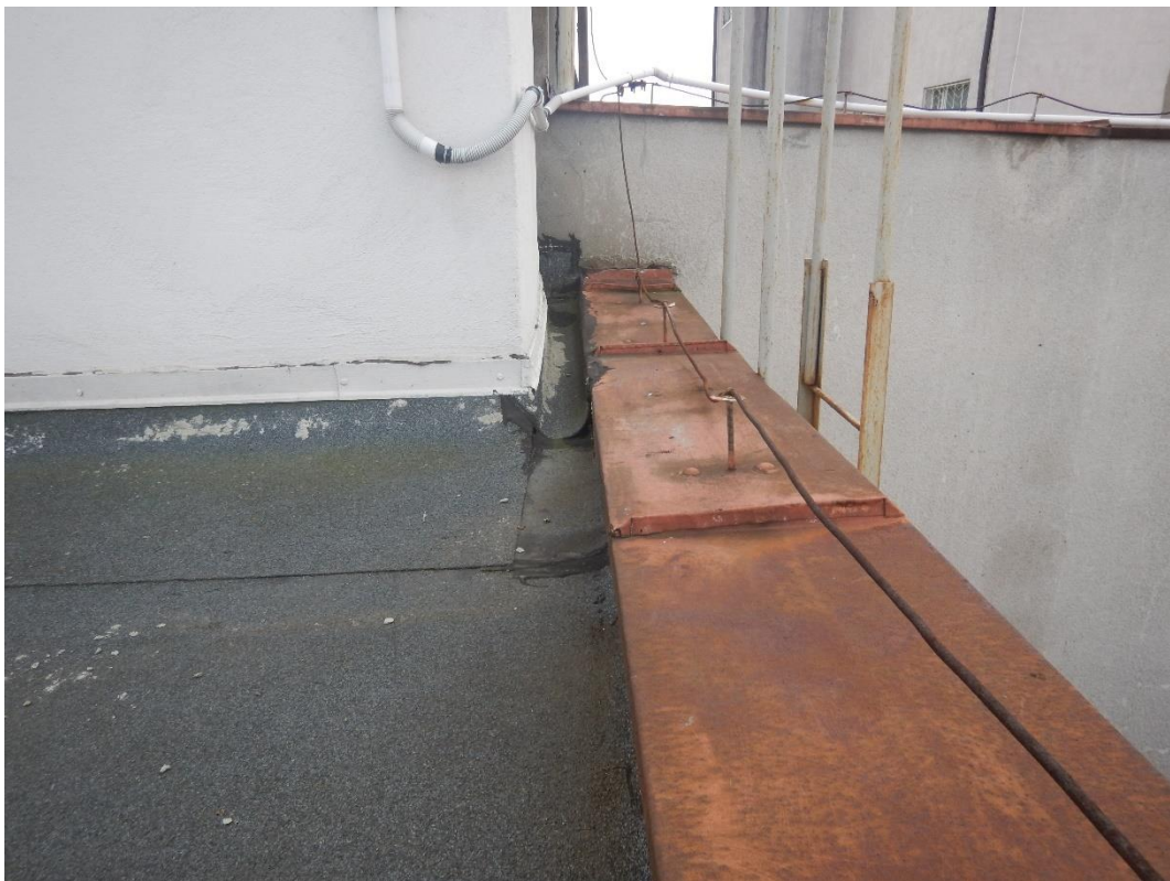
Fot.16 Dach płaski łącznika - attyka od strony zachodniej
