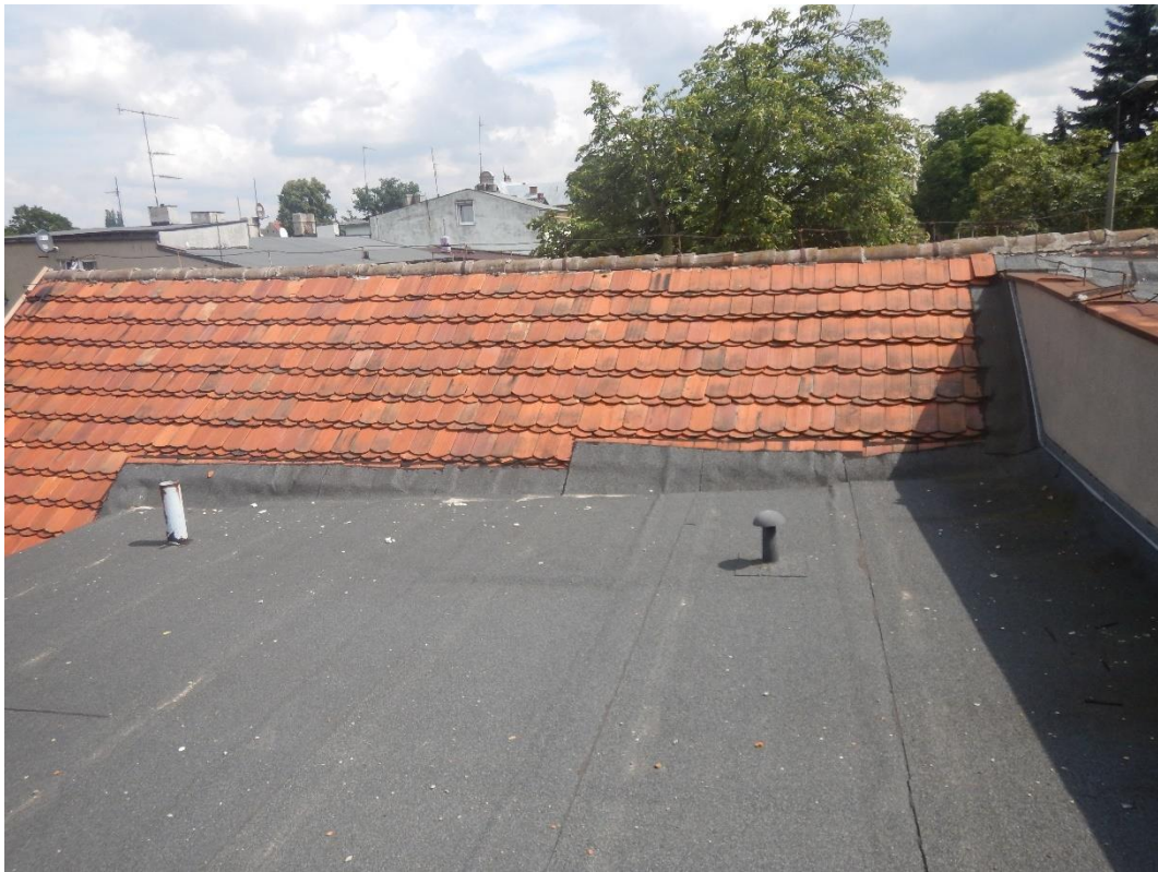
Fot.15 Dach płaski łącznika - widok w kierunku wschodnim
