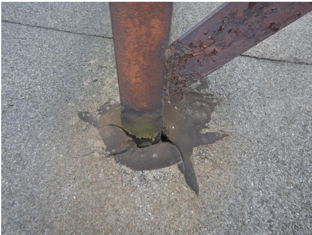
Fot.30 Dach płaski sali - obróbka konstrukcji wsporczej
