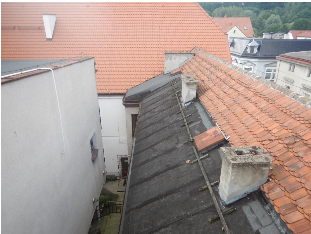
Fot.4 Dach łącznika - potać południowa
