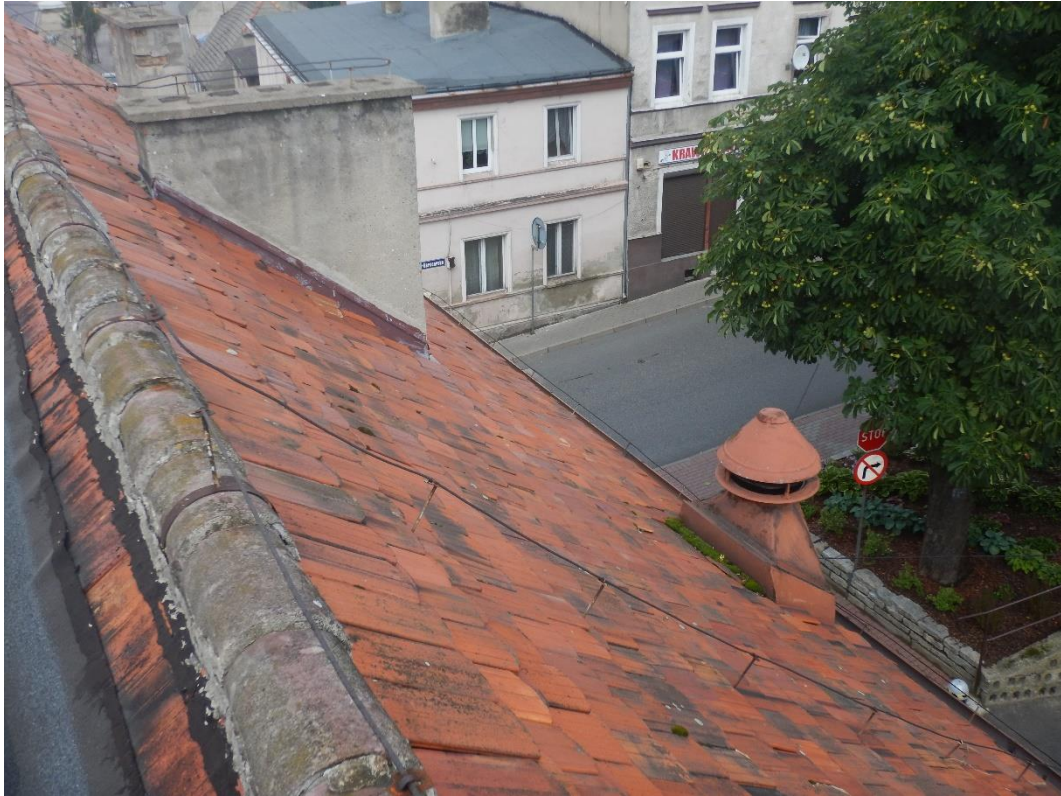
Fot.23 Dach stromy sali - połać od ulicy Farnej
