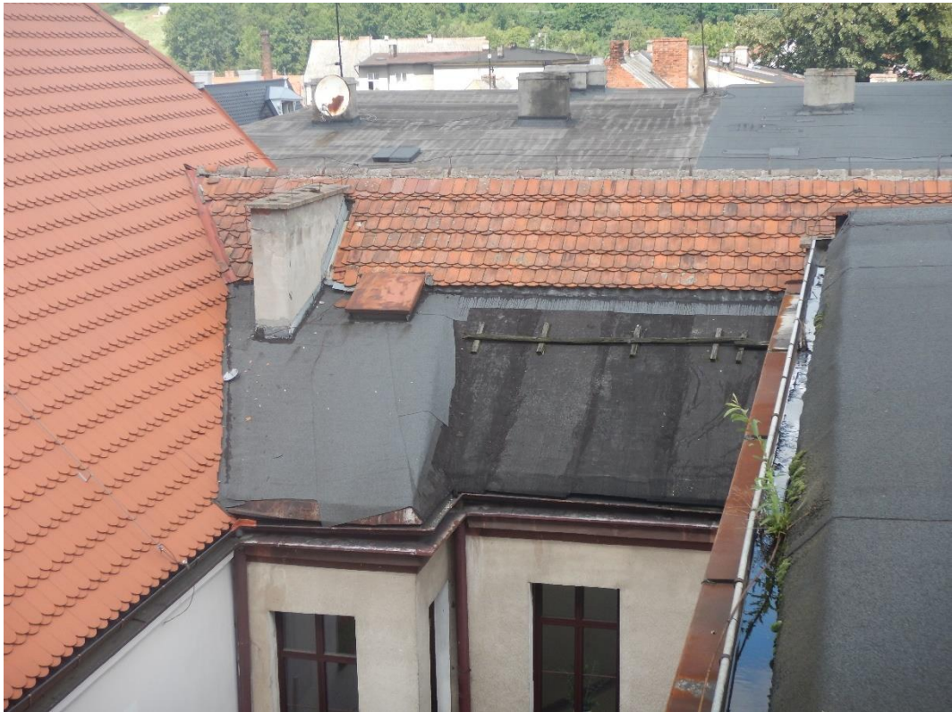
Fot.3 Dach łącznika - kosz przy potaci budynku Ratusza
