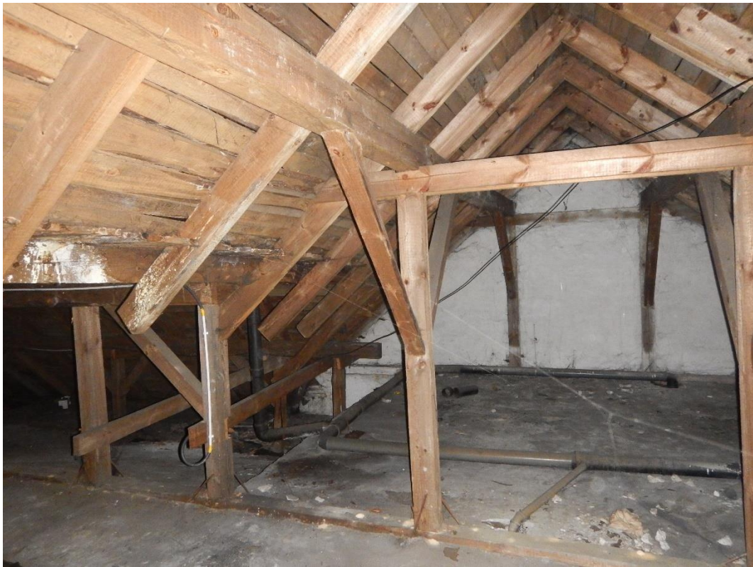
Fot.33 Dach sali - więźba drewniana
