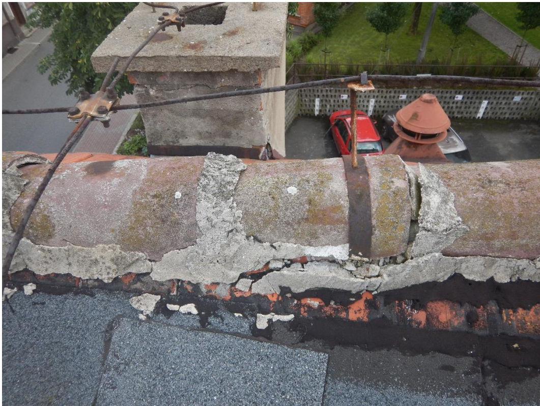
Fot.25 Dach stromy sali - gąsior, połączenie z dachem płaskim
