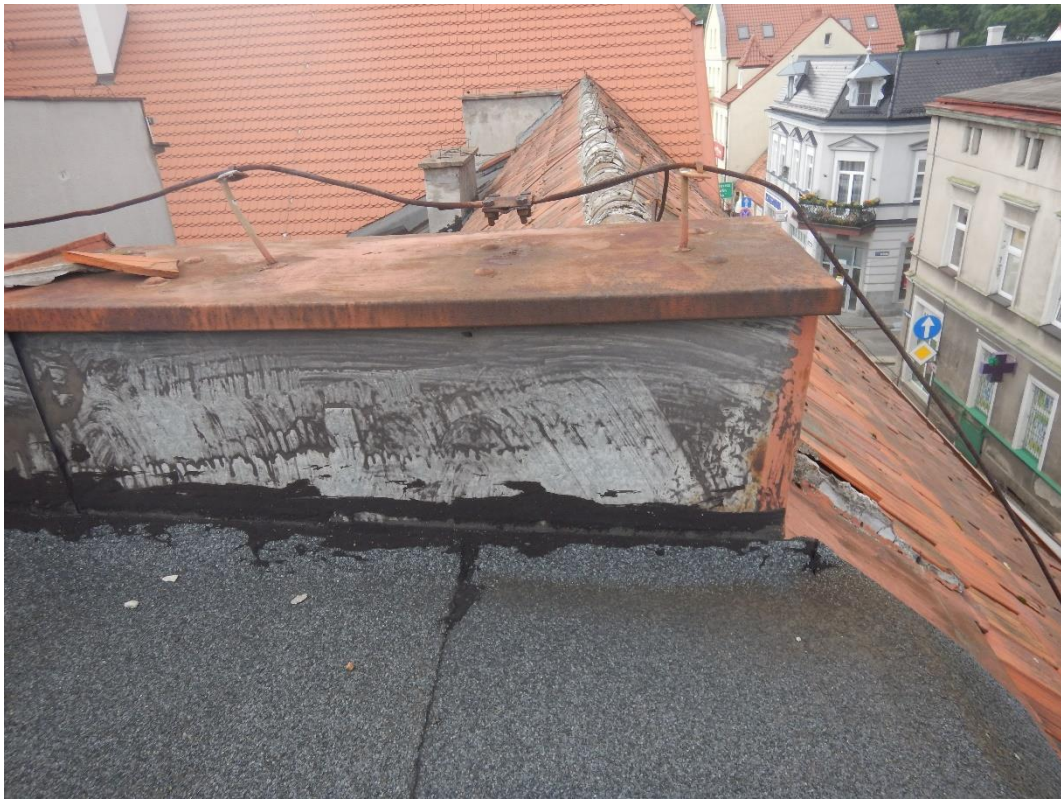
Fot.19 Dach płaski łącznika - obróbka attyki
