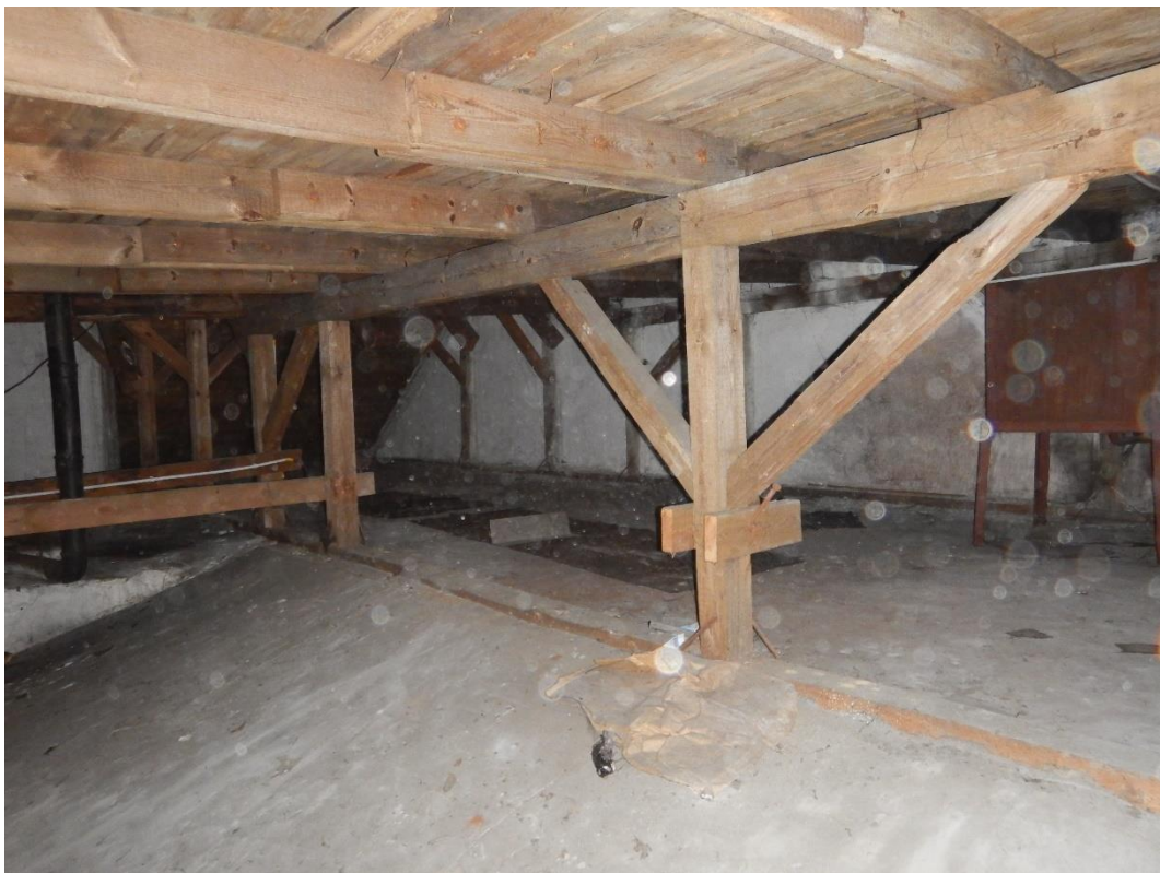
Fot.34 Dach płaski łącznika - więźba drewniana
