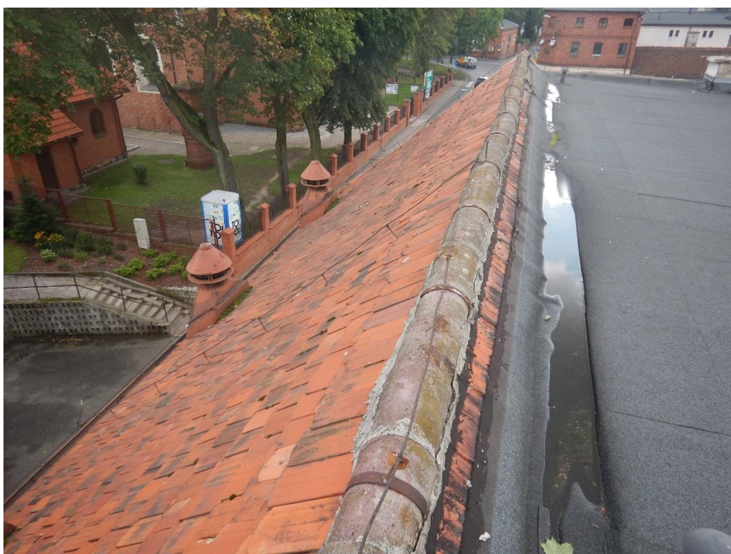
Fot.22 Dach stromy sali – kalenica
