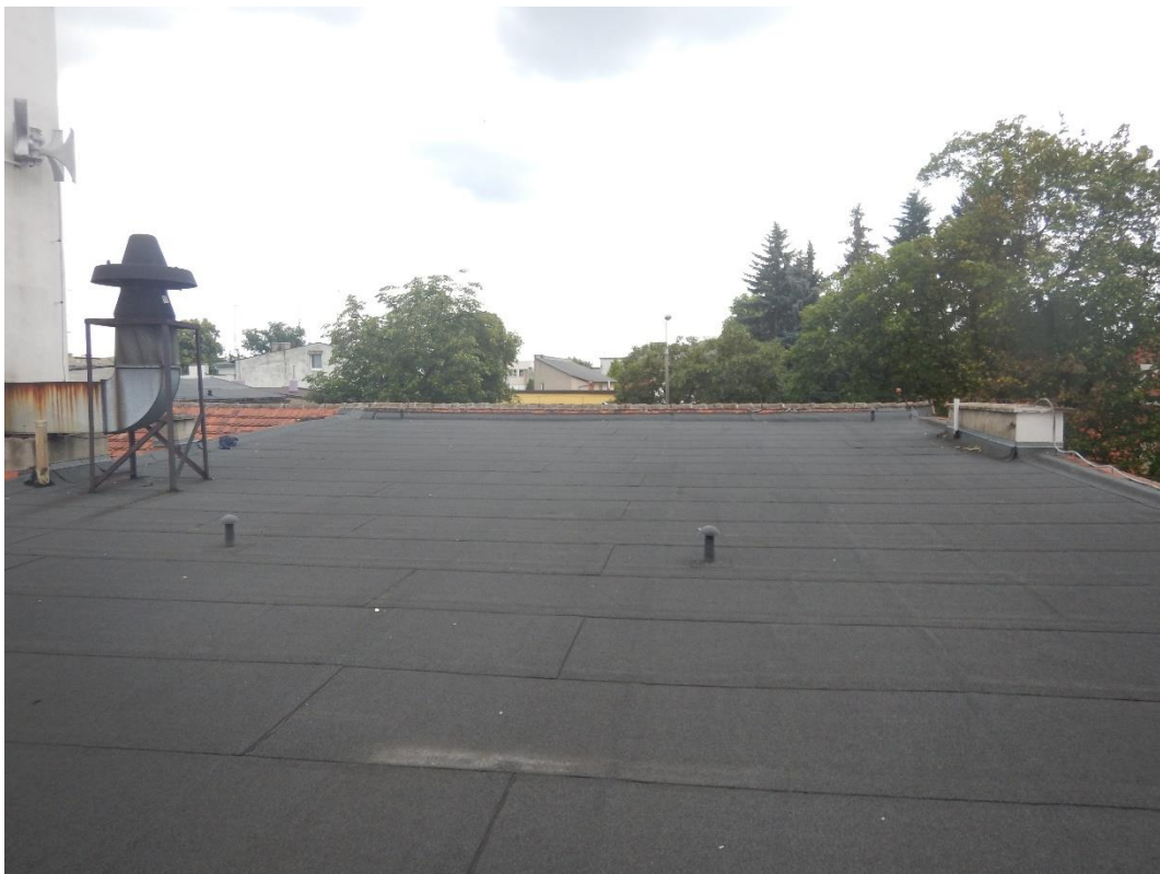
Fot.26 Dach płaski sali
