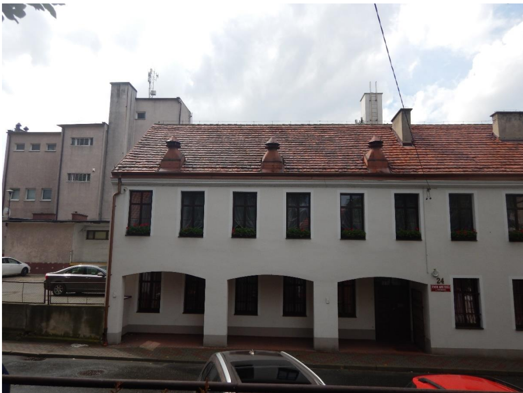
Fot.2 Elewacja budynku od ul. Farnej
