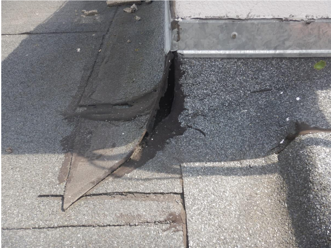
Fot.27 Dach płaski sali - obróbka komina
