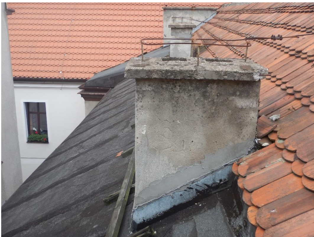
Fot.10 Dach łącznika - obróbka komina
