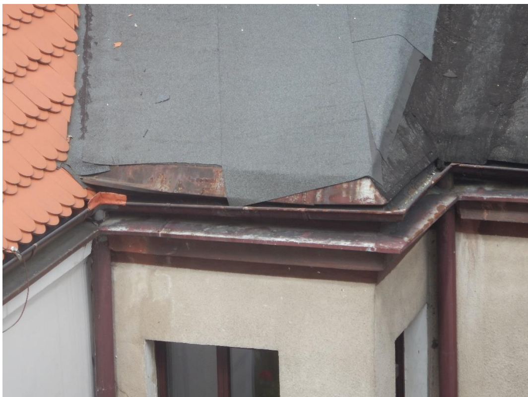
Fot.12 Dach łącznika - orynnowanie przy budynku Ratusza
