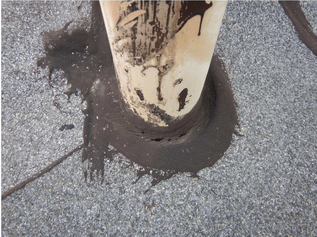
Fot.29 Dach płaski sali - obróbka kominka wentylacyjnego
