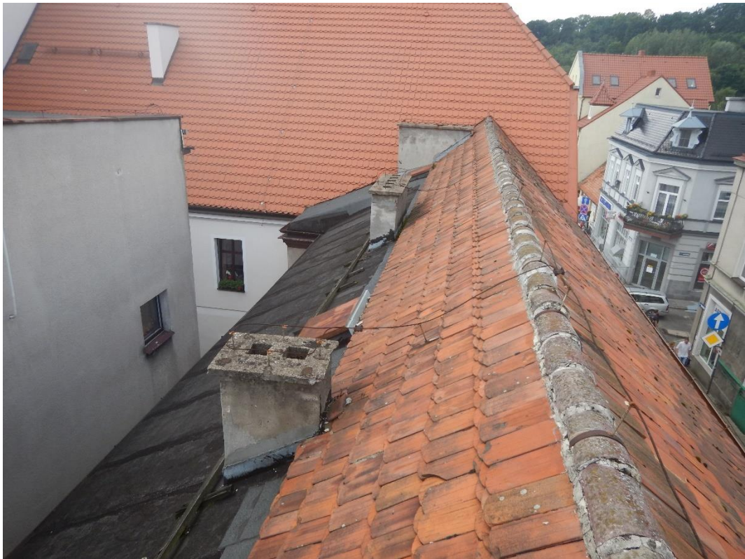
Fot.5 Dach łącznika - kalenica
