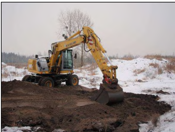
Fot. 16 Operator koparki kończy zasypywanie szurfu nr I urobkiem i wyrównuje teren.
