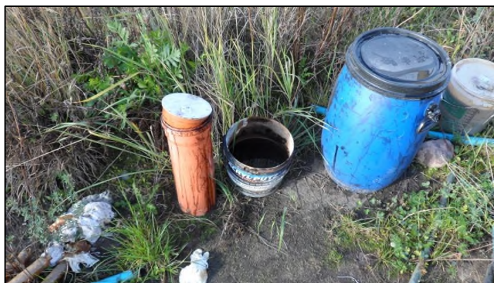
Ryc. 48. Porzucone czerpaki i naczynia po ręcznym usuwaniu oleju kreozotowego z otworu technologicznego na dawnym wylewisku ścieków z nasycalni w Ostrowie Mazowieckiej. 25.09.2013.
