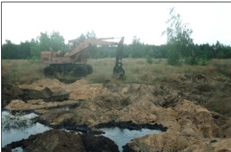
Fot. 13. Tak zasypywano zagłębienie, do którego trafiały zbędne oleje i szlamy z wykopywanych zbiorników. Zdjęcie archiwalne z lat 2004-2006.
