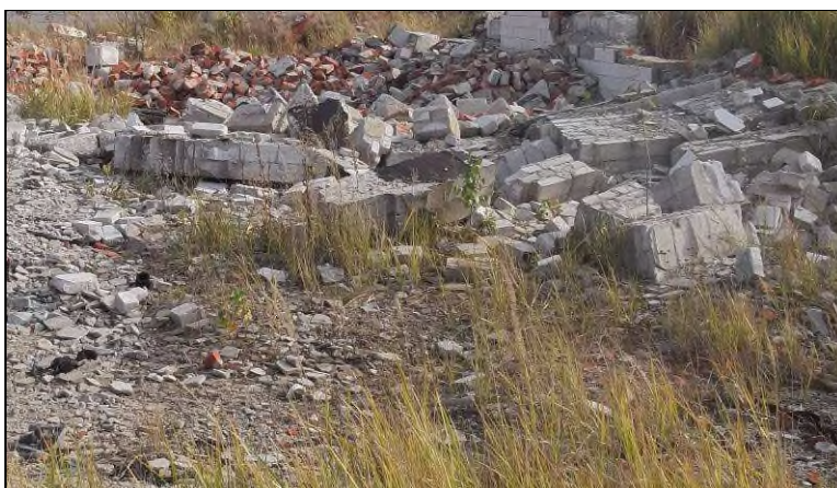
Fot. 1. W wielu miejscach znajduje się gruz, który po przekruszeniu może być ponownie wykorzystany jako materiał (kruszywo) budowlane.
