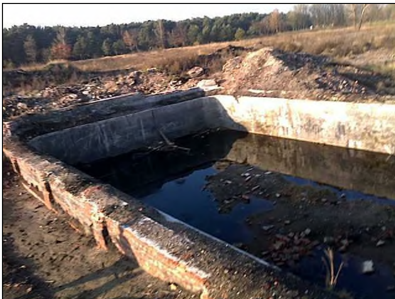
Fot. 24. Prostokątny zbiornik podziemny jest obecnie tylko w części wypełniony wodą opadową. Ściany są murowane i wyprawione gładzią cementową. W tle widoczny las – park miejski.
