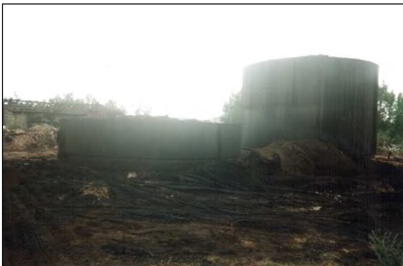
Fot. 8. Dwa zbiorniki cylindryczne na kreozot. Zdjęcie z czasów wyburzania zakładu w 2003-2004 roku. Bliższy zbiornik pozostał ucięty i do dziś zawiera resztki kreozotu, dalszy już nie istnieje, został ze złomowany.
