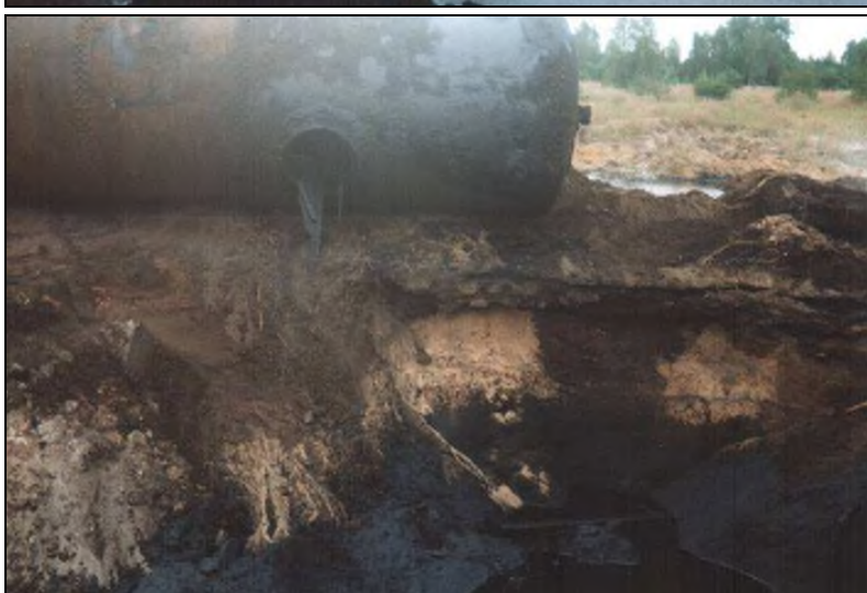
Fot. 11. Fragment wykopanego zbiornika 60 m 3 . Widok od strony północnej. Wyraźnie widać, że teren przy zbiorniku był pierwotnie czysty i dopiero wylanie olejów ze zbiornika silnie zanieczyściło podłoże. Zdjęcie archiwalne z lat 2004-2006
