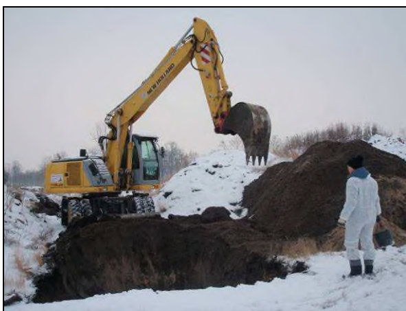
Fot. 14. Prace przy wykonywaniu szurfu nr I. Wokół istniejące od 2006 roku hałdy ziemno-gruzowe.
