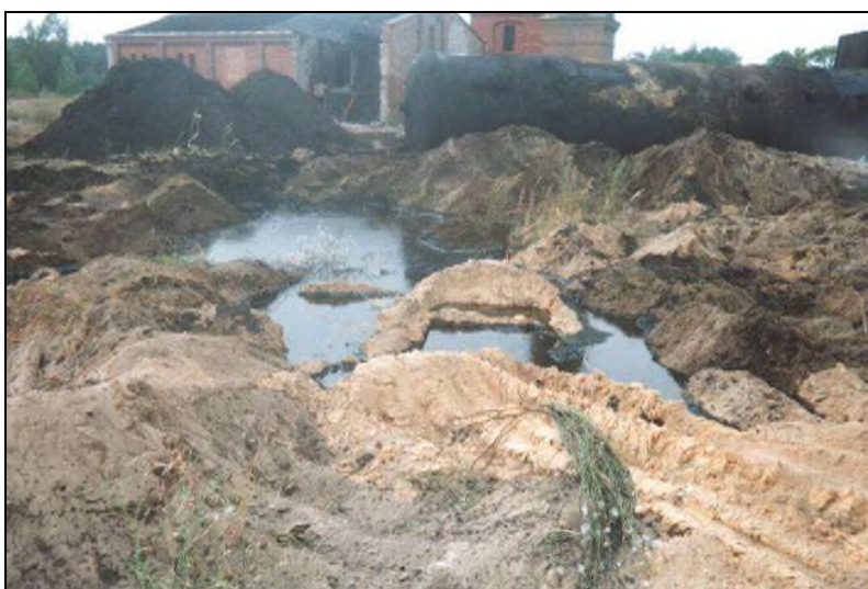
Fot. 9. Zdjęcie archiwalne stanu z lat 2004-2006. Widok od strony południowej na wyburzone budynki nasycalni (w tle). Na pierwszym planie zasypywane wylewisko ścieków technologicznych, a za nim odkopany i wyjęty zbiornik stalowy 60 m 3 .
