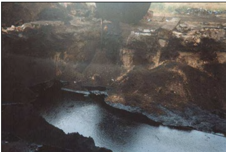
Fot. 10. Zastoiska krezotuz po wylaniu go ze starego, wykopanego zbiornika do wyrobiska. Zdjęcie archiwalne wykopu z lat 2004-2006.
