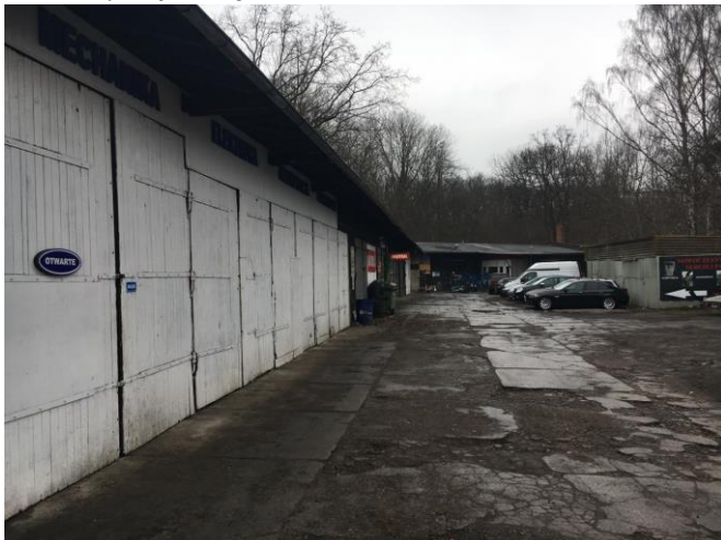
Zdj. 1 Budynek warsztatowy - przeznaczony do rozbiórki
