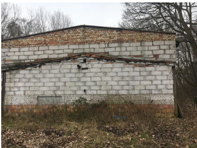
Zdj. 3 Budynek warsztatowy - elewacja północno-wschodnia
