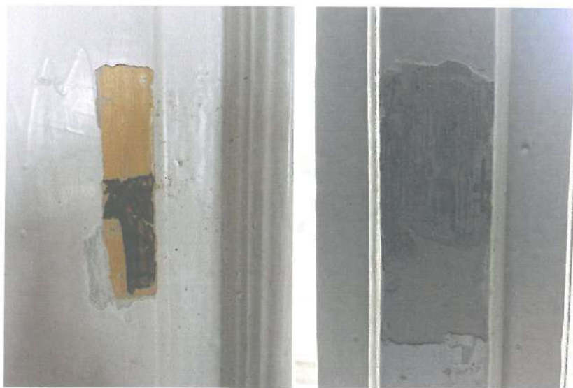
Fot. nr 27. Odkrywki na drzwiach i stolarce. Drzwi były brązowe, okna białe z szarym mazerunkiem.
