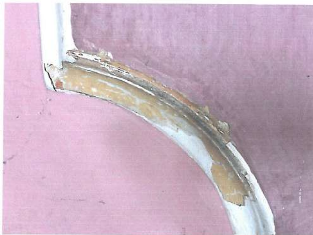
Fot. nr 49. Odkrywka na profilowanych obramieniach płytek w sali widowiskowej. Odsłonięty oryginalny ugrowy kolor.
