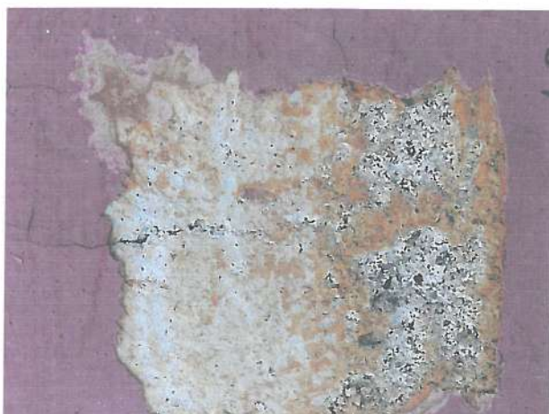
Fot. nr 47. Odkrywka stratygraficzna na płycinach w sali widowiskowej.
