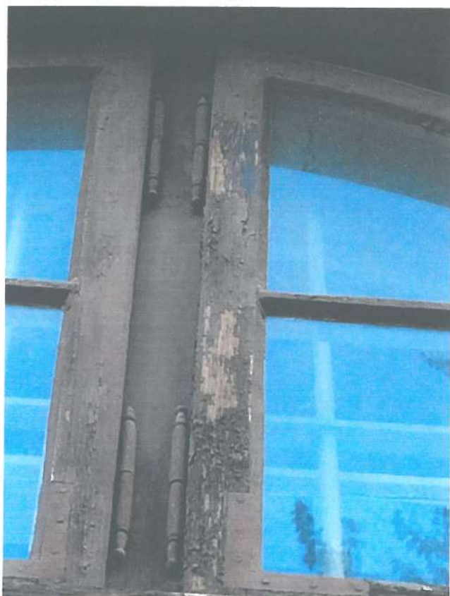
Fot. nr 63. Odkrywka na oknach na elewacji. Najstarsza zachowana warstwa malarska jest w kolorze brązowym.
