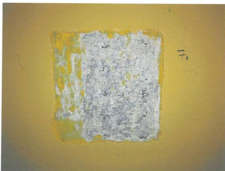
Fot. nr 17. Odkrywka nr 7 w pomieszczeniu nr 2. Odsłonięta polichromia.
