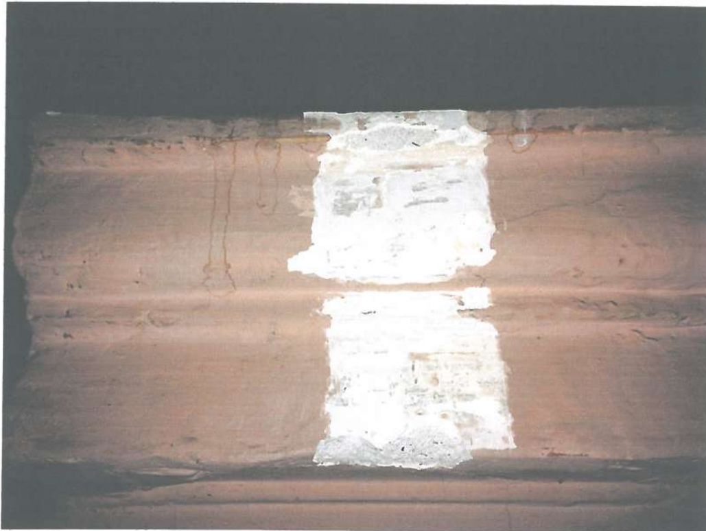
Fot. nr 53. Odkrywka na gzymsie w górnej partii ścian sali widowiskowej. Widoczny jasnoszary kolor.
