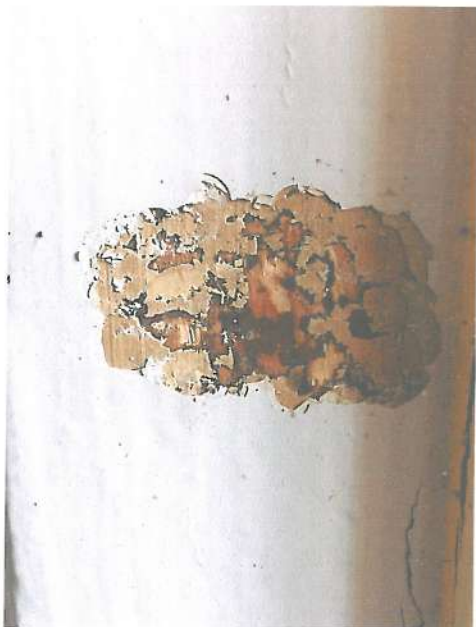
Fot. nr 22. Odkrywka na drzwiach, najstarsza warstwa ciemnobrązowa z mazerunkiem.
