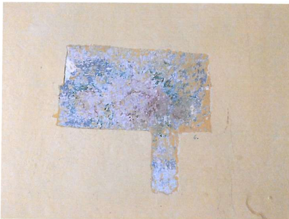
Fot. nr 16. Odkrywka nr 6 w pomieszczeniu nr 2. Odsłonięta polichromia.
