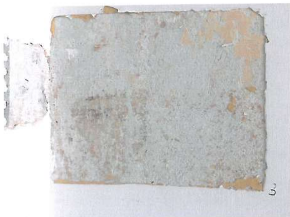
Fot. nr 36. Druga część sieni. Odkrywka na ścianie. Brak dekoracji. Najstarszy zachowany kolor ściany szroniebieski.
