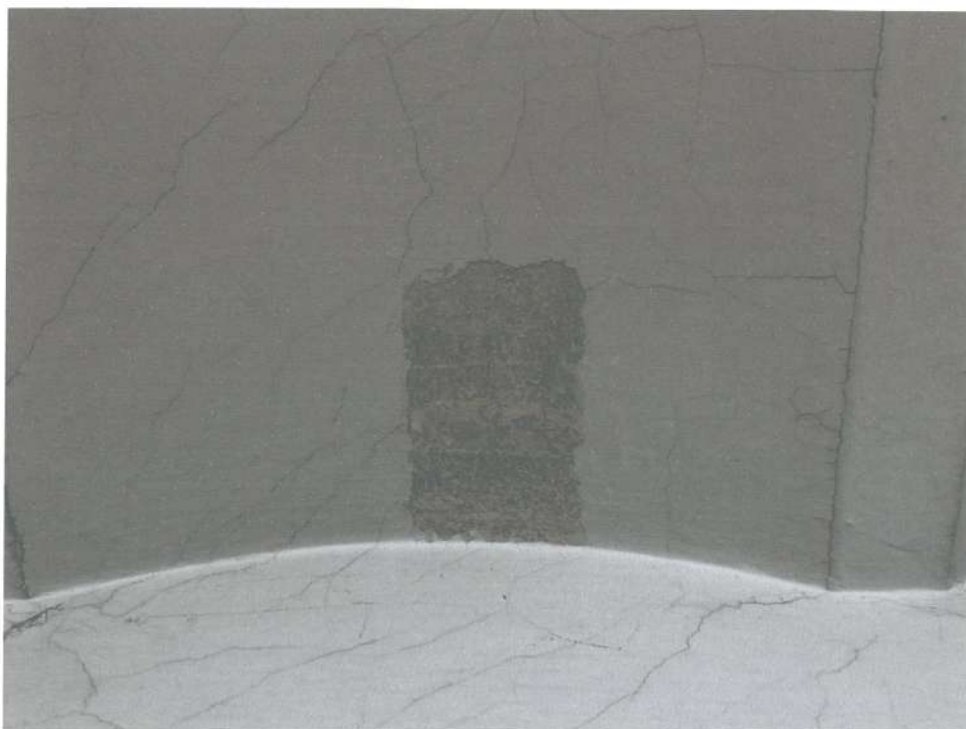
Fot. nr 26. Odkrywka nr 6 wykonana na stropie w pomieszczeniu nr 4. Widoczne ślady dekoracji.
