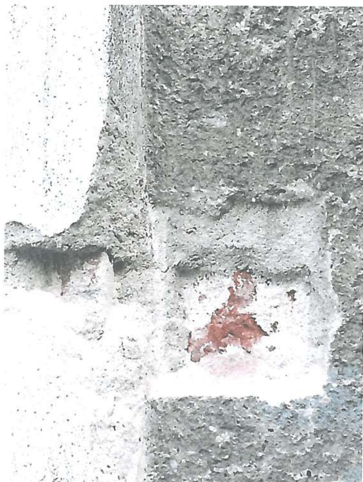
Fot. nr 59. Odkrywka na elewacji. Widoczny brak oryginalnych zapraw , które zostały skute do cegły. Obecnie tynk wapienno cementowy opracowany fakturalnie.
