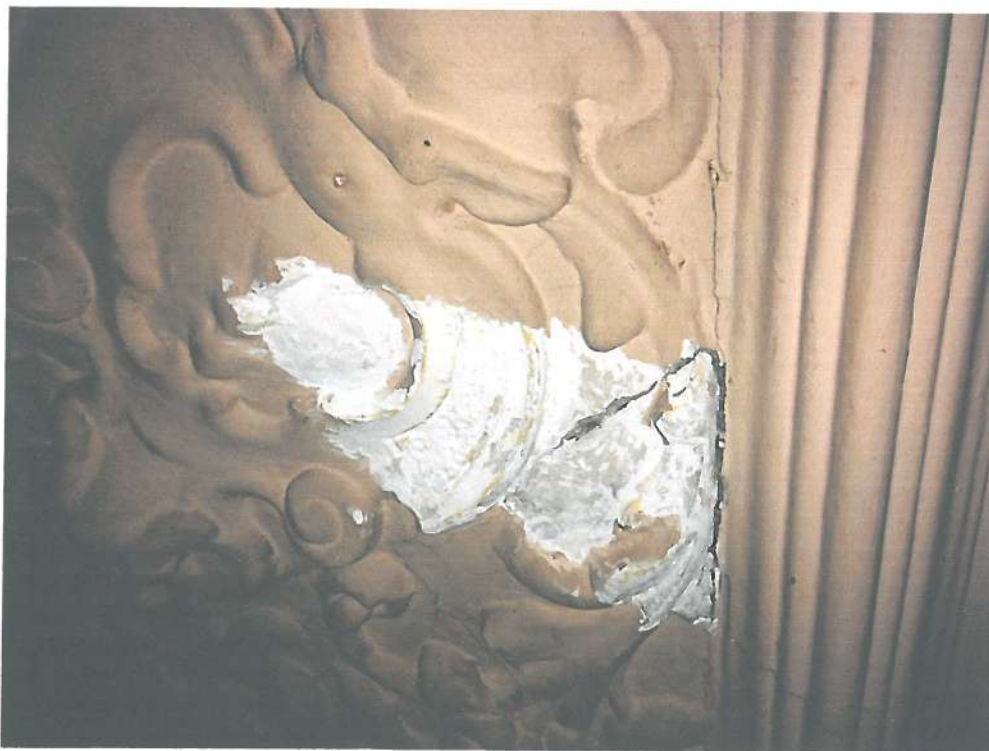
Fot. nr 54. Odkrywka na sztukateriach na suficie w sali widowiskowej. Widoczny jasnokremowa pobiała wapienna i jasnoszary kolor.
