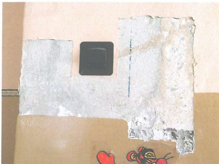
Fot. nr 44. Odkrywka na klatce schodowej. Widoczne wtórne tynki z niebieskim paskiem.
