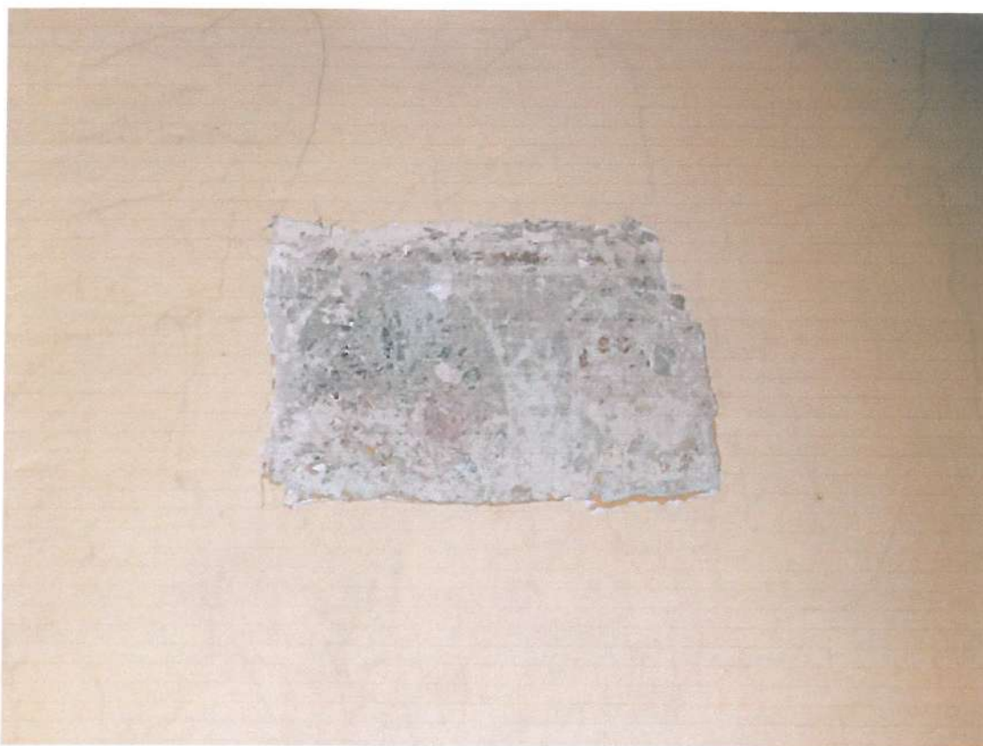
Fot. nr 21. Odkrywka nr 5 w pomieszczeniu nr 3 na ścianie południowej, odsłonięta polichromia.
