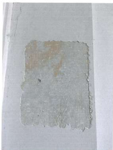
Fot. nr 32. Odkrywka na ścianie w pierwszej części sieni. Brak dekoracji. Jasno szary kolor ściany.
