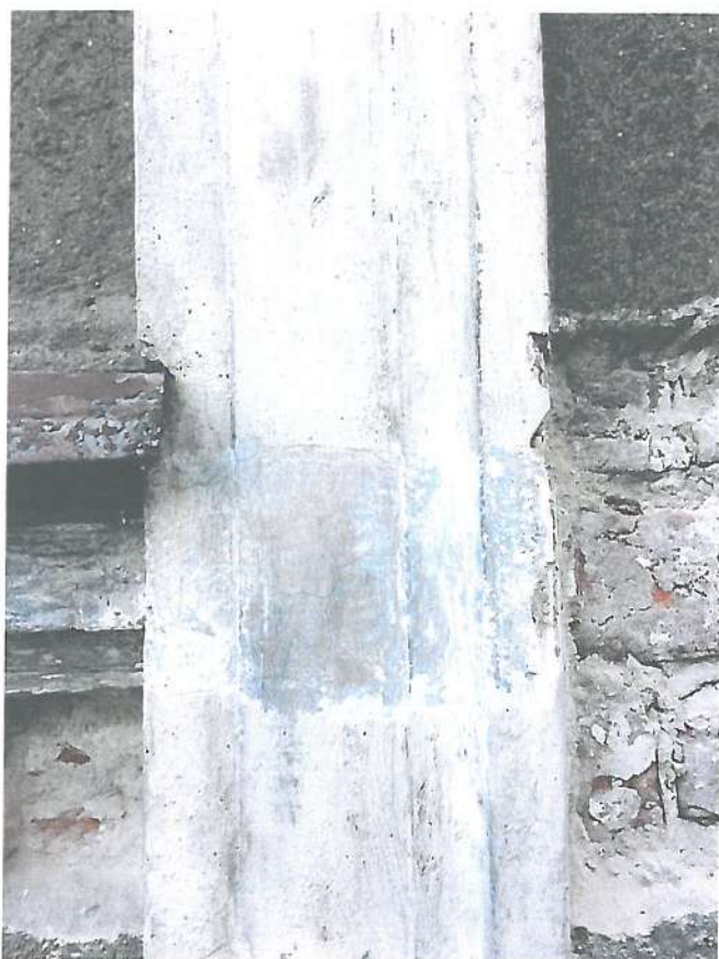
Fot. nr 62. Odkrywka na elewacji wschodniej. Widoczny szary kolor na profilowanych opaskach.
