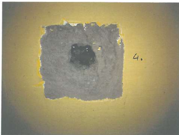
Fot. nr 15. Odkrywka nr 4 w pomieszczeniu nr 2. Odsłonięty wtórny tynk.
