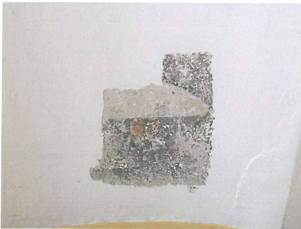
Fot. nr 18. Odkrywka nr 10 wykonana na stropie, w pomieszczeniu nr 2. Odsłonięta polichromia.
