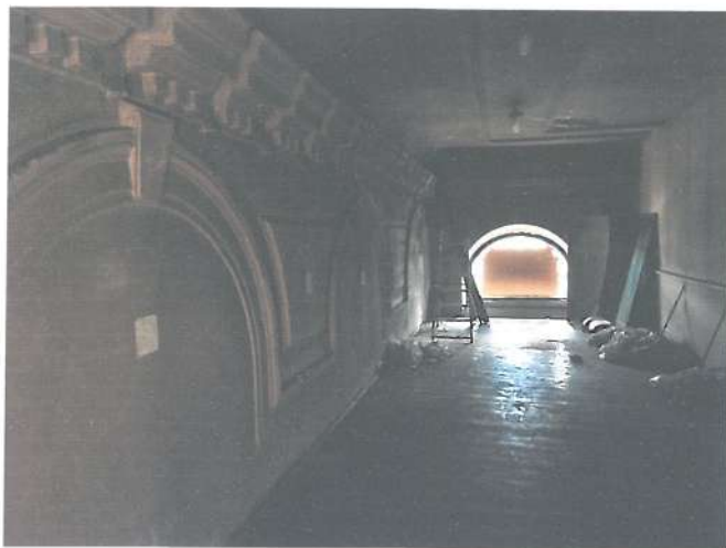
Fot. nr 51. Odkrywki wykonane w górnych partiach ścian sali widowiskowej z balkonu obecnie przysłoniętego wtórną ścianką.
