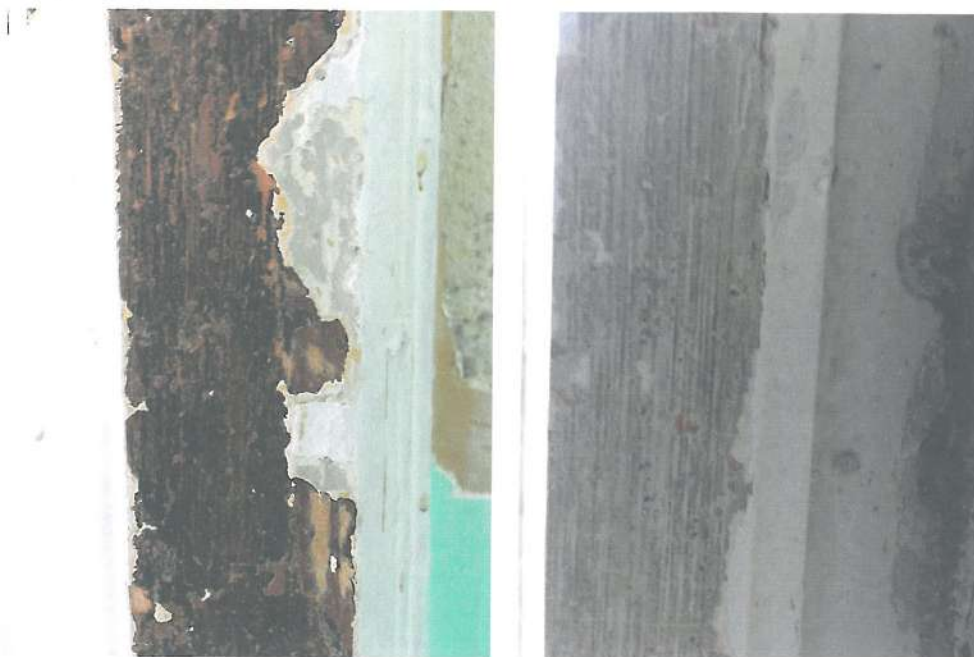
Fot. nr 10 i 11. Odkrywki na drzwiach i oknie. Pierwotnie drzwi kolor miały ciemno brązowy z mazerunkiem a okna białe z szarym mazerunkiem
