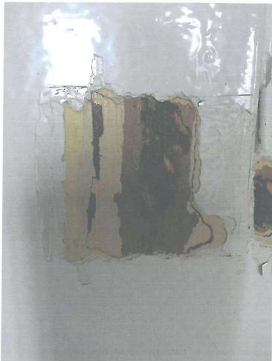
Fot. nr 57. Odkrywka stratygraficzna na drzwiach w sali widowiskowej.
