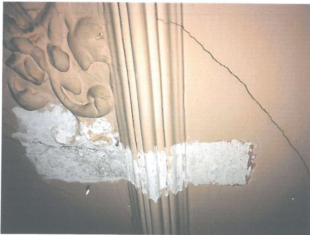
Fot. nr 55. Odkrywka na sztukateriach na suficie w sali widowiskowej. Widoczny jasnokremowa pobiała wapienna i jasnoszary kolor.
