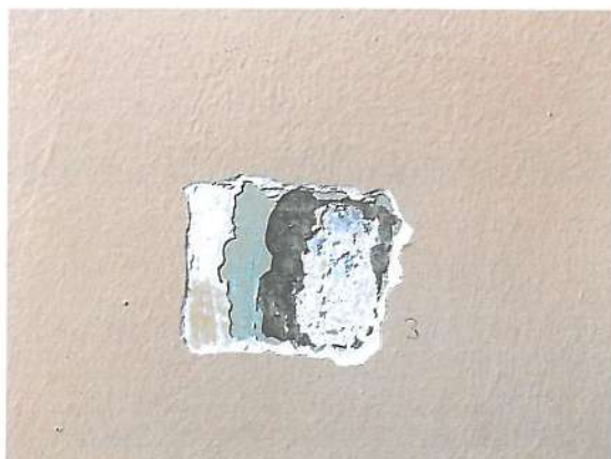
Fot. nr 41. Odkrywka stratygraficzna na lamperii. Widocznych 5 warstw przemalowań.
