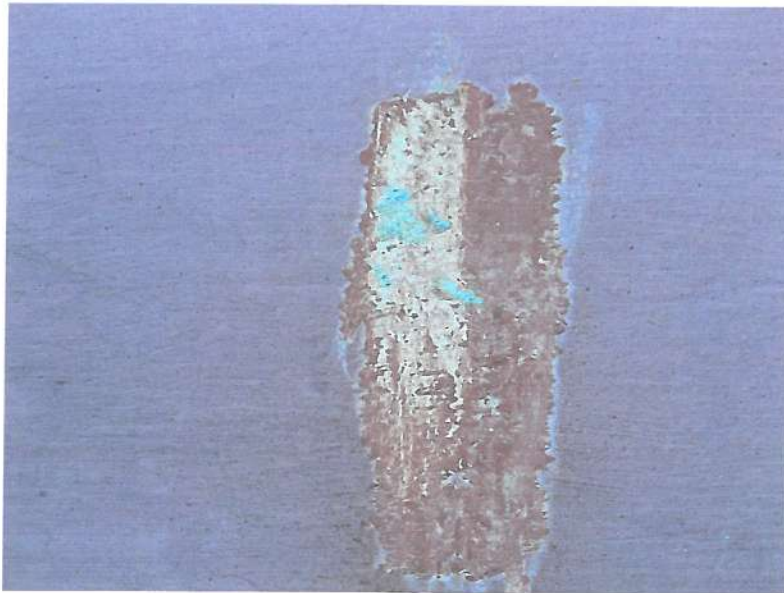
Fot. nr 56. Odkrywka na balustradzie balkonu na północnej ścianie w sali widowiskowej. Widoczny jasnokremowa pobiała wapienna i ciemnoróżowy kolor.
