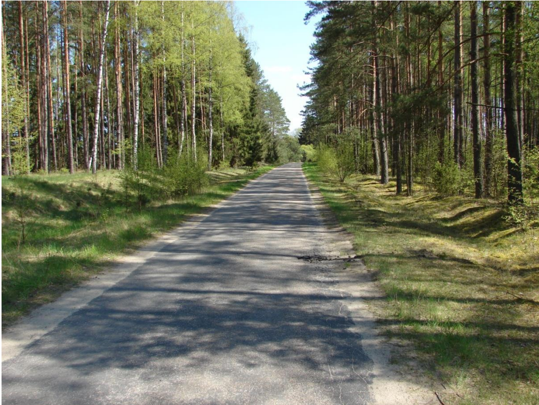
Fot.1 Odcinek początkowy drogi gminnej, widok od strony drogi powiatowej 1482N
