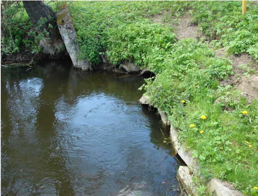
Fot.2 Przepust pod koroną drogi gminnej na rzece Nowy Dwór
