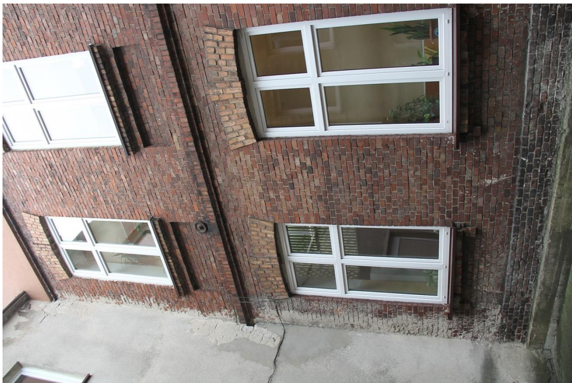
Fot. 1 Zespół Szkół nr 1 im. Stanisława Staszica ul. Górnicza 12 Olkusz. Elewacja tylna, budynku głównego.
