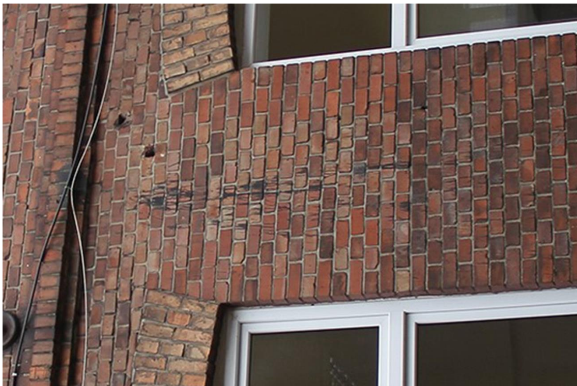
Fot. 9 Zespół Szkół nr 1 im. Stanisława Staszica ul. Górnicza 12 Olkusz. Elewacja tylna, budynku głównego.
