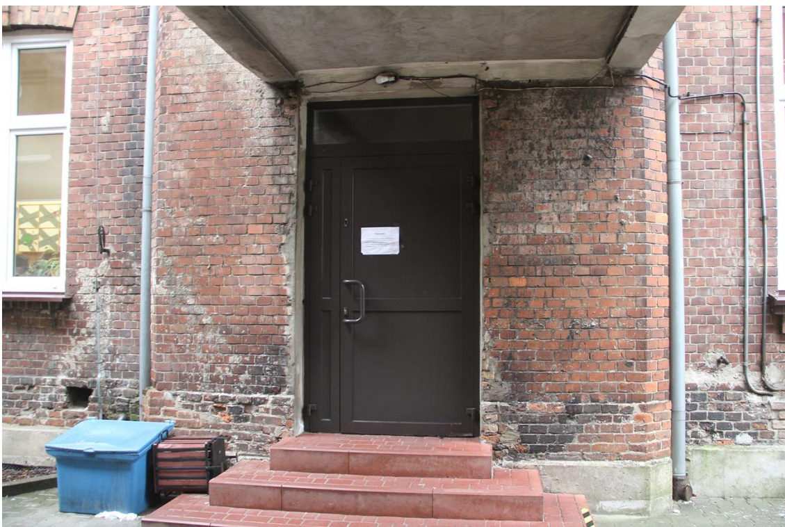
Fot. 8 Zespół Szkół nr 1 im. Stanisława Staszica ul. Górnicza 12 Olkusz. Elewacja tylna, budynku głównego.
