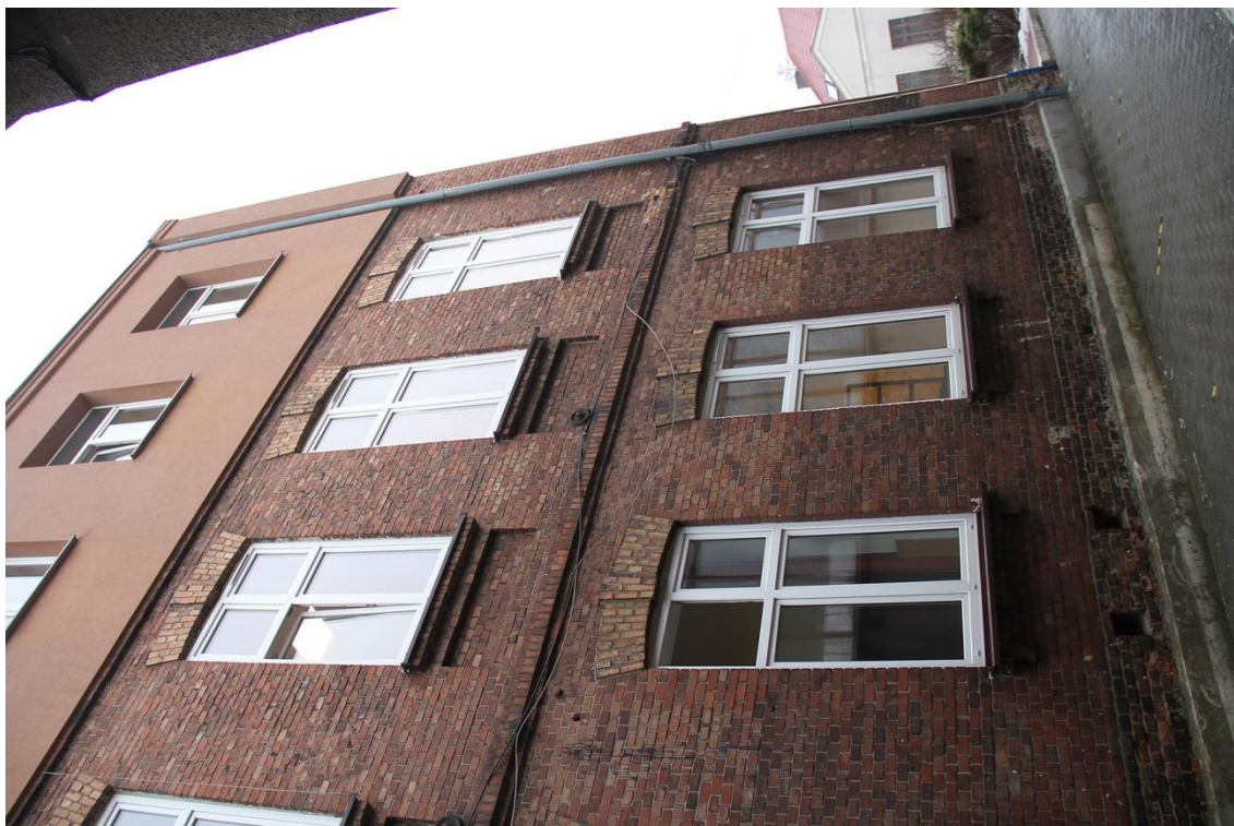
Fot. 4 Zespół Szkół nr 1 im. Stanisława Staszica ul. Górnicza 12 Olkusz. Elewacja tylna, budynku głównego.
