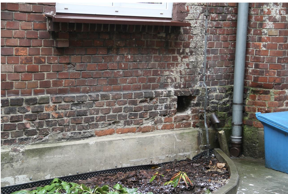
Fot. 6 Zespół Szkół nr 1 im. Stanisława Staszica ul. Górnicza 12 Olkusz. Elewacja tylna, budynku głównego.
