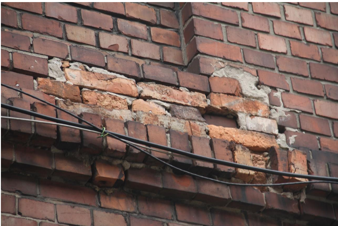
Fot. 7 Zespół Szkół nr 1 im. Stanisława Staszica ul. Górnicza 12 Olkusz. Elewacja tylna, budynku głównego.
