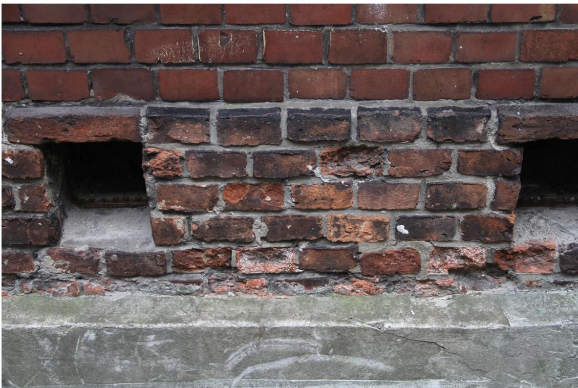
Fot. 5 Zespół Szkół nr 1 im. Stanisława Staszica ul. Górnicza 12 Olkusz. Elewacja tylna, budynku głównego.
