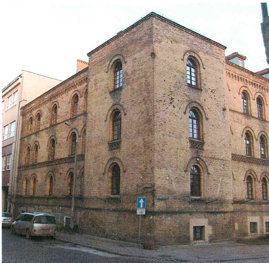
Elewacja zachodnia - stan obecny.
