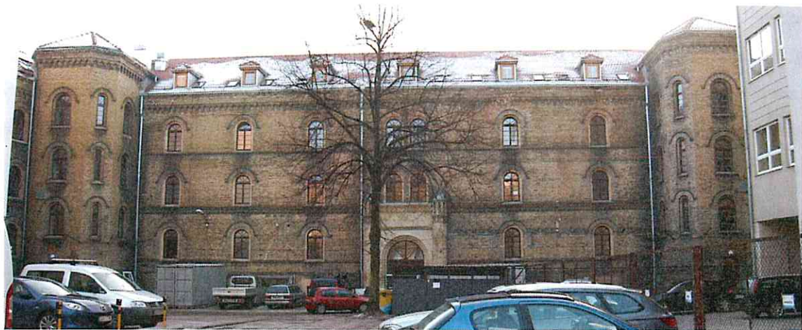
Widok elewacji północnej - stan obecny.
