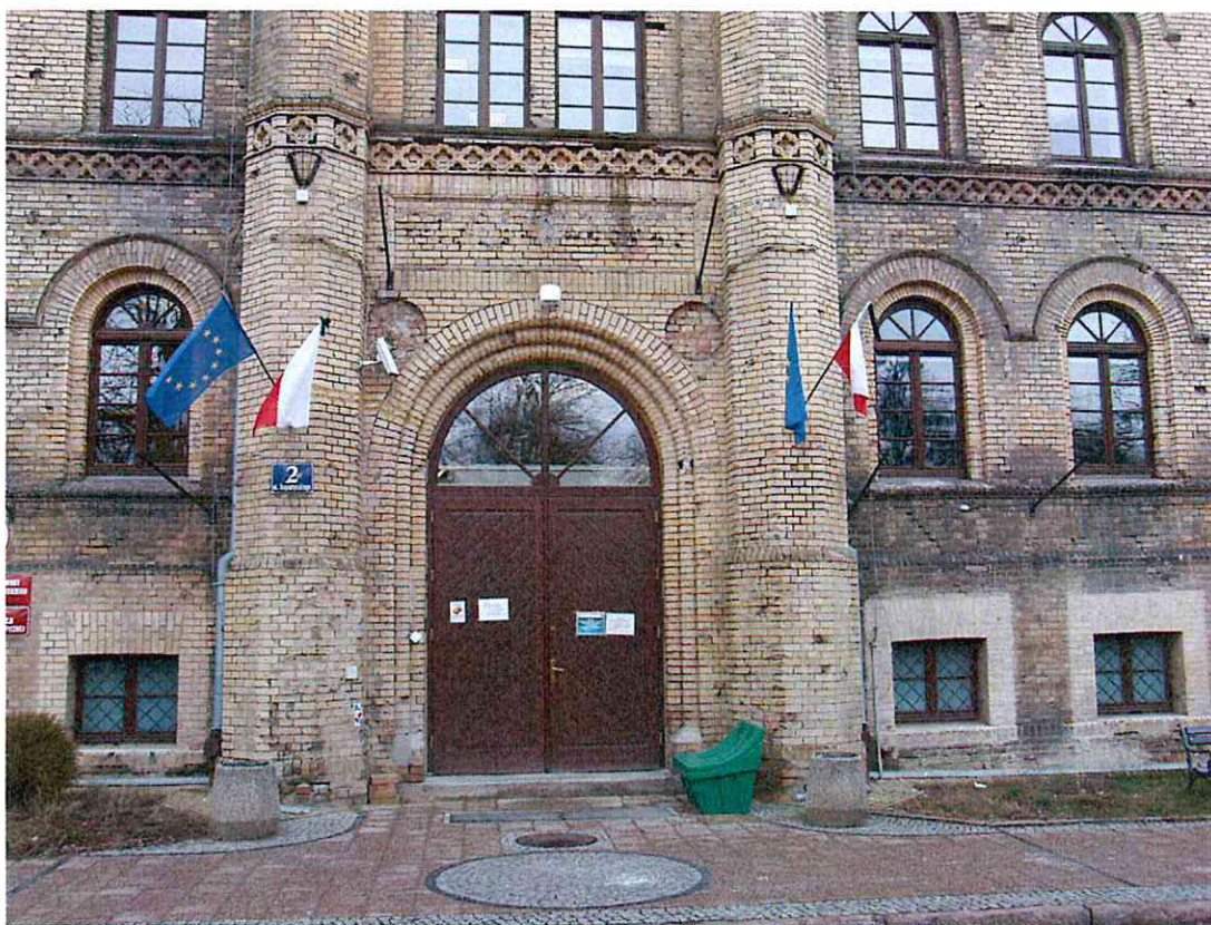
32. Wejście główne w ryzalicie centralnym.
