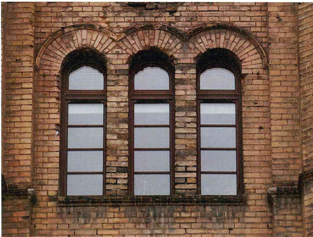
31. Triforium okienne w ryzalicie centralnym.
