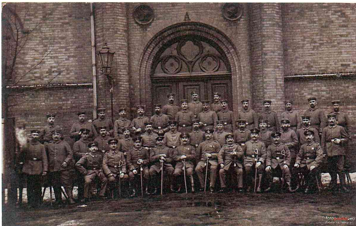
12. Przepuszczalnie elewacja południowa lub północna, wejście główne. 1915-16 rok.
