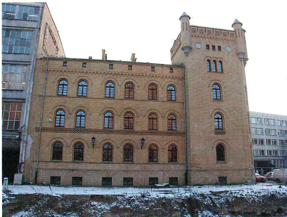
Zachowany w niemal pierwotnej formie fragment koszar Wiebego w narożu ulic Rzeźnickiej i Wilczej - stan obecny.
