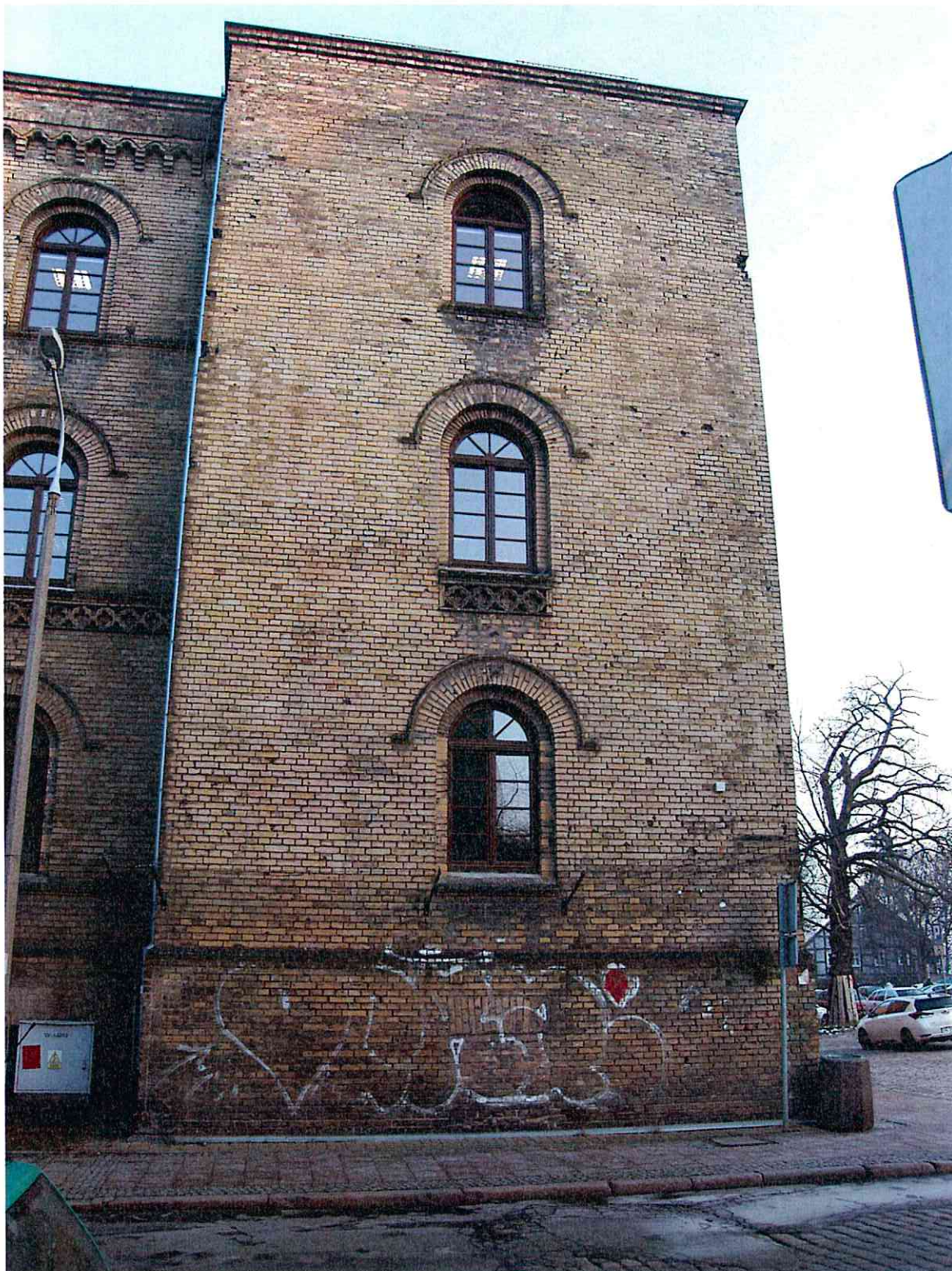
76. Ryzalit narożny. Widoczne zamurowane okno w strefie cokołowej.
