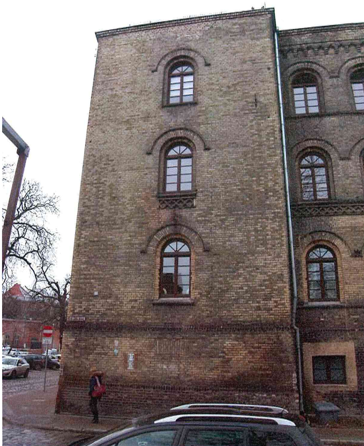
63. Ryzalit narożny. W strefie cokołowej widoczne zamurowane okno.
