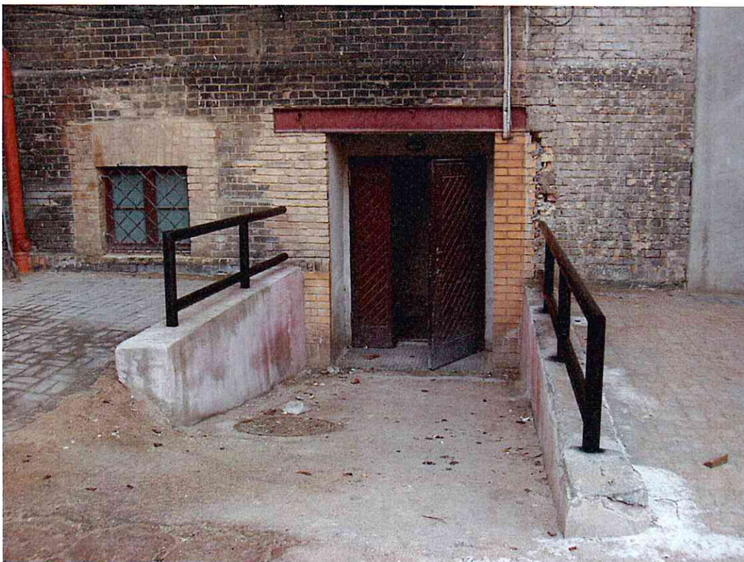
52. Wtóre wejście w I kondygnacji skrzydła zachodniego.
