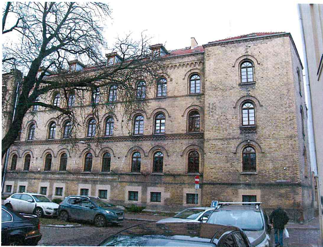
Elewacja południowa, skrzydło wschodnie - stan obecny.
