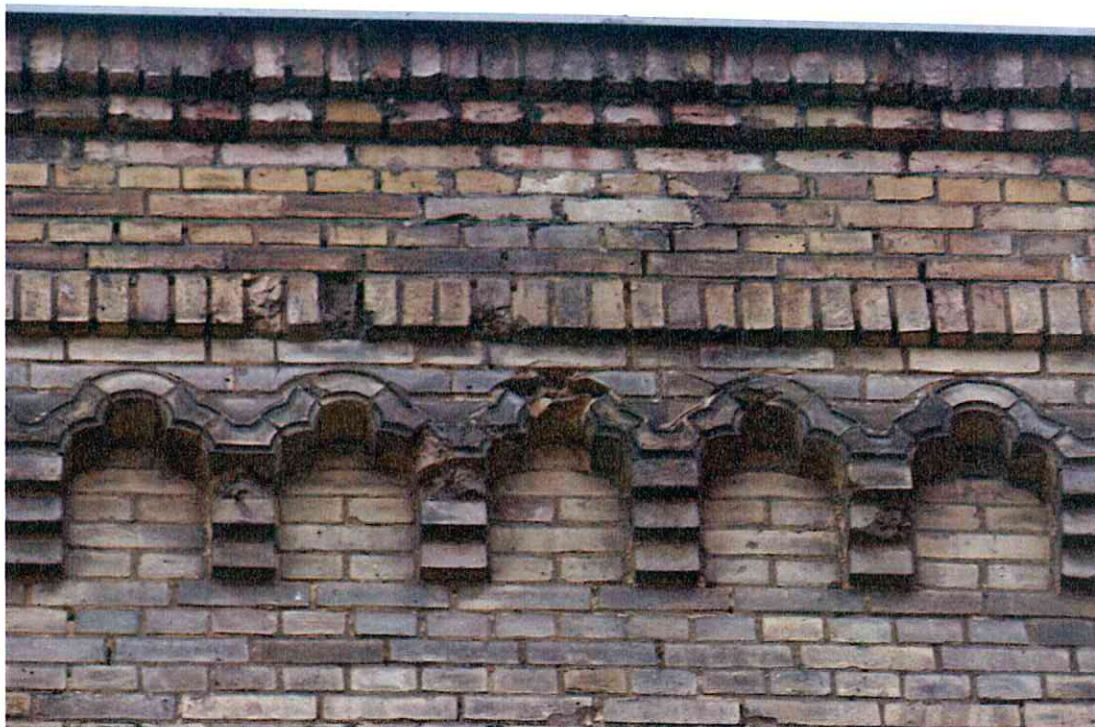
68. Stan gzymsu wieńczącego.
