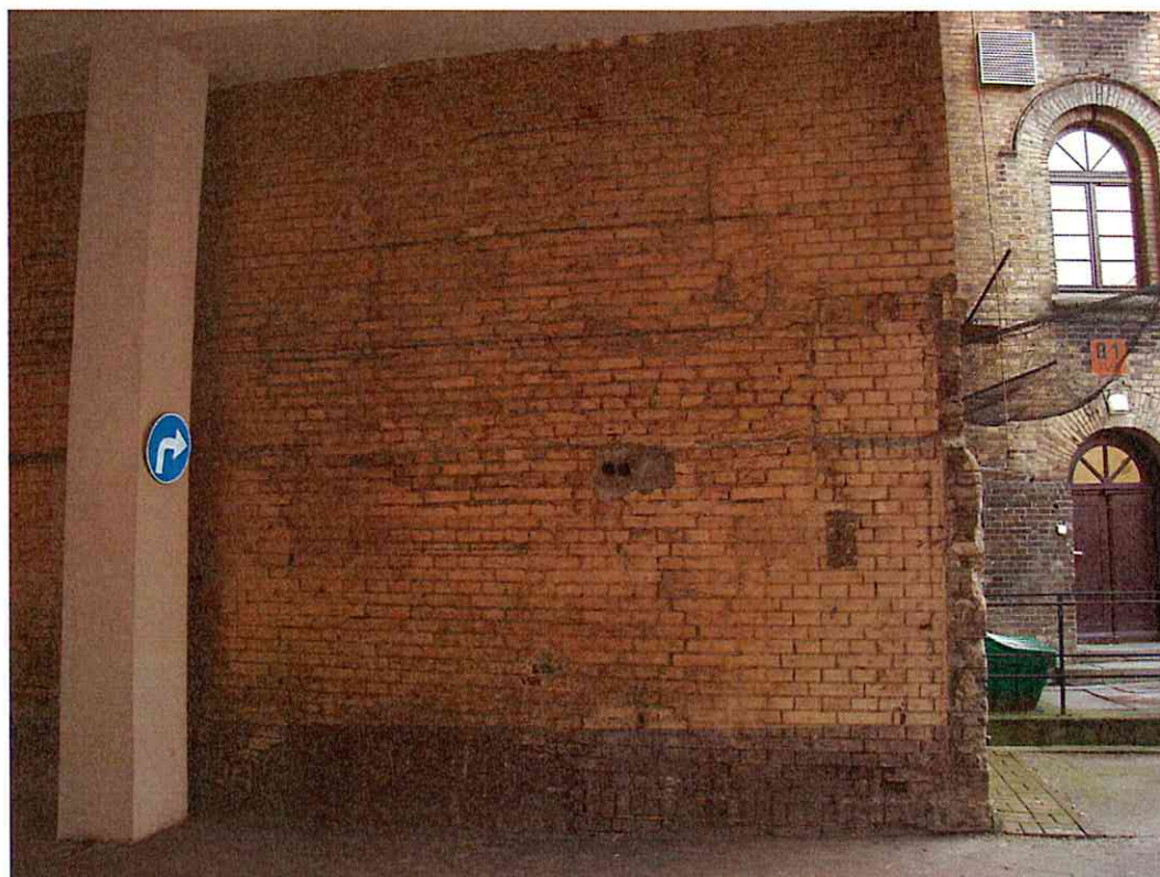
58. Prześło zachodnie, widoczne zamurowane okno.
