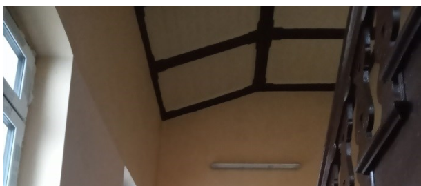
Fot. 25 Sufit na klatce do impregnacji
