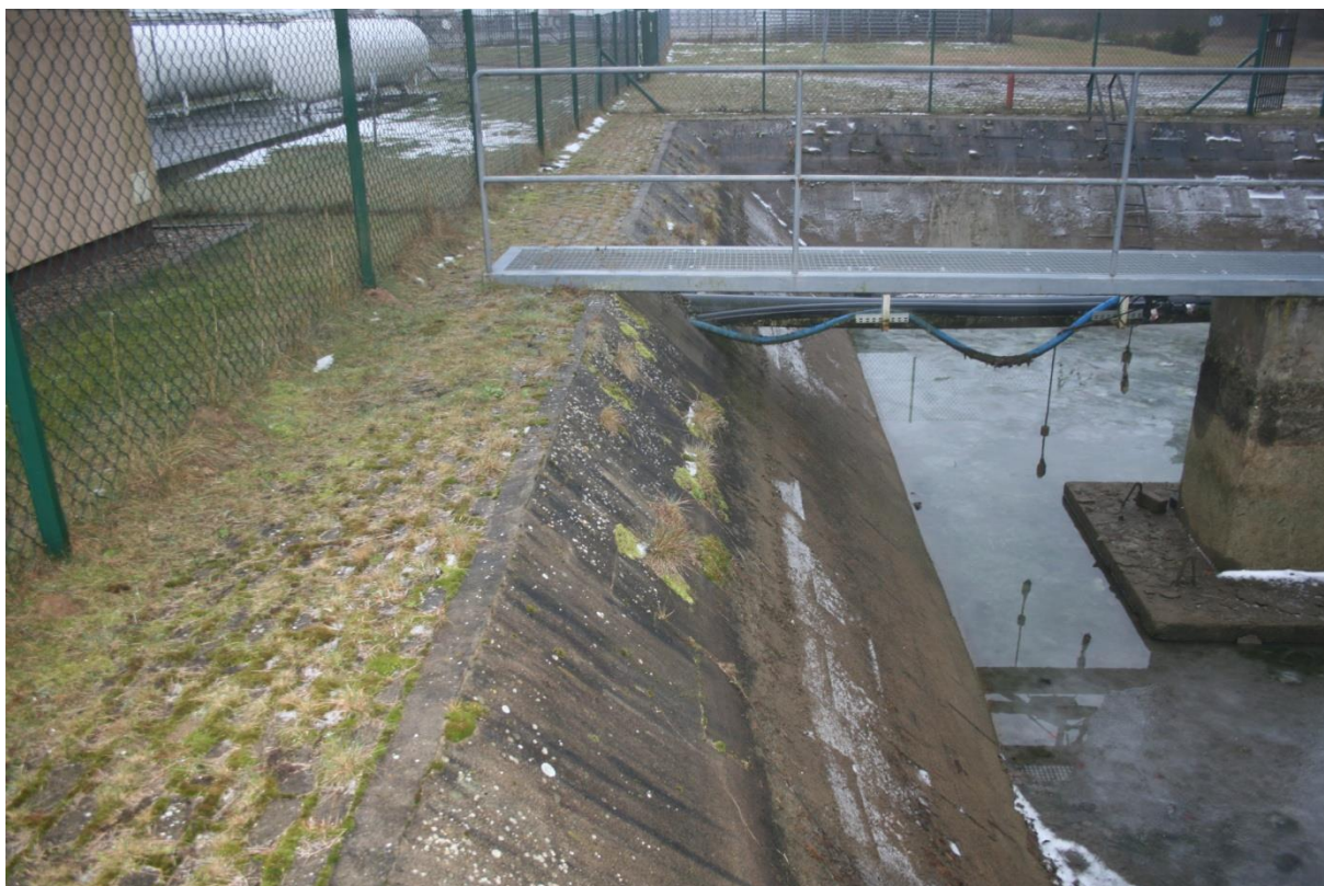
Zdjęcie 8 – Południowa ściana zbiornika
