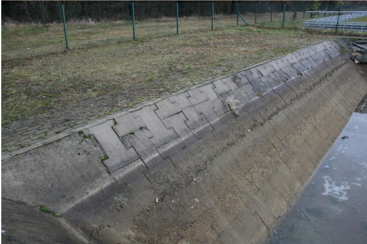
Zdjęcie 6 – Północna ściana zbiornika
