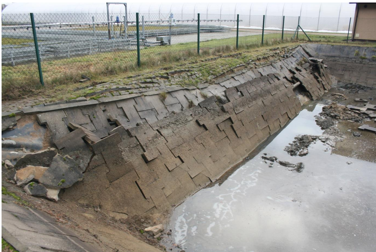
Zdjęcie 4 – Wschodnia ściana zbiornika
