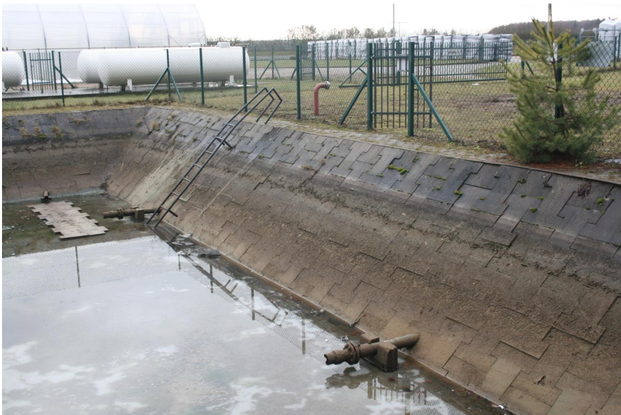
Zdjęcie 7 – Zachodnia ściana zbiornika
