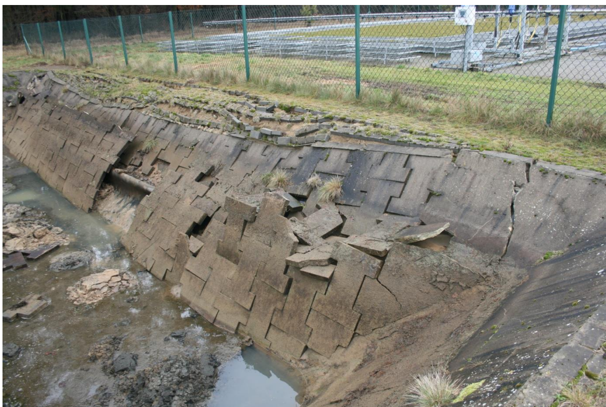
Zdjęcie 5 – Wschodnia ściana zbiornika
