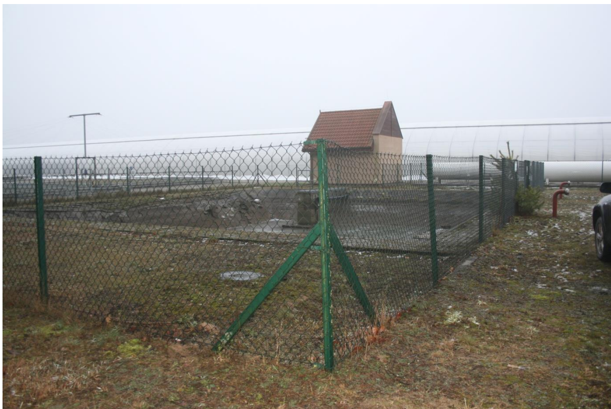
Zdjęcie 2 - Ogrodzenie zbiornika
