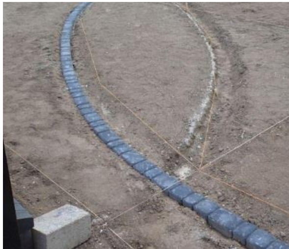
Fot. Opaska z kostki betonowej
