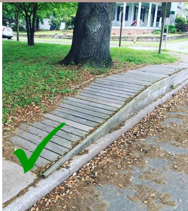
Chodnik podwieszany z drewna przy projektowanej różnicy wysokości
