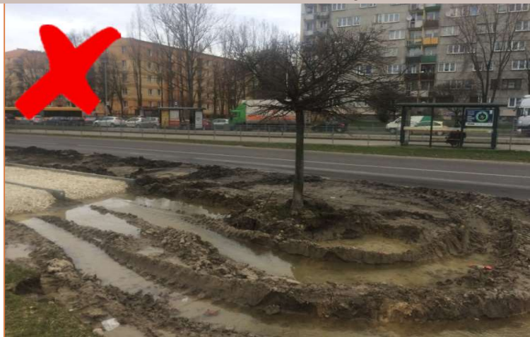
ZALANIE I ZAGĘSZCZENIE powoduje brak dostępu tlenu do korzeni i ich zamieranie
