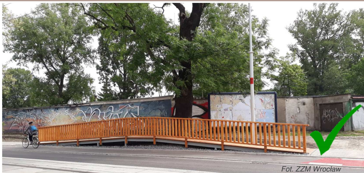
Chodnik podwieszany z drewna przy projektowanej różnicy wysokości
