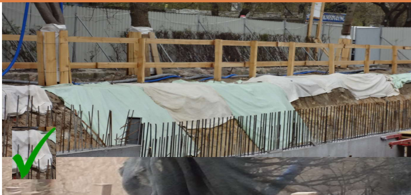
Ekran korzeniowy - zabezpieczenie ściany głębokiego wykopu w SOD matami, agrowłókniną itp.
