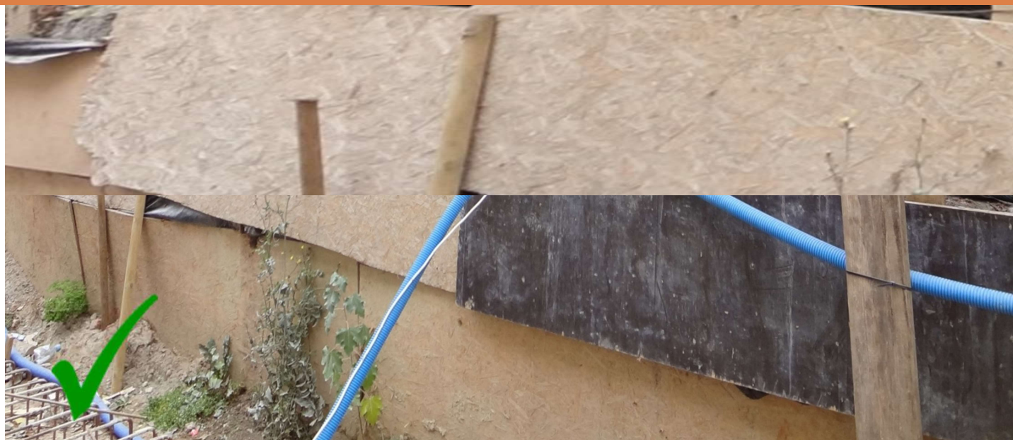
Ekran korzeniowy w płytkim wykopie: szalunek z desek ze strefą przejściową pomiędzy szalunkiem a ścianą wykopu z zabezpieczonymi korzeniami.
