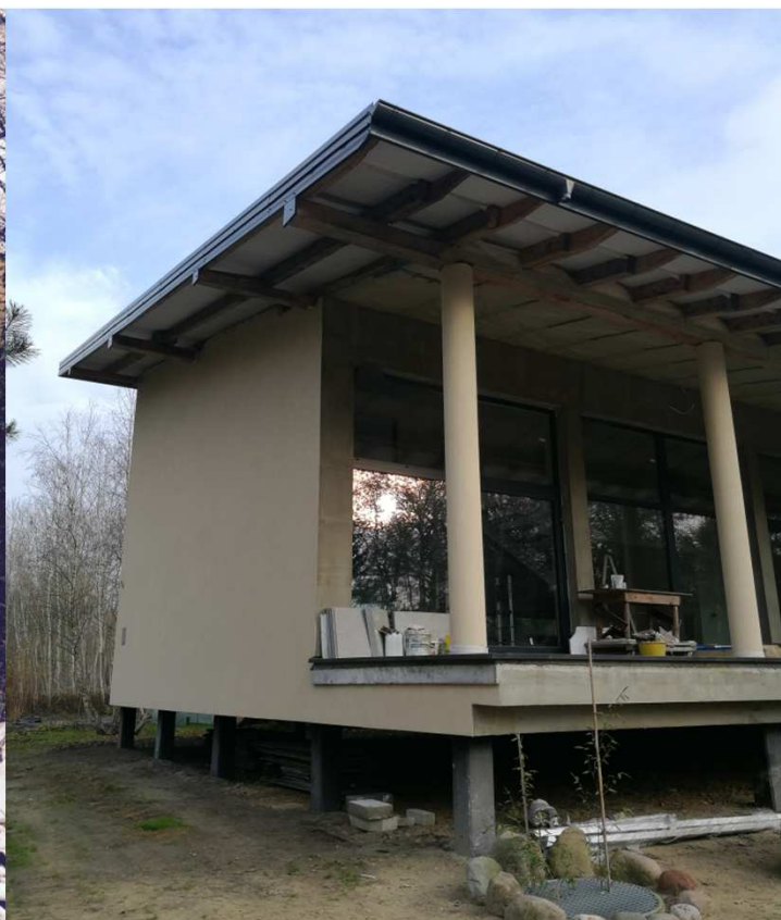
Domy na konstrukcjach punktowych jako bezkolizyjne rozwiązanie w SOD
