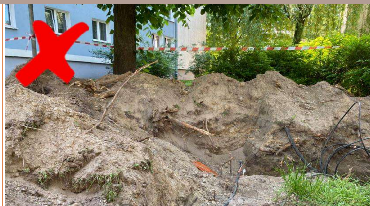
NASYPANIE WARSTWY GLEBY powoduje ograniczenie dostępu tlenu do korzeni i ich zamieranie
