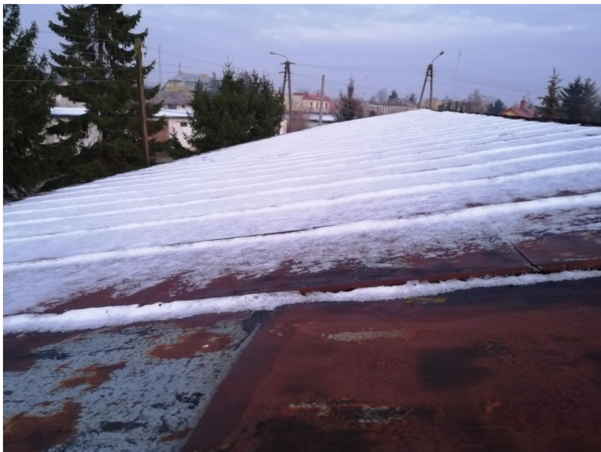
Fot. 9 Widok na skorodowane elementy pokrycia dachowego
