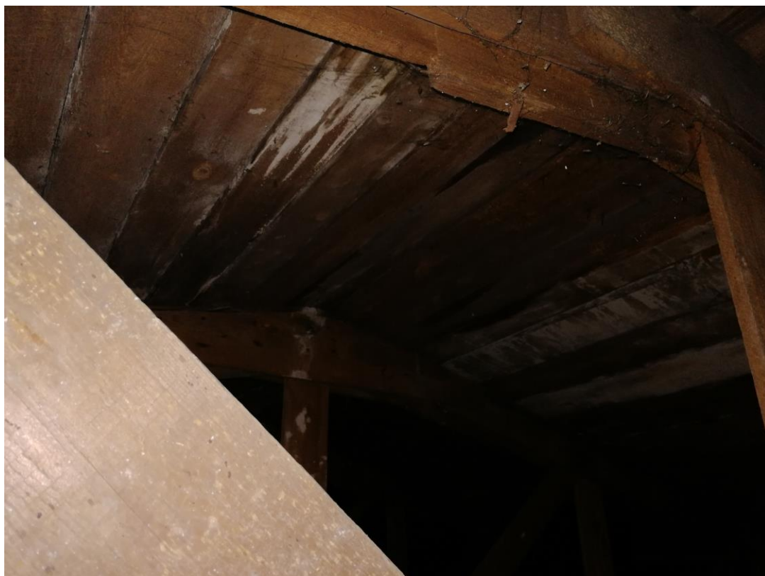
Fot. 9 Widok na skorodowane elementy pokrycia dachowego
