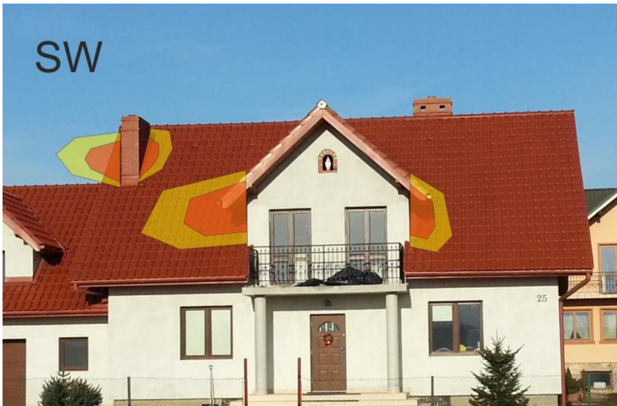
Rysunek 7 Strefy zacielenia na dachu skierowanym na południowy zachód
