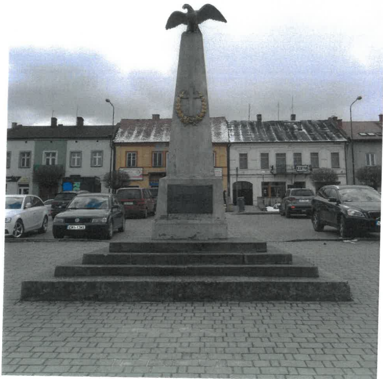
Widok obiektu od strony frontowej. Pomnik ustawiony na trzech stopniach z piaskowca i betonowej stopie.
