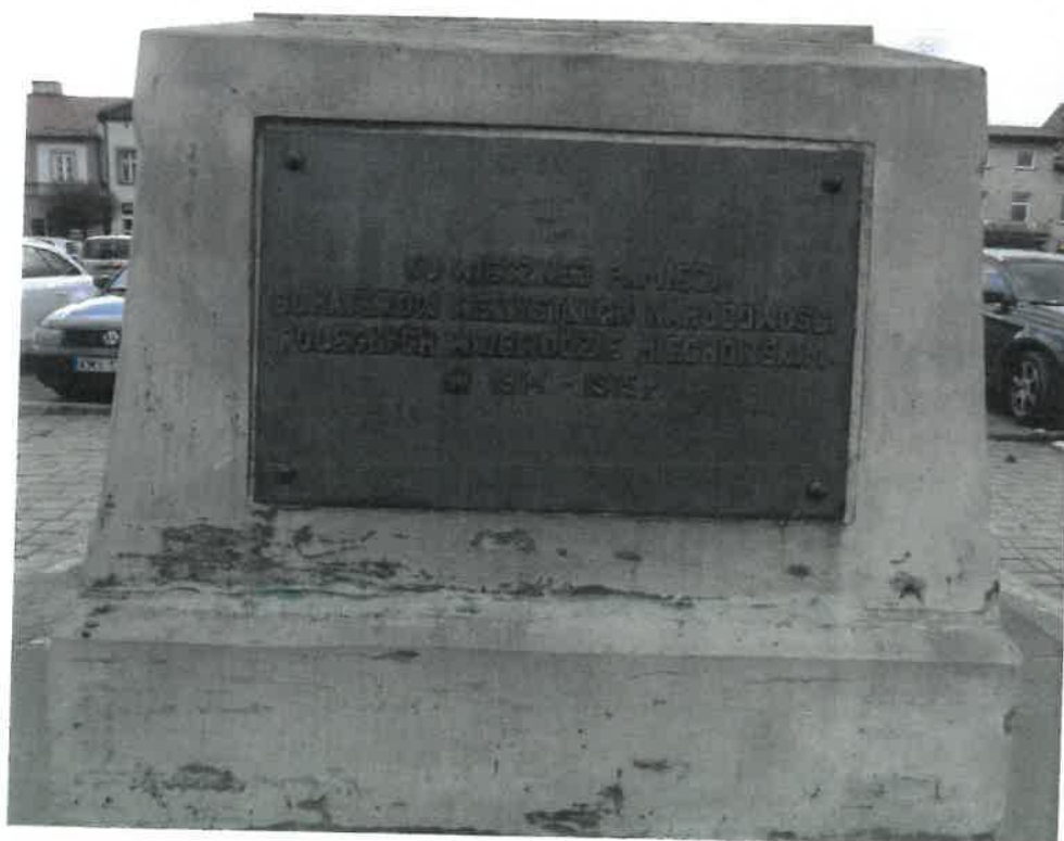
Zbliżenie cokołu pomnika. Widoczne tablice z brązu z inskrypcjami. Tablice pokryte warstwą patyny. Na powierzchni kamienia zielone zaplamienia Powstałe na wskutek korozji metalu.
