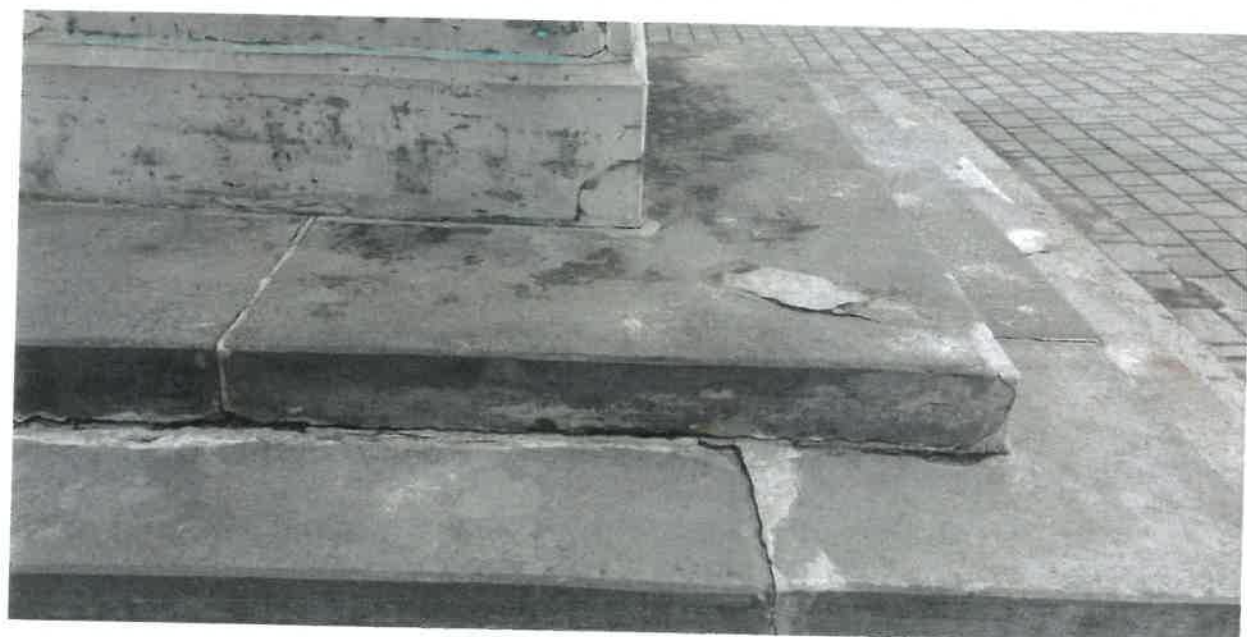
Zbliżenie cokołu i stopni pomnika. Powierzchnia pomnika zeszlifowana. Widoczne niedoczyszczone ślady patyny oraz zaplamienia powstałe z powodu korozji tablic metalowych. Zniszczone stopnie podstawy uzupełniano kitami mineralnymi.
