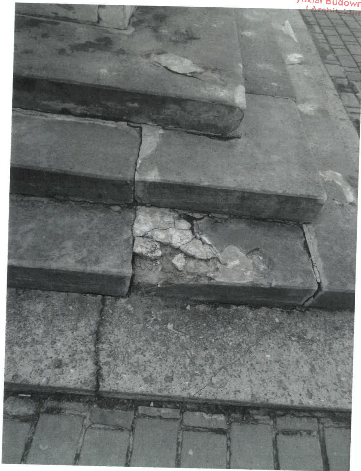
Zbliżenie stopni podstawy pomnika. Piaskowiec pokryty warstwą patyny oraz mchów. Ubytki mechaniczne kamienia uzupełnione kitami, zniszczone fugowanie, opaska cementowa popękana.
