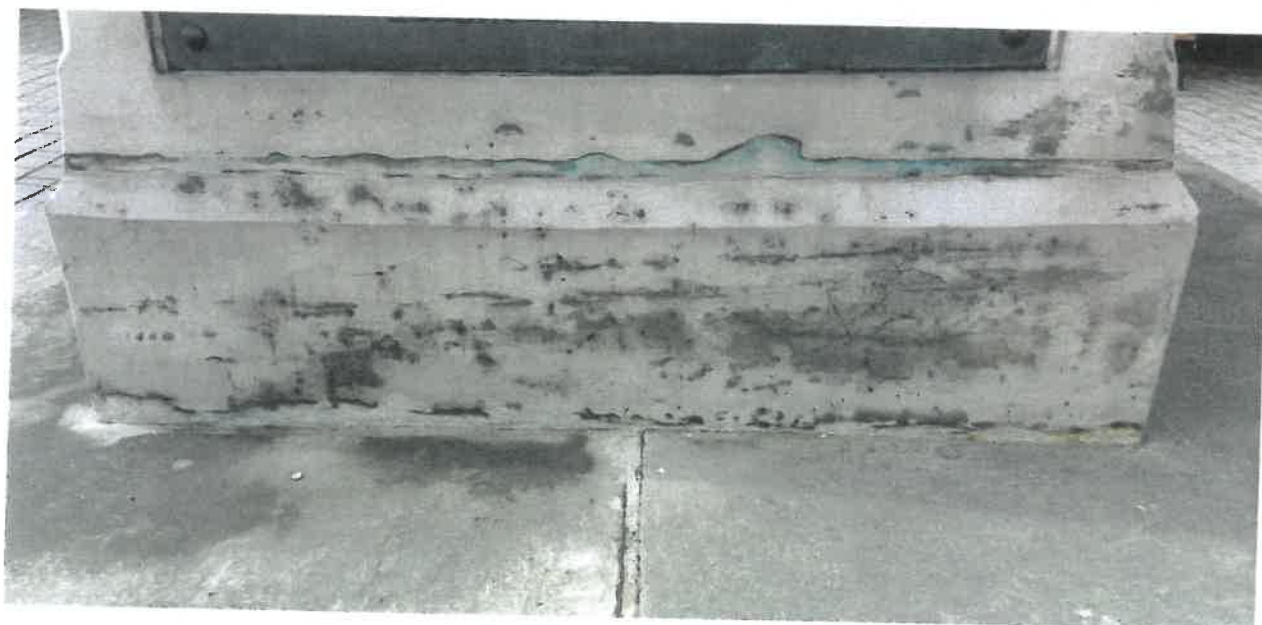
Zbliżenie cokołu pomnika. Powierzchnia piaskowca zeszlifowana. Widoczne niedoczyszczone ślady patyny oraz zaplamienia powstałe z powodu korozji tablic metalowych oraz ubytki mechaniczne.
