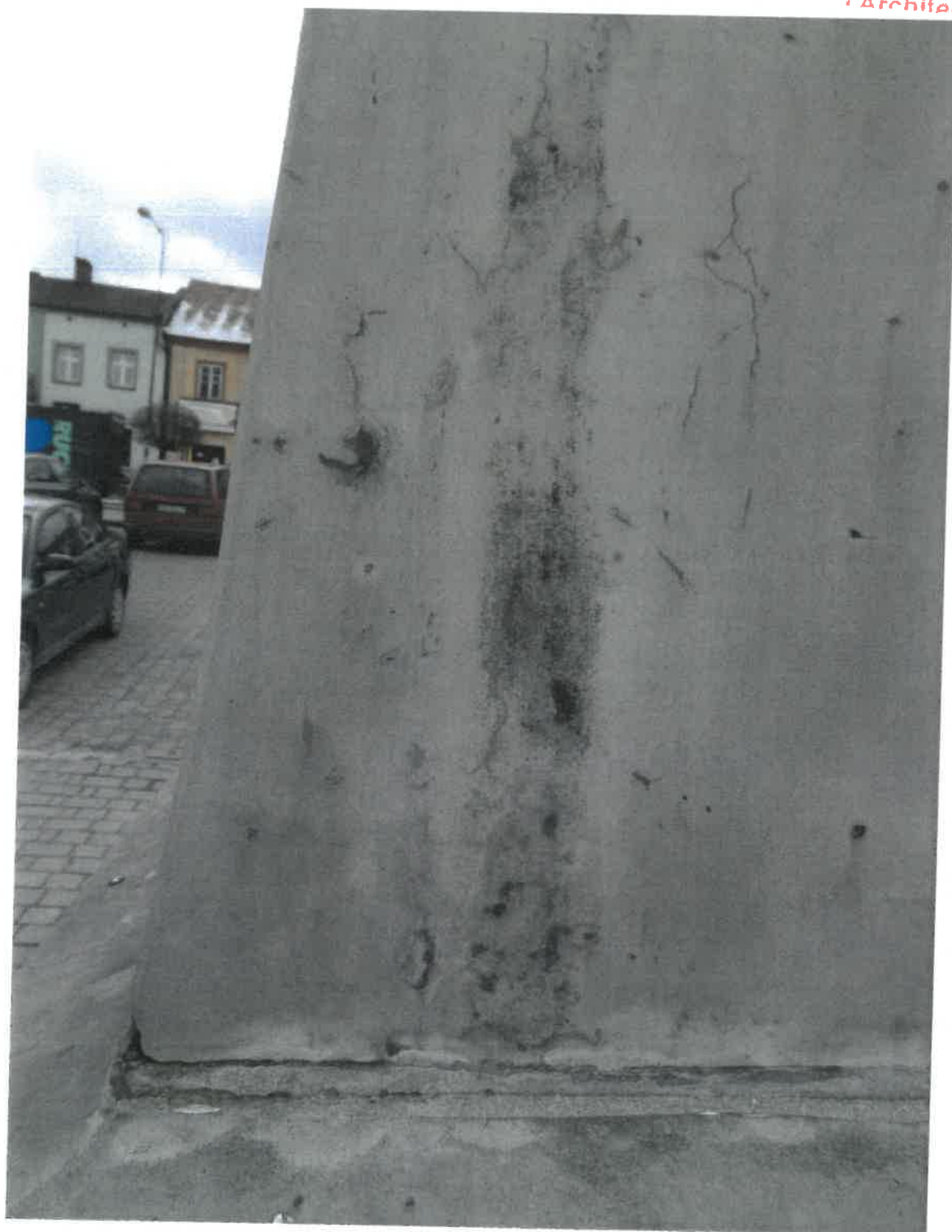
Zbliżenie cokołu pomnika. Powierzchnia piaskowca zeszlifowana. Widoczne niedoczyszczone ślady patyny oraz zaplamienia powstałe z powodu korozji tablic metalowych, zniszczone fugowanie.
