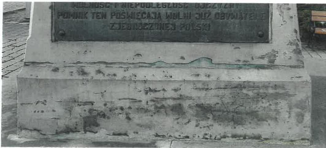
Powierzchnia kamienia zeszlifowana, ślady zaplamień po produktach korozji
