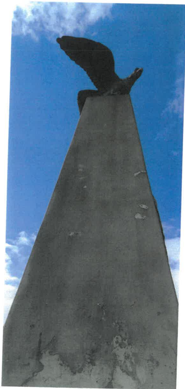
Zbliżenie prawej strony pomnika. Powierzchnia pomnika zeszlifowana. Ubytki na powierzchni uzupełniane kitami mineralnymi
