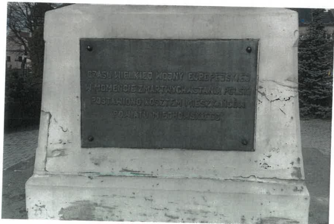
Zbliżenie cokołu pomnika. Widoczne tablice z brązu z inskrypcjami. Tablice pokryte warstwą patyny. Na powierzchni kamienia zielone zaplamienia Powstałe na wskutek korozji metalu.
