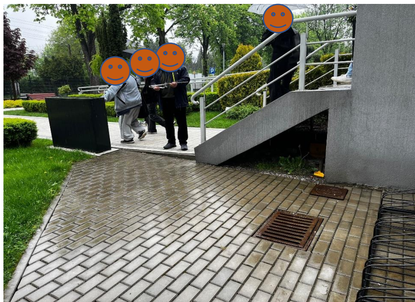
Fot. 2. Widok schodów wejściowych od strony bocznej – stan istniejący (widoczna przestrzeń do wypełnienia pod schodami)
