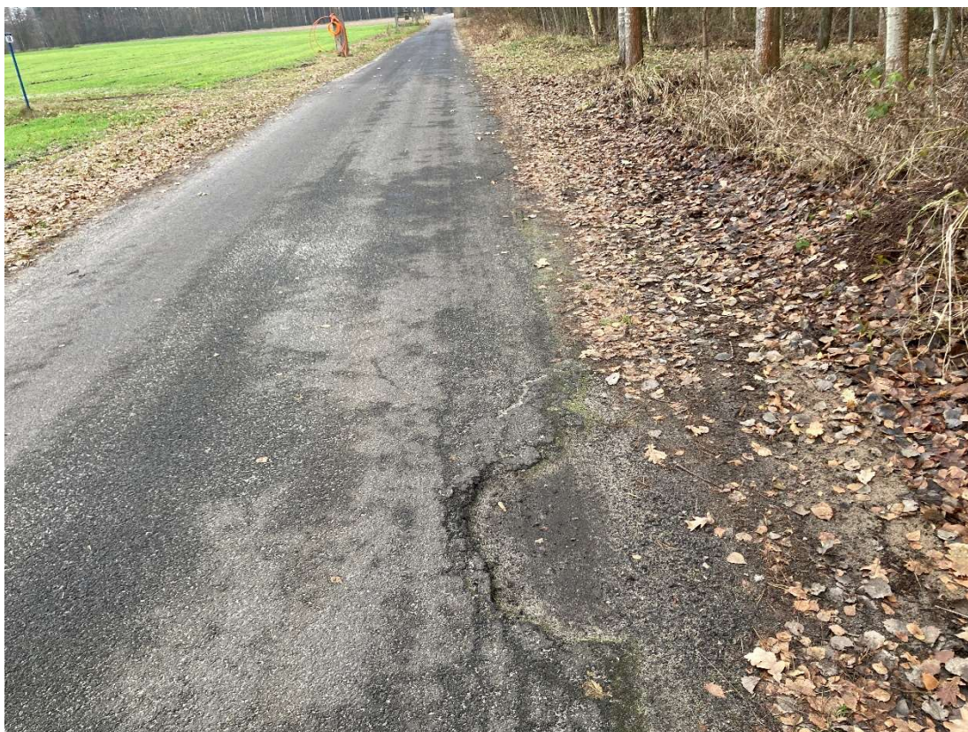
Fot. 4. Wskazanie losowego ubytku na odc. istniejącej nawierzchni drogi
