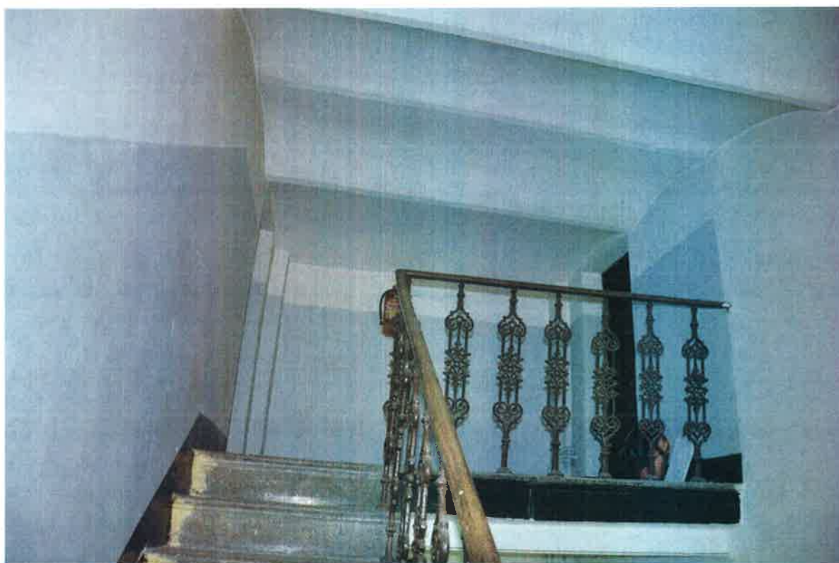
Fot. 18. Strop nad klatką schodową środkową
