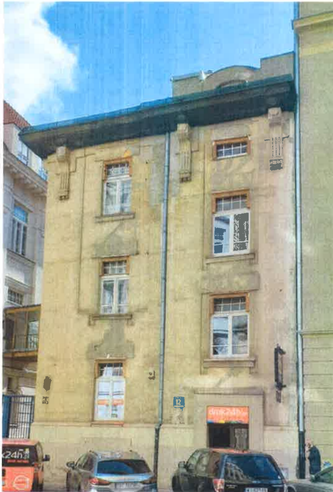
Fot. 1. Widok oficyny WAPW od strony ul. Lwowskiej
