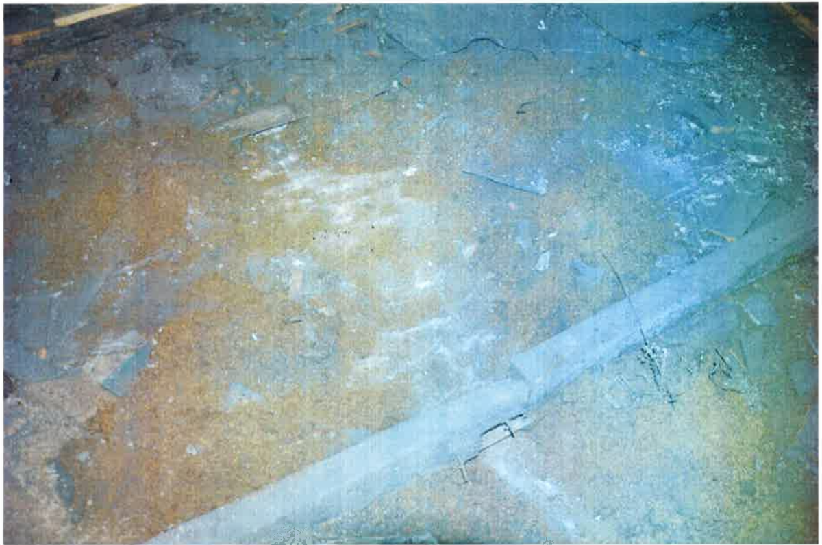
Fot. 47. Odkrywka stropu odcinkowego- poddasze zachodnie przy ścianie szczytowej
