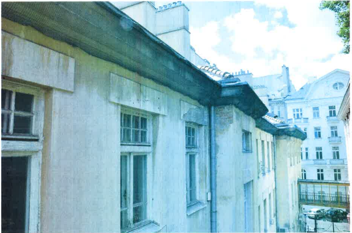
Fot. 67. Zabezpieczenie gzymsu siatką
