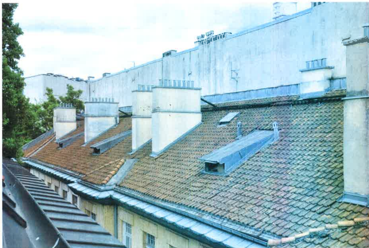
Fot. 49. Widok ogólny dachu
