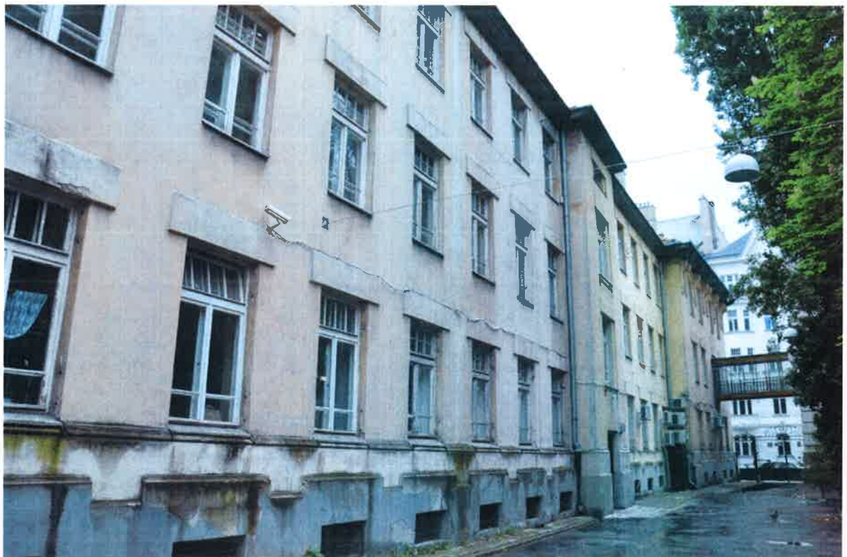
Fot. 2. Widok oficyny WAPW od strony dziedzińca
