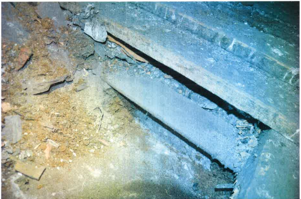
Fot. 46. Odkrywka stropu odcinkowego - poddasze wschodnie
