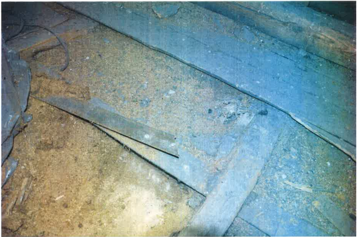
Fot. 43. Odkrywka belki stropu Hourdisa - poddasze zachodnie
