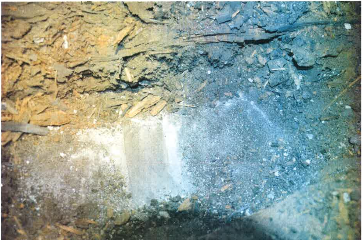
Fot. 44. Odkrywka stropu odcinkowego - poddasze zachodnie
