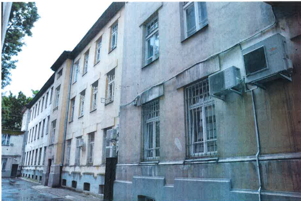
Fot. 3. Widok oficyny WAPW od strony dziedzińca
