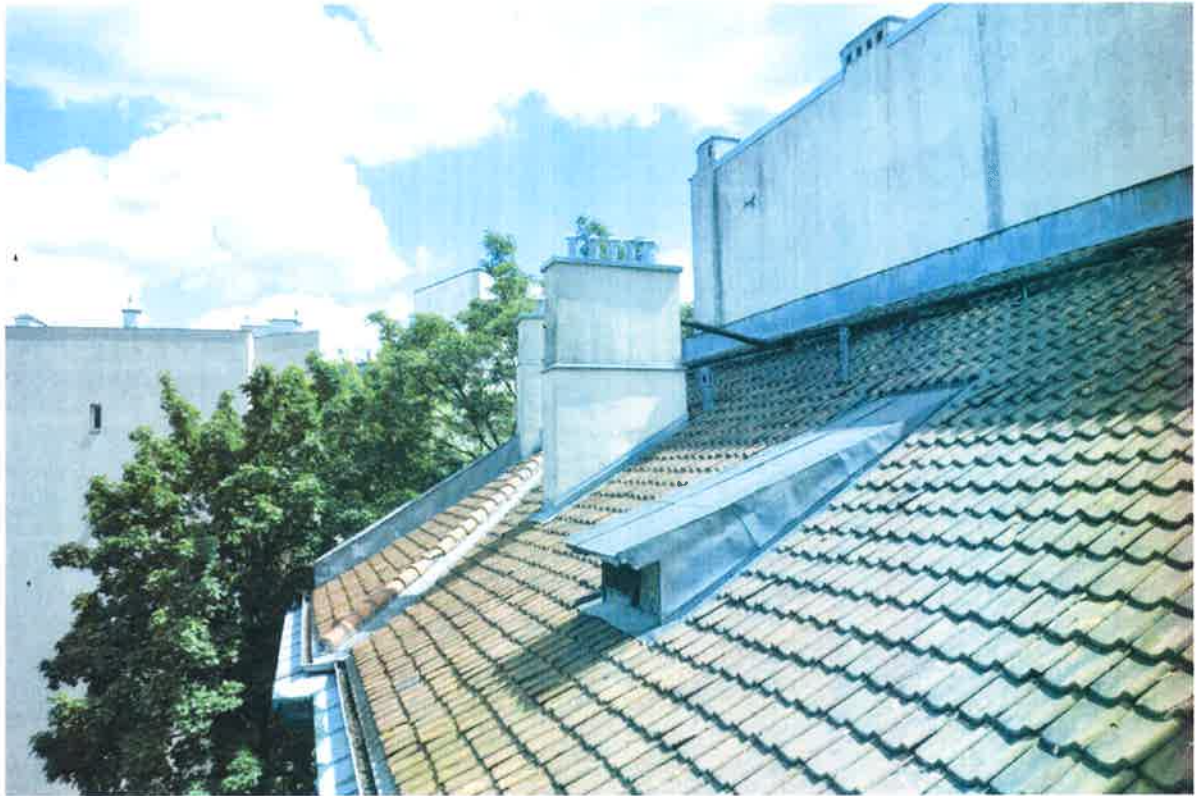
Fot. 51. Widok ogólny dachu
