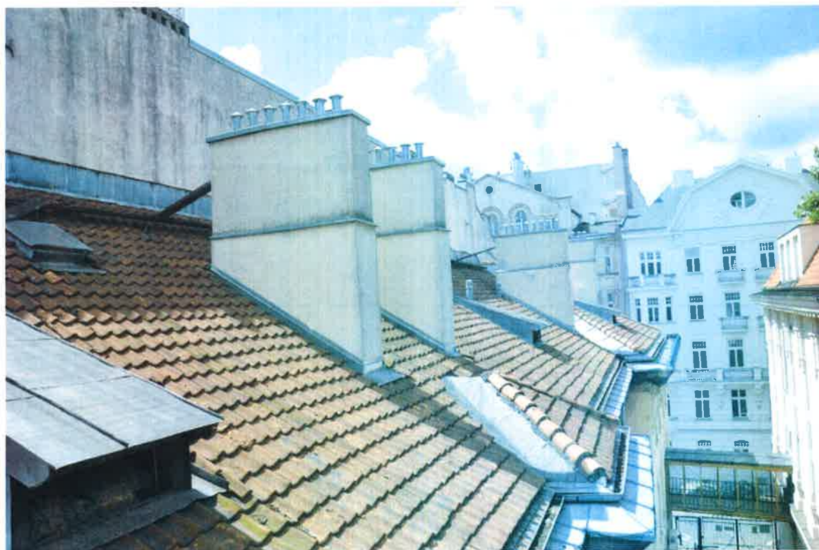
Fot. 50. Widok ogólny dachu
