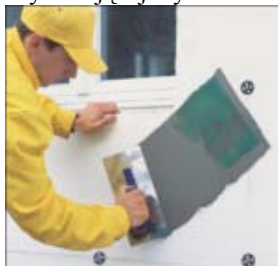
Fot. 5-7 Zabezpieczenie naroży budynku i krawędzi ościeży profilami metalowymi oklejonymi pasmem siatki i kontrolowanie geometrii płaszczyzny.
