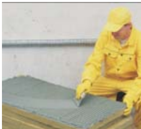
Fot. 2 Nakładanie zaprawy na płytę metodą grzebieniową
