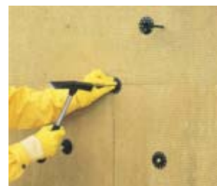
Fot. 4 Rozmieszczenie łączników mechanicznych powinno być symetryczne, o czym decyduje logika rozkładu sił grawitacyjnych montowanego układu ocieplenia.
