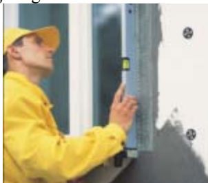
Fot. 5-7 Zabezpieczenie naroży budynku i krawędzi ościeży profilami metalowymi oklejonymi pasmem siatki i kontrolowanie geometrii płaszczyzny.
