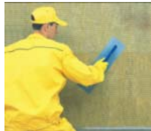
Fot. 3 Po nałożeniu zaprawy na płytę należy ją niezwłocznie przyłożyć do ściany i docisnąć uderzeniami drugiej pacy. Kolejno po sobie płyty przyklejane są ściśle jedna przy drugiej, w jednej płaszczyźnie, z zachowaniem mijankowego układu styków pionowych. W narożach budynku zachowuje się tzw. przewiązanie płyt
