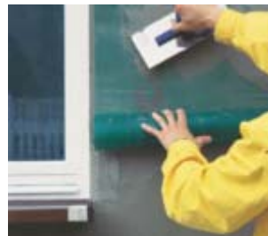
Fot. 5-7 Zabezpieczenie naroży budynku i krawędzi ościeży profilami metalowymi oklejonymi pasmem siatki i kontrolowanie geometrii płaszczyzny.
