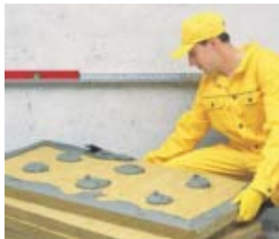
Fot. 1 Nakładanie zaprawy na płytę termoizolacyjną metodą obwodowo-plackową. Zaprawę nakłada się kielnią po obwodzie płyty pasmem o szer. 3-4 cm, a w jej centralnej części pozostawia kilka placków średnicy ok. 8 cm
