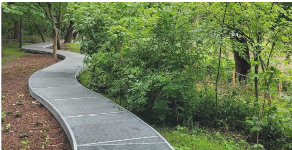
Fot. 26 Wyniesione trasy ponad teren ścieżki, z kraty pomostowej. Źródło ZZM Kraków
