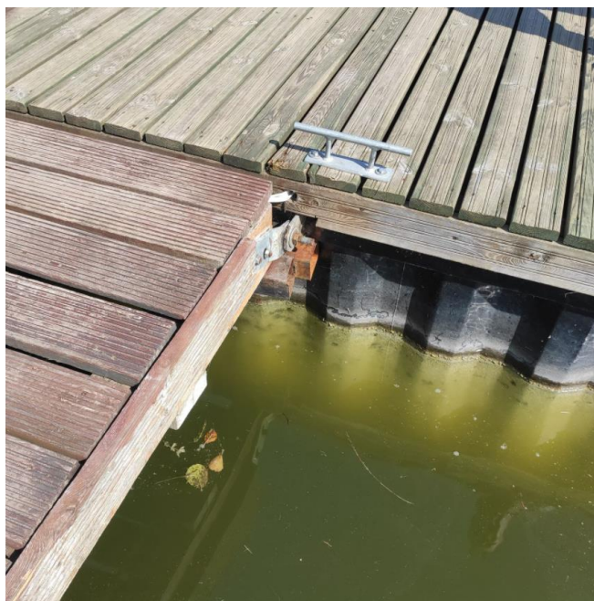
Fot. 4 Połączenie pomostu stałego z częścią pływającą, źródło własne
