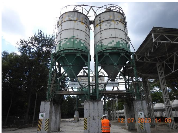
Fot. 85. Widok na silosy nr 7 i 8
