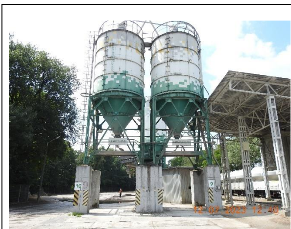
Fot. 109. Widok na silosy nr 9 i 10
