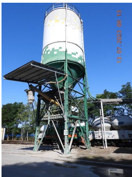
Fot. 145. Widok na silosy nr 13
