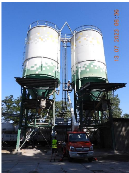
Fot. 121. Widok na silosy nr 11 i 12
