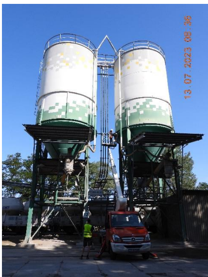
Fot. 133. Widok na silosy nr 11 i 12
