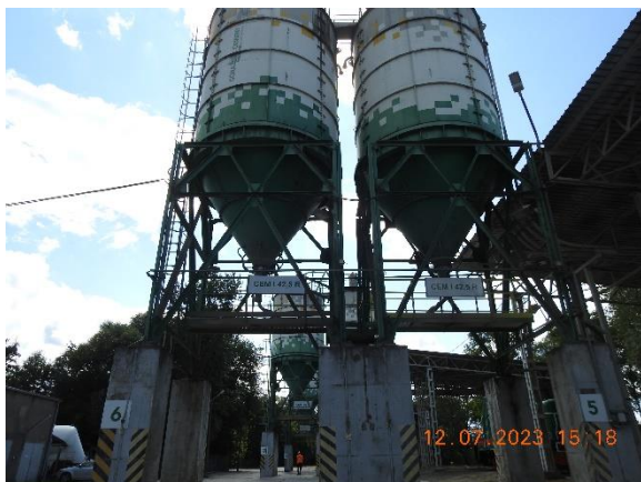
Fot. 61. Widok na silos nr 5 i 6
