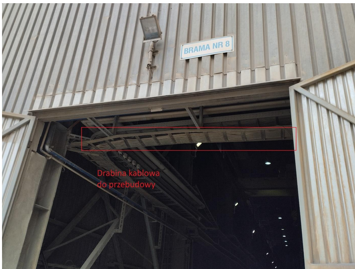
Rys.2 Drabina kablowa do przebudowy
