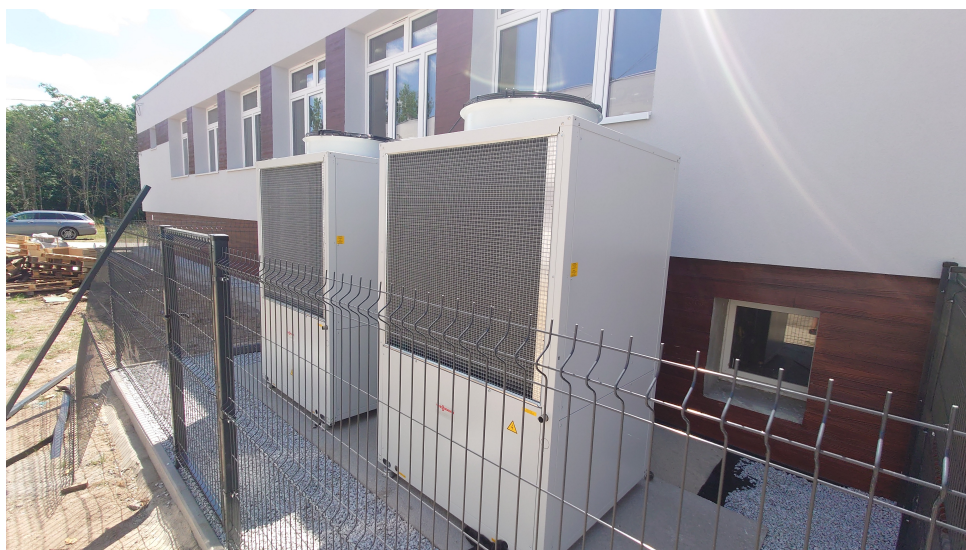
Fot. 3.18. Widok przykładowego montażu kaskady pomp ciepła.
