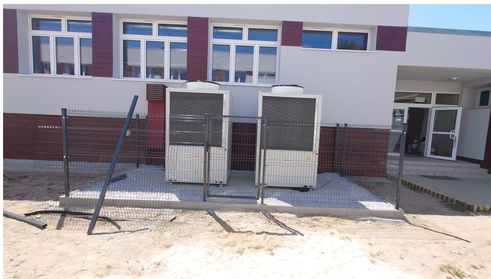
Fot. 3.17. Widok przykładowego montażu kaskady pomp ciepła.
