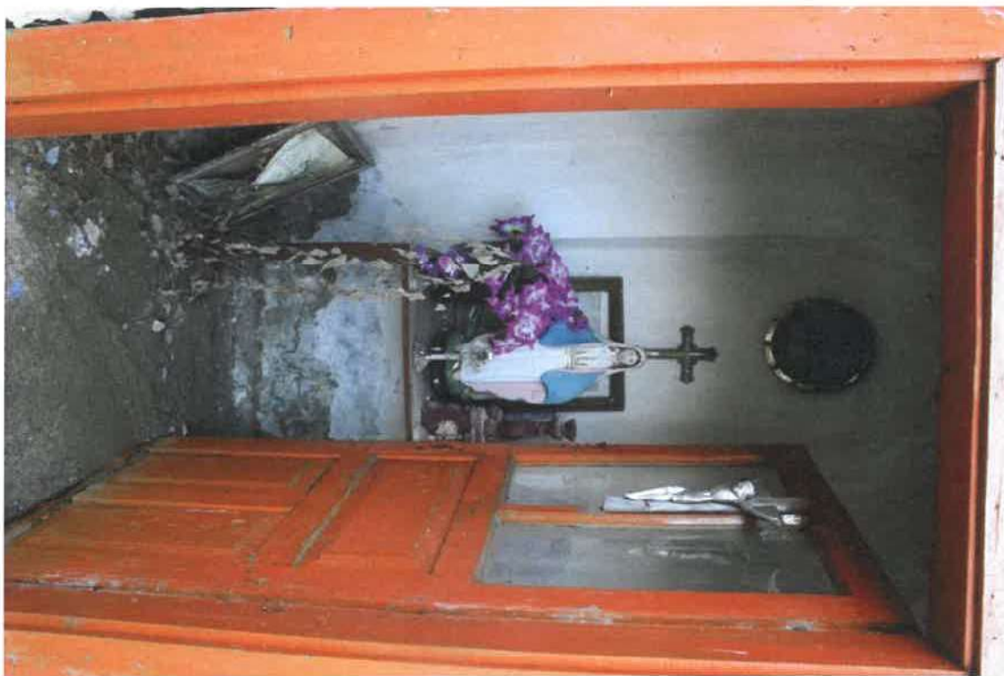
Fot. 37. – Kapliczka w Oparówce z drewnianymi świecznikami. Fragment elewacji południowej, widoczny otwór widoczne poprzednie opracowania malarskie oraz cegła przemalowane pobiałą po ubytkach. Dodatkowo zielone naloty mikrobiologiczne, szczególnie w dolnej części.
