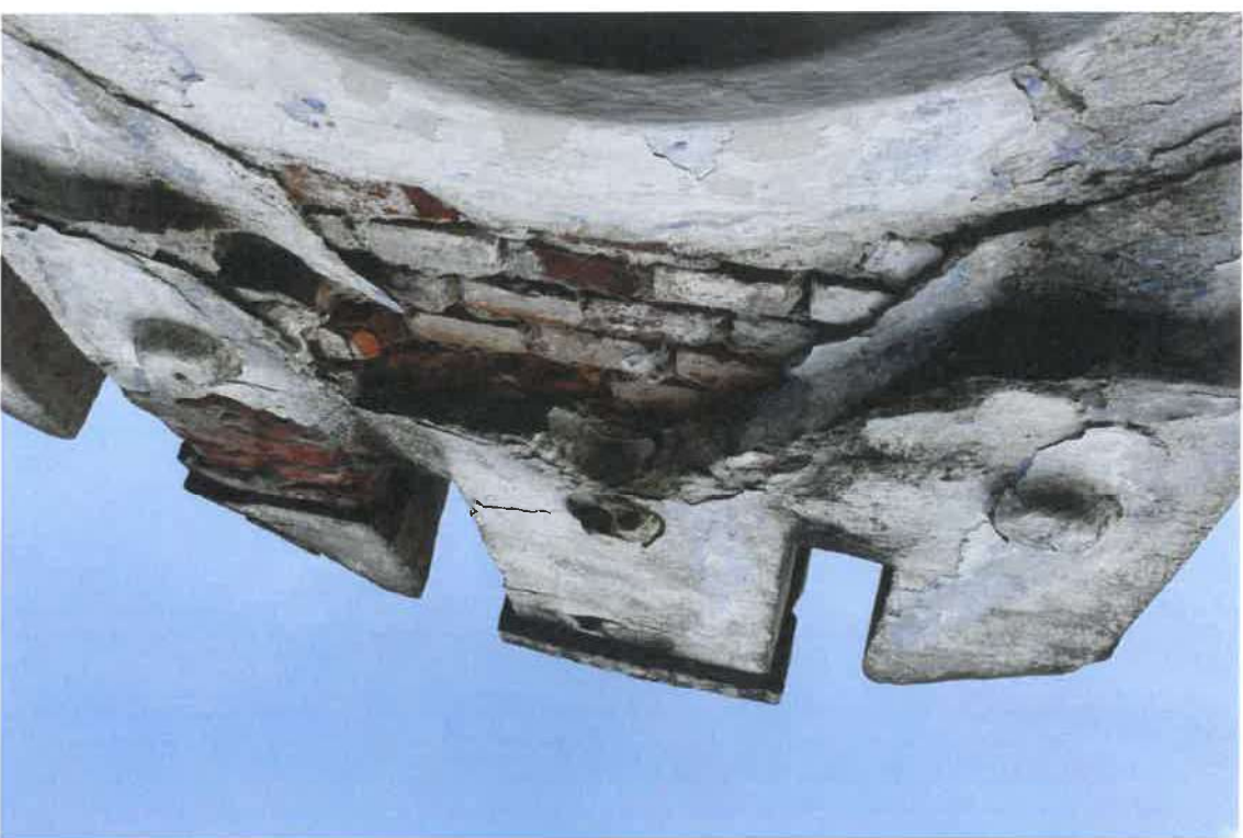
Fot. 25. – Kapliczka w Oparówce z Figurą Matki Bożej z Dzieciątkiem. Elewacja południowa. Zbliżenie na uszkodzenia i ubytki tynku. Widoczne poprzednie opracowania malarskie oraz cegła przemalowane pobiałą po ubytkach. Dodatkowo zielone naloty mikrobiologiczne. Tynk i sztukaterie w bardzo złym stanie.
