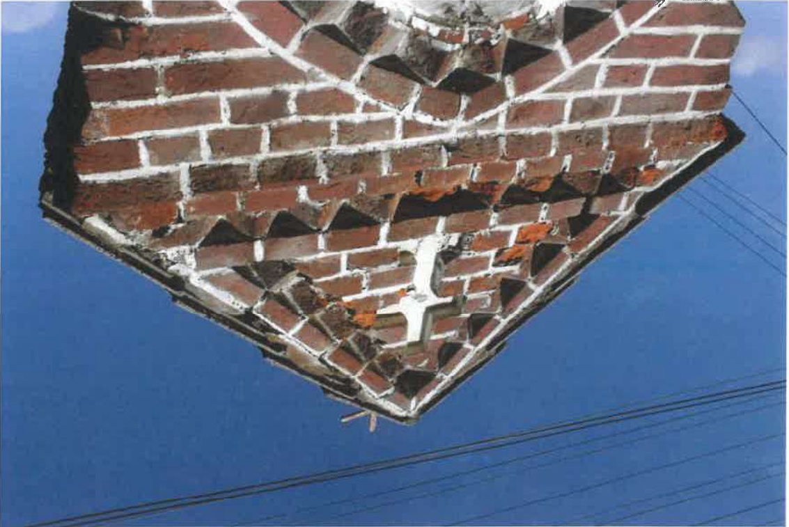
Fot. 5. – Kapliczka w Wisniowiej z rzezbą Świętego Kajetana, szczyt elewacji południowej. Widoczne ubytki w murowanej ścianie. Cegła krusząca się i pudrująca.
