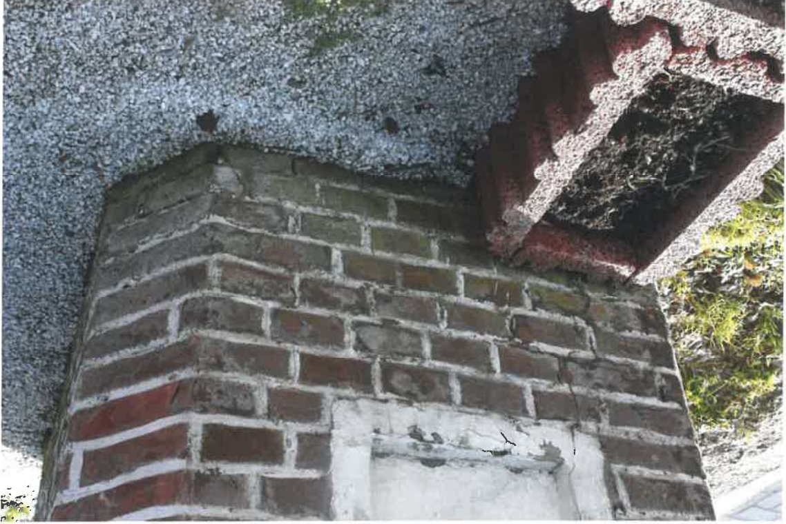
Fot. 5. – Kapliczka w Wisniowiej z rzezbą Świętego Kajetana, szczyt elewacji południowej. Widoczne ubytki w murowanej ścianie. Cegła krusząca się i pudrująca.
