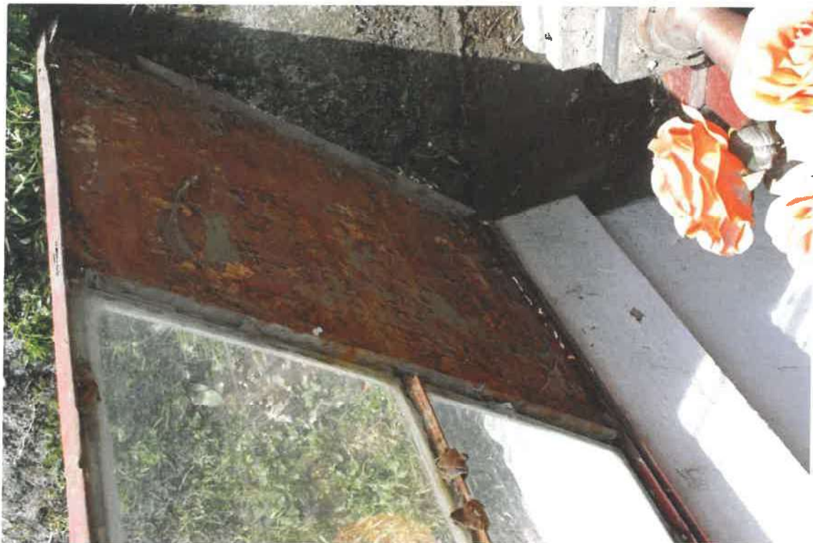
Fot. 7. – Kapliczka w Wisniowej z rzeźbą Świętego Kajetana, fragment elewacji południowej. Metalowe drzwi skorodowane z odspajającą się farbą. W dolnej części ściany spękania po rysunku spin. W górnej części portalu ubytki cegły oraz złuszczenia warstw białej farby.
