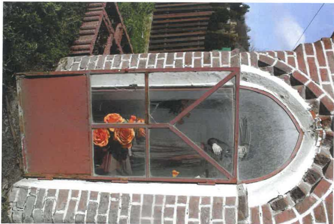
Fot. 7. – Kapliczka w Wisniowej z rzeźbą Świętego Kajetana, fragment elewacji południowej. Metalowe drzwi skorodowane z odspajającą się farbą. W dolnej części ściany spękania po rysunku spin. W górnej części portalu ubytki cegły oraz złuszczenia warstw białej farby.
