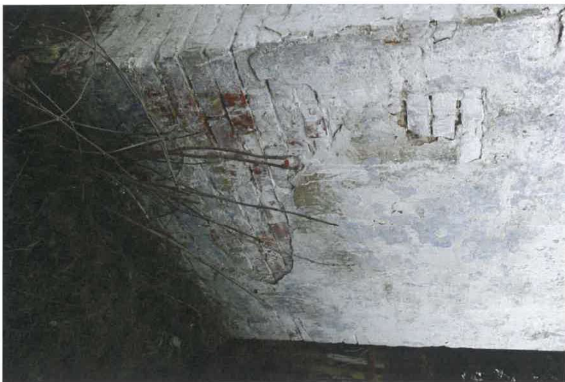
Fot. 37. – Kapliczka w Oparówce z drewnianymi świecznikami. Fragment elewacji południowej, widoczny otwór widoczne poprzednie opracowania malarskie oraz cegła przemalowane pobiałą po ubytkach. Dodatkowo zielone naloty mikrobiologiczne, szczególnie w dolnej części.
