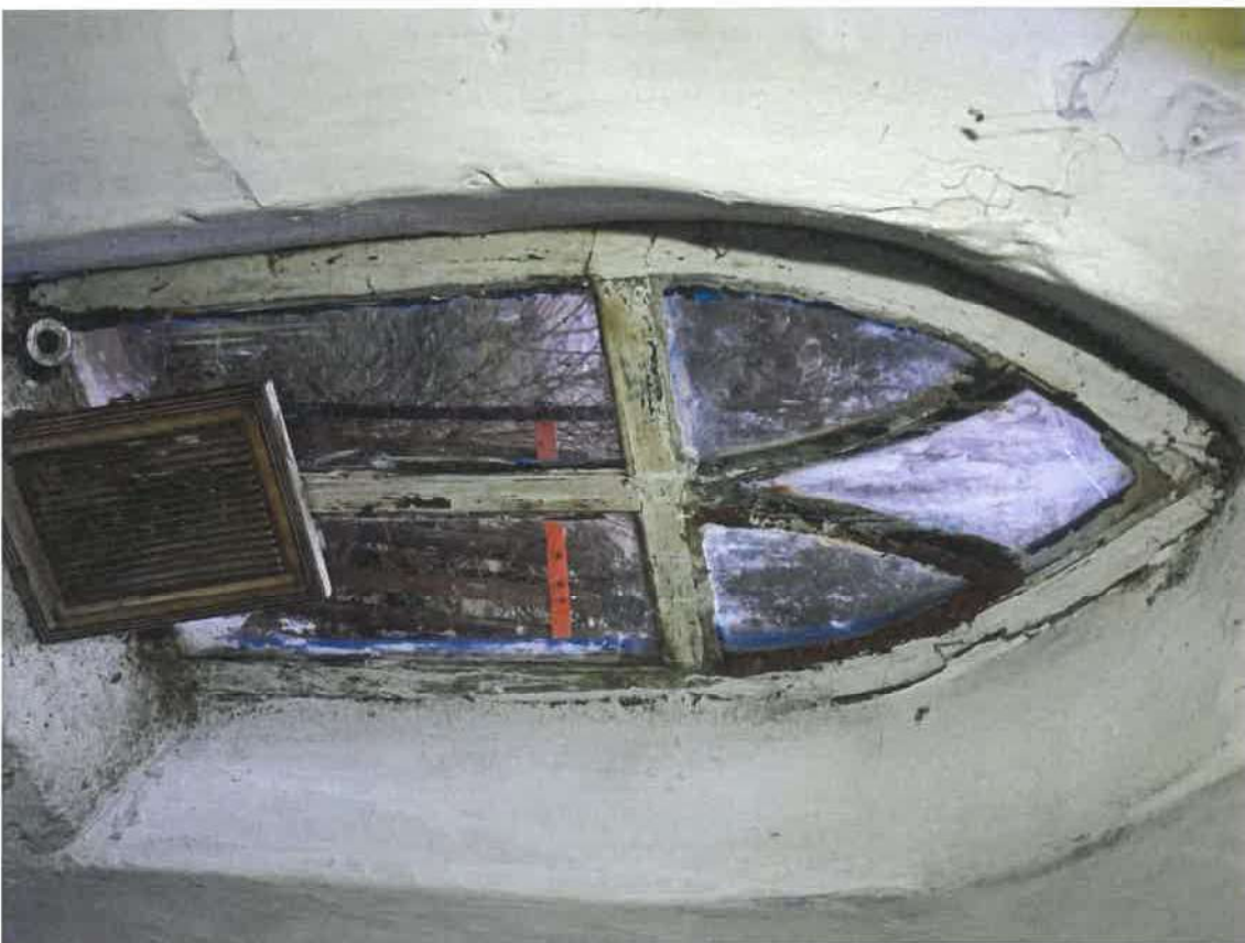
Fot. 39 – Kapliczka w Oparówce z drewnianymi świecznikami. Wnętrze. Zbliżenie na okno po stronie wschodniej, prawdopodobnie oryginalna stolarka drzwiowa, wtórne szklenie.
