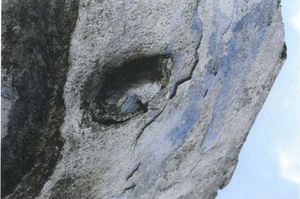
Fot. 25. – Kapliczka w Oparówce z Figurą Matki Bożej z Dzieciątkiem. Elewacja południowa. Zbliżenie na uszkodzenia i ubytki tynku. Widoczne poprzednie opracowania malarskie oraz cegła przemalowane pobiałą po ubytkach. Dodatkowo zielone naloty mikrobiologiczne. Tynk i sztukaterie w bardzo złym stanie.
