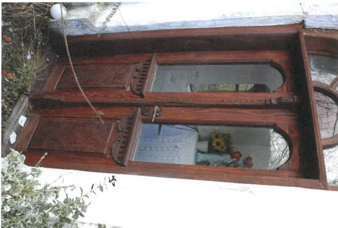
Fot. 27. – Kapliczka w Oparówce z Figurą Matki Bożej z Dzieciątkiem. Elewacja południowa. Zbliżenie na niedawno wymienione drzwi. Zachowane zostały zachowane oryginalne elementy sycerowane.
