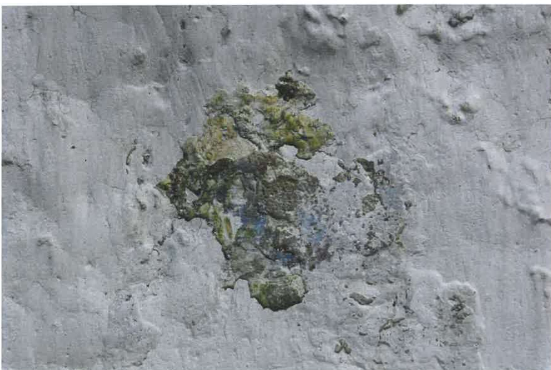
Fot. 41. – Kapliczka w Oparówe z drewnianymi świecznikami. Zbliżenie na ubytek w tynku.
