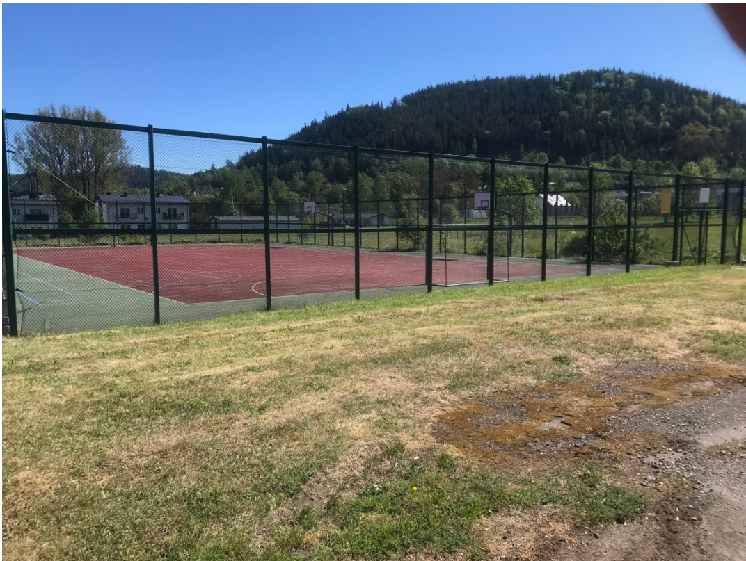
Fot. 2. Widok istniejącego boiska przed zadaszaniem
