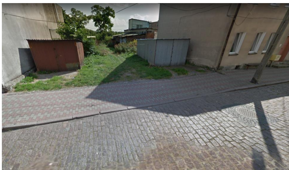
Zdj. 3 – Ist. nawierzchnia jezdni ul. Sienkiewicza – zjazd.
