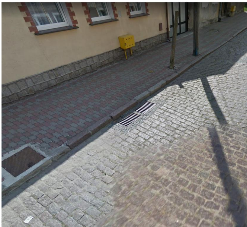
Zdj. 2 – Ist. nawierzchnia jezdni ul. Sienkiewicza – wpusty deszczowe i chodnik.
