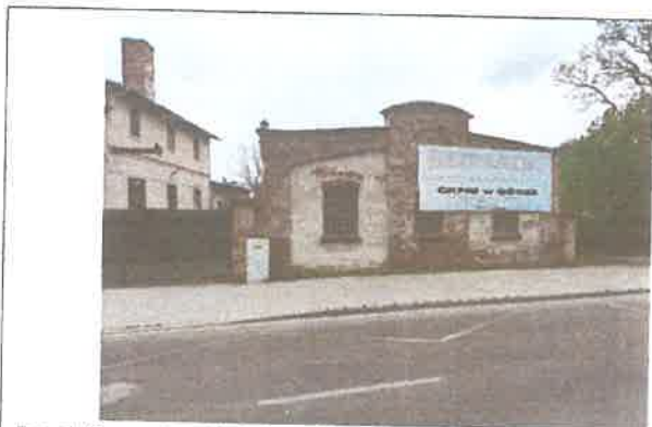
Fot. 1. Elewacja południowa budynku warsztatów
