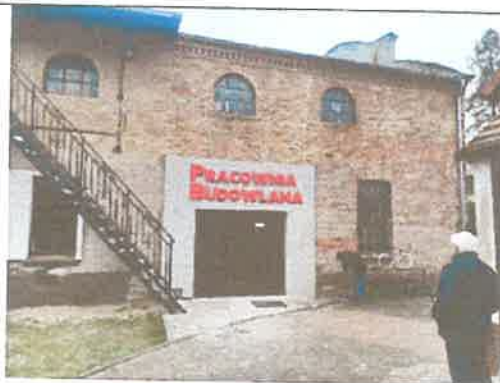
Fot. 4. Elewacja Zachodnia
