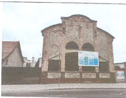
Fot. 2. Elewacja południowa budynku warsztatów i sal lekcyjnych
