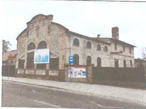
Fot. 3. Elewacja południowa i wschodnia
