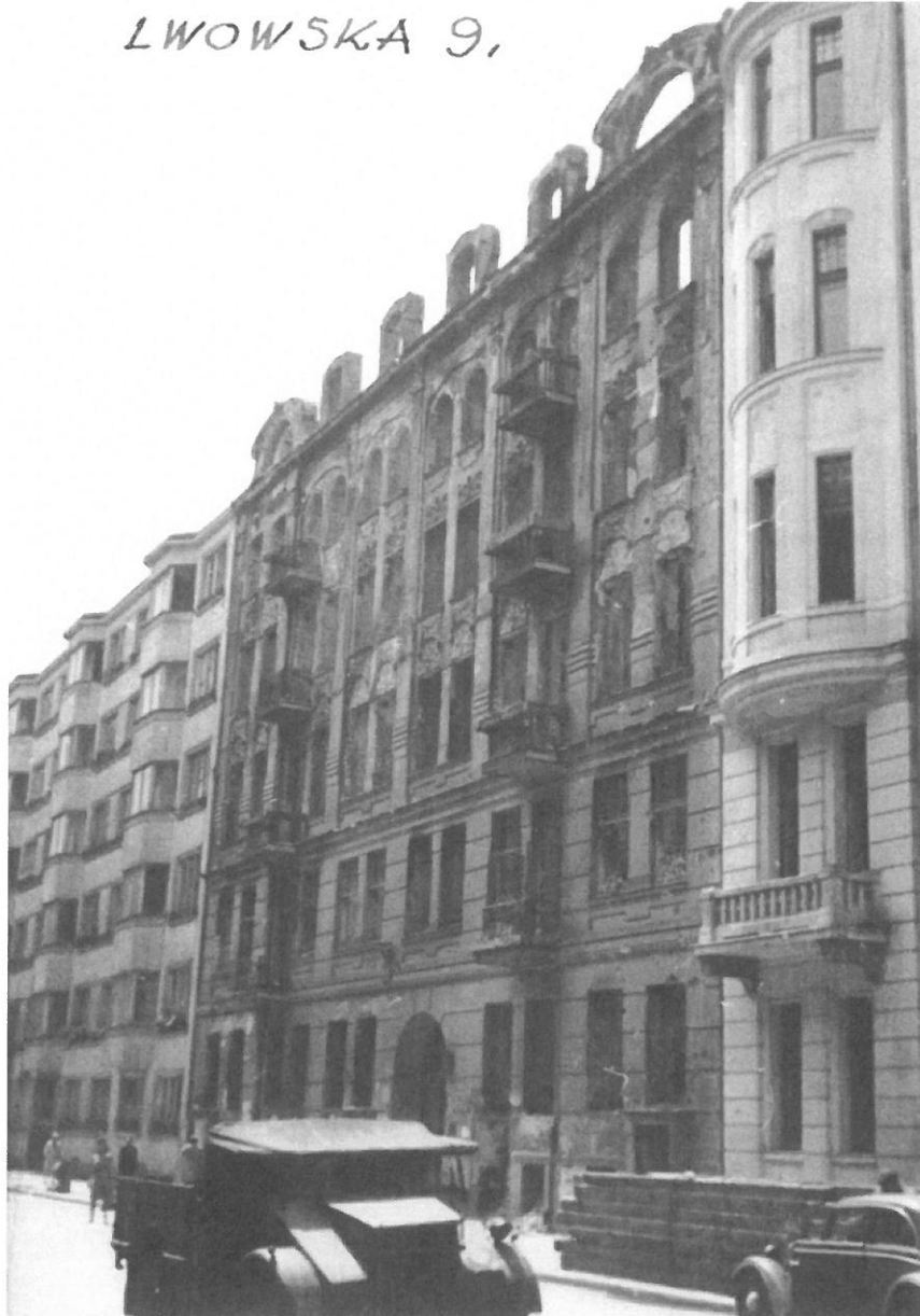
Fot. 16 Widok kamienicy Lwowska 9 na dalszym planie kamienica Lwowska 7, 1946 rok.
