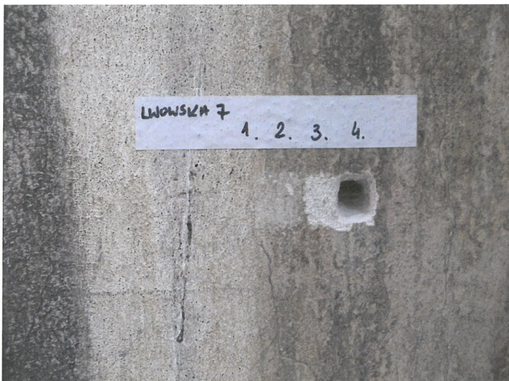
Fot.33. Odkrywka nr 2. Warstwy tynku elewacji parteru
