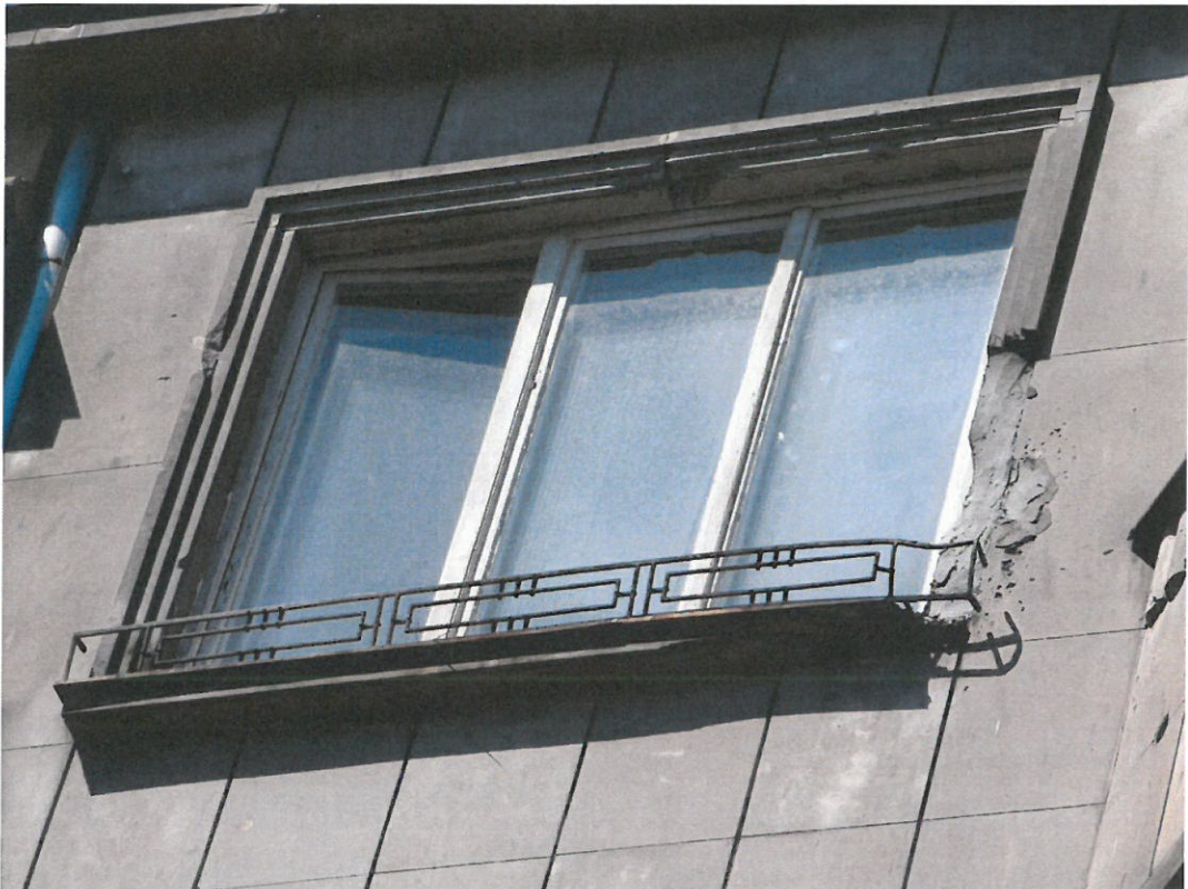
Fot.39. Naprawa piaskowca z zapraw cementowych – elewacja frontowa
