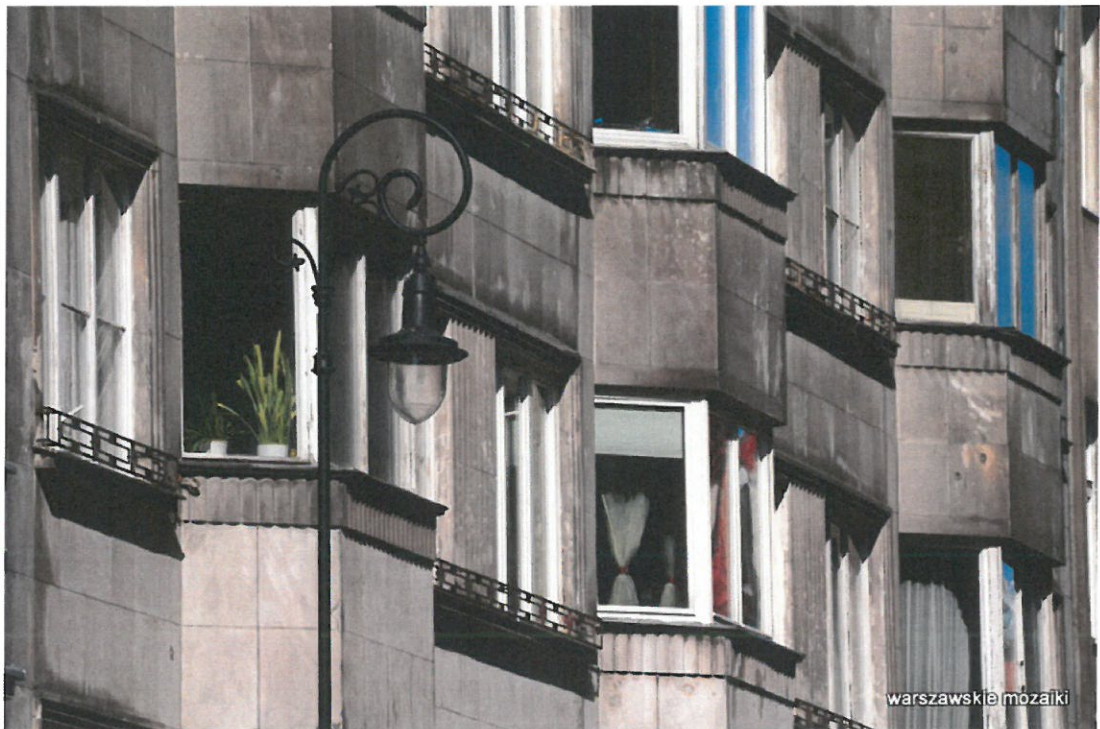
Fot.25. Detal gzymsu parapetowego z balustradką
