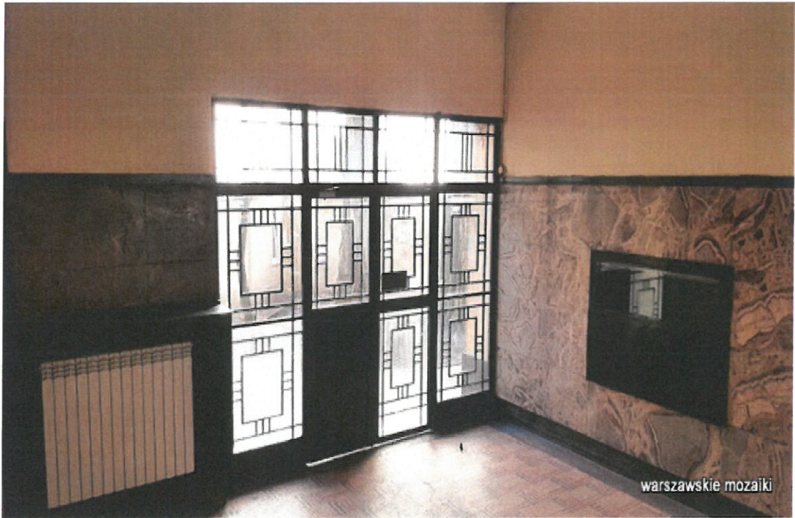
Fot.24. Czteroskrzydłowa przeszklona brama wejściowa.
