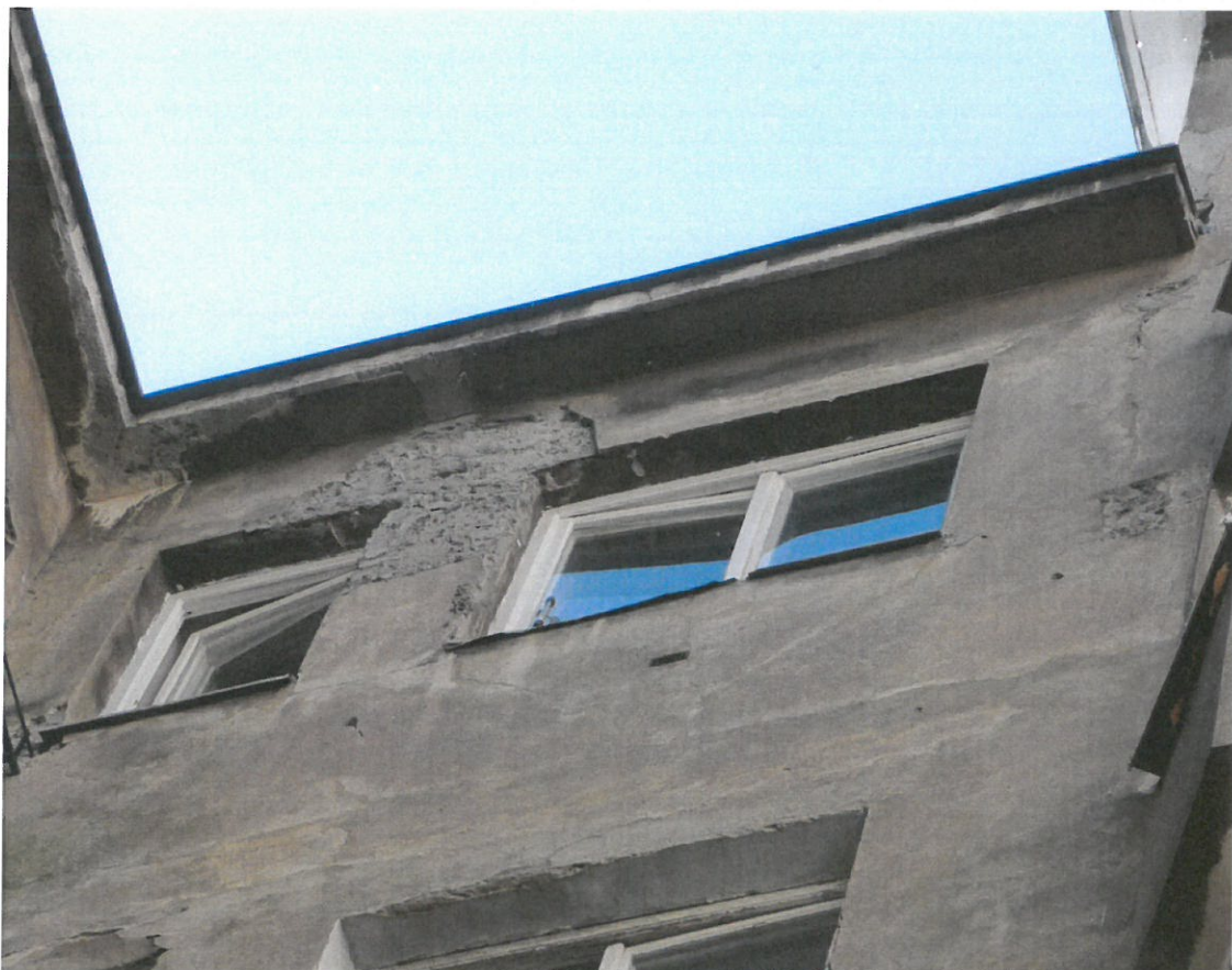
Fot.48. Wtórne naprawy elewacji.
