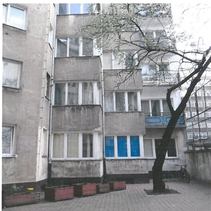
Fot.27. Elewacja od strony dziedzińca
