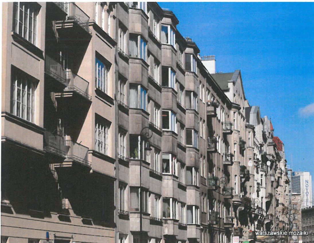
Fot.26. Elewacja kamienicy od strony ul. Lwowskiej
