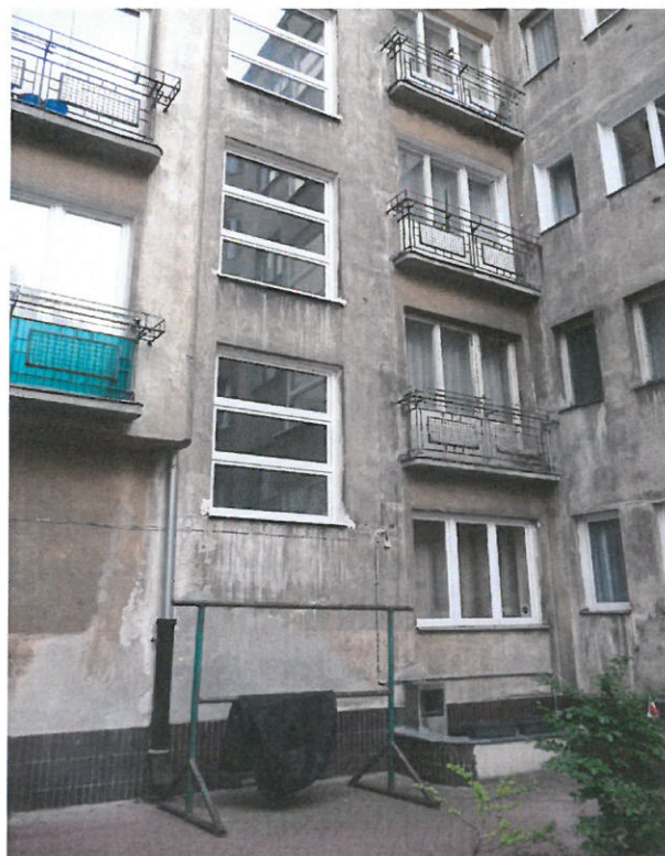
Fot.29. Elewacja od dziedzińca - portfenetry.
