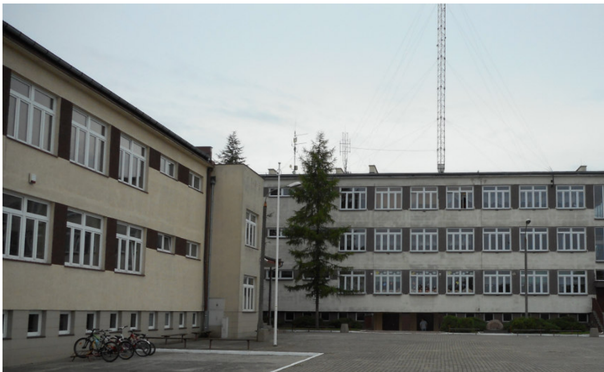
Rysunek 4: Widok wschodniej ściany budynku A i północnej ściany budynku D
