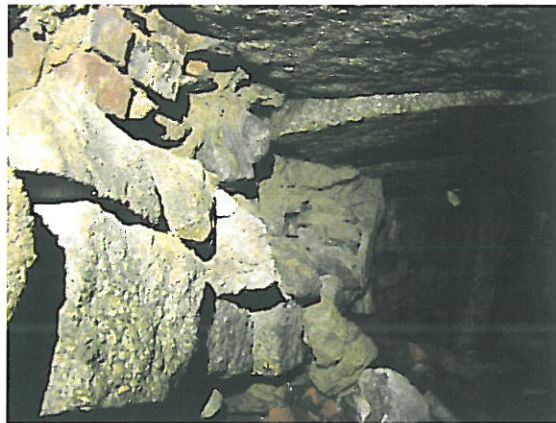
Widok na zawaloną ścianę i niepodparte płyty stropowe
