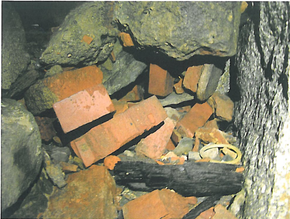
W zawale, także w jego odległych partiach brak jest frakcji drobnoziarnistej, świadczy to o okresowych, intensywnych przepływach wody
