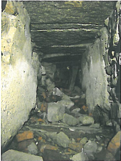
Widok na zawaloną ścianę i niepodparte płyty stropowe
