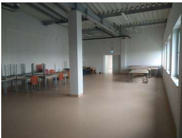
Fot. 2. Widok pomieszczenie do adaptacji w kierunku drzwi
