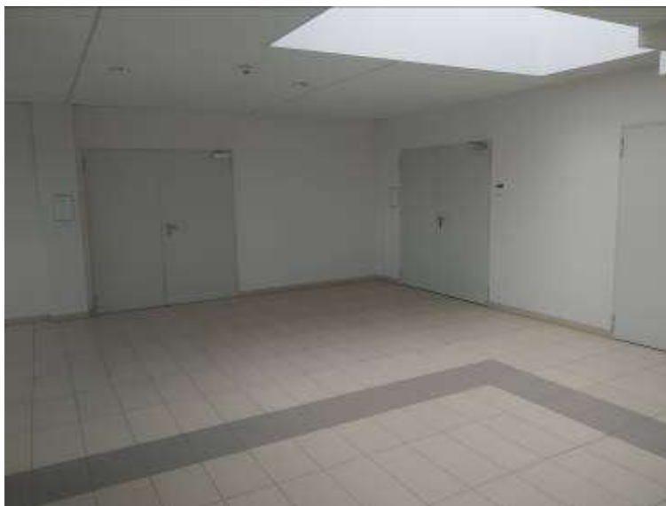
Fot. 4. Widok na drzwi pomieszczenia do adaptacji od strony klatki schodowej oraz do pomieszczeń technicznych
