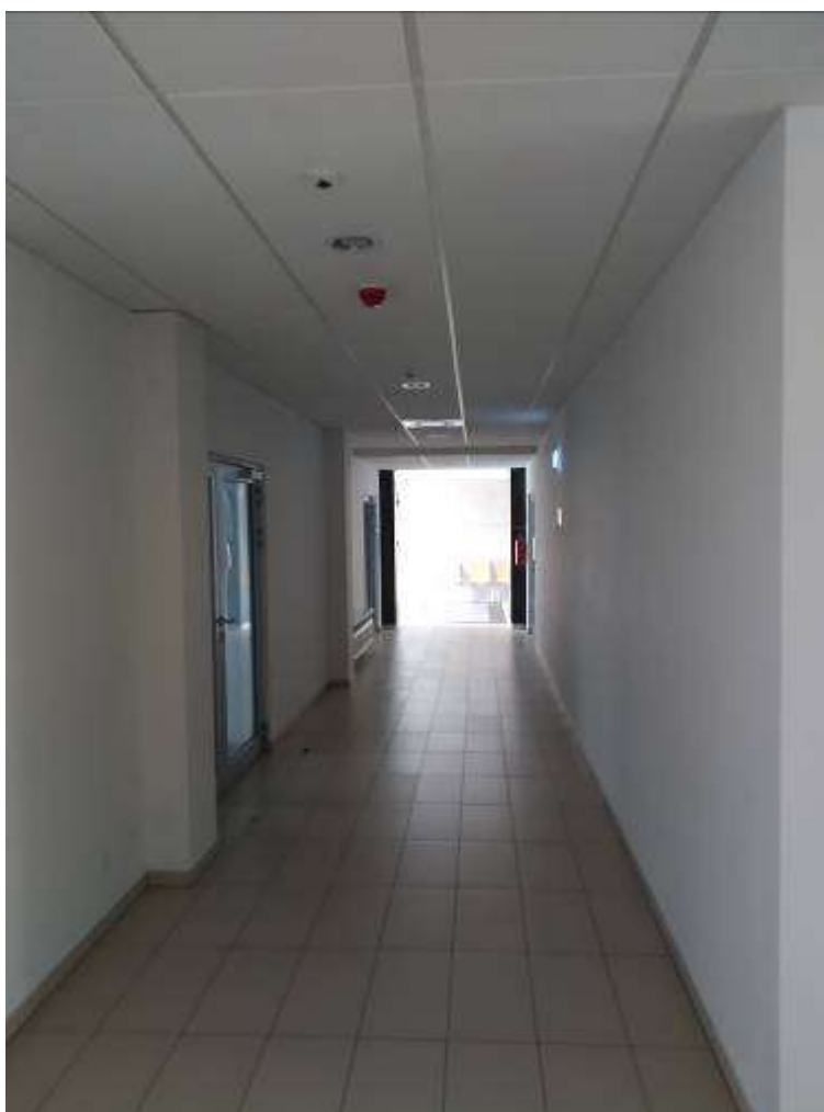
Fot. 5. Widok na korytarz na kondygnacji poniżej pomieszczenia do adaptacji, przez który mają być prowadzone instalacje
