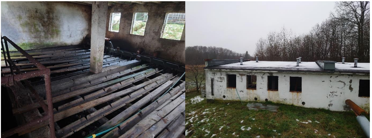
Fot. 4 Złoża biologiczne.
