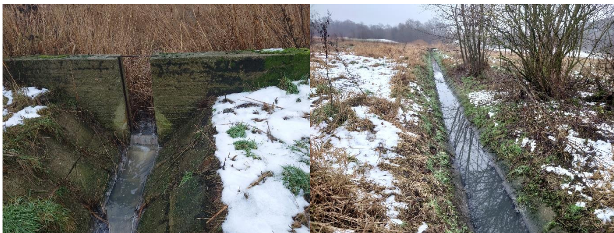
Fot. 8 Istniejący wylot do odbiornika i rów ziemny.
