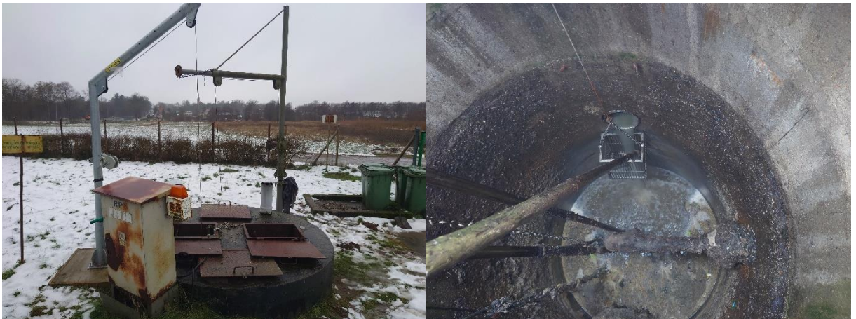
Fot. 2 Przepompownia ścieków.
