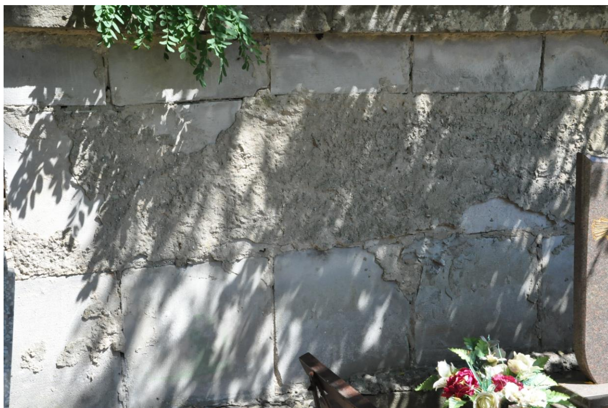
Ogrodzenie współczesne (widok od strony cmentarza). Widoczne ubytki w okładzinie tynkowej oraz spoinach.
