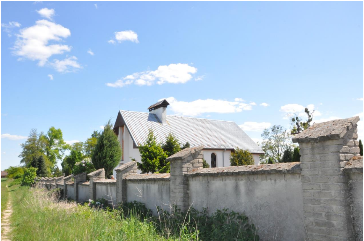
Ogrodzenie murowane z cegły betonowej – widok od strony północnej terenu przeznaczonego pod rozbudowę.
