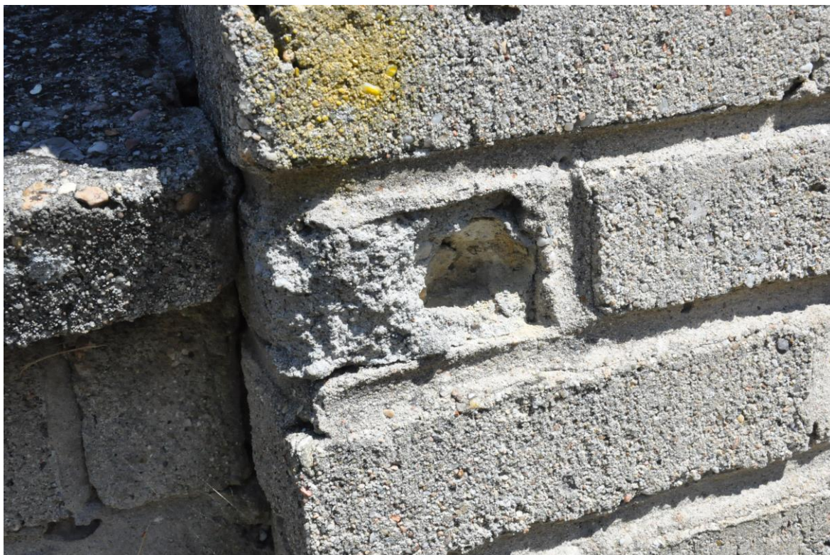
Ogrodzenie współczesne, ubytki w strukturze betonowej cegły.
