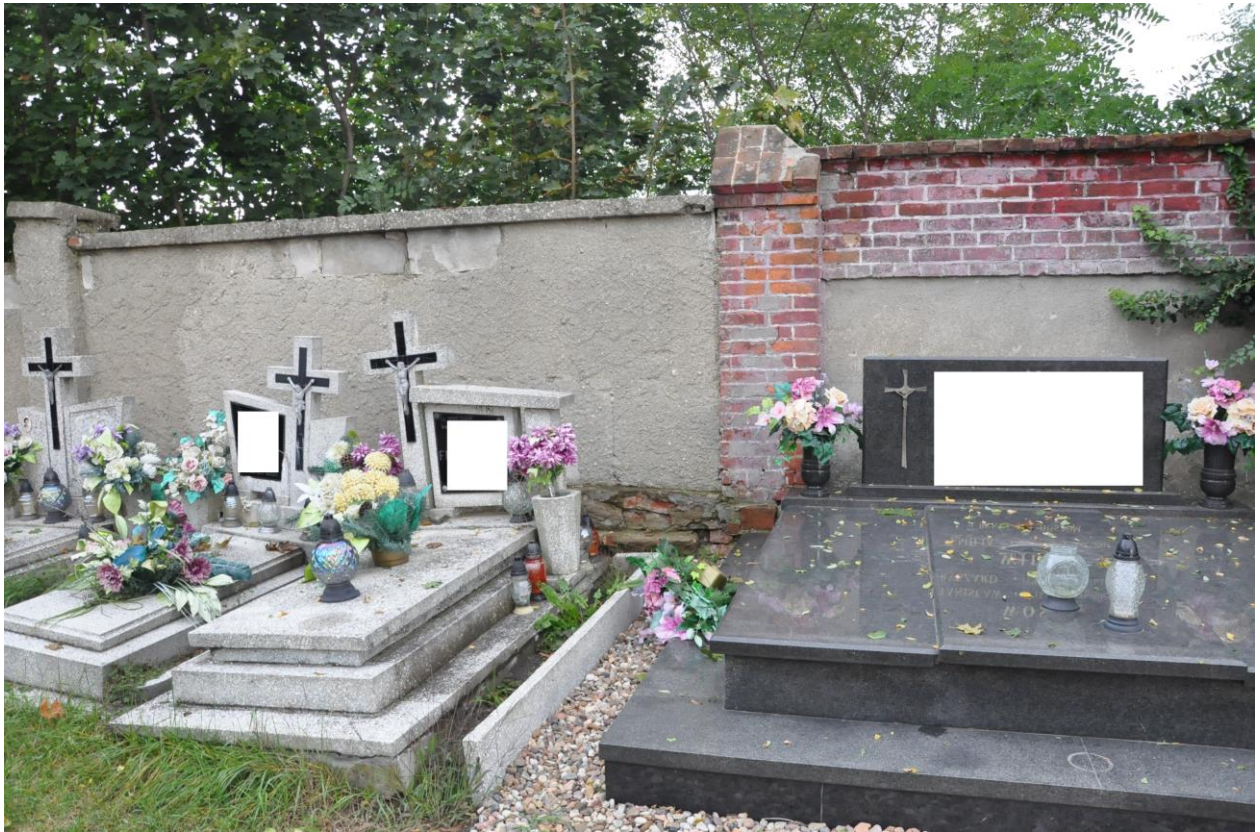
Połączenie ogrodzenia historycznego ze współczesnym (z bloczków gazobetonowych).
