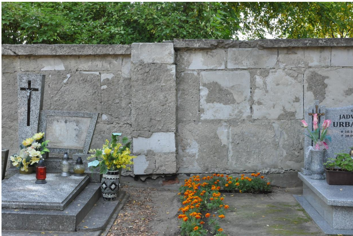
Ogrodzenie współczesne (widok od strony cmentarza). Widoczne ubytki w okładzinie tynkowej oraz spoinach. Ubytki zadaszenia.
