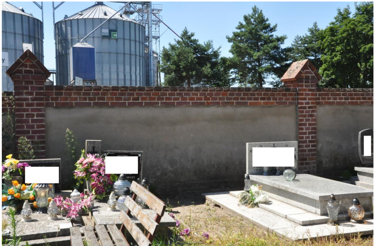
Ogrodzenie murowane z bloczków gazobetonowych – widok od strony cmentarza.
