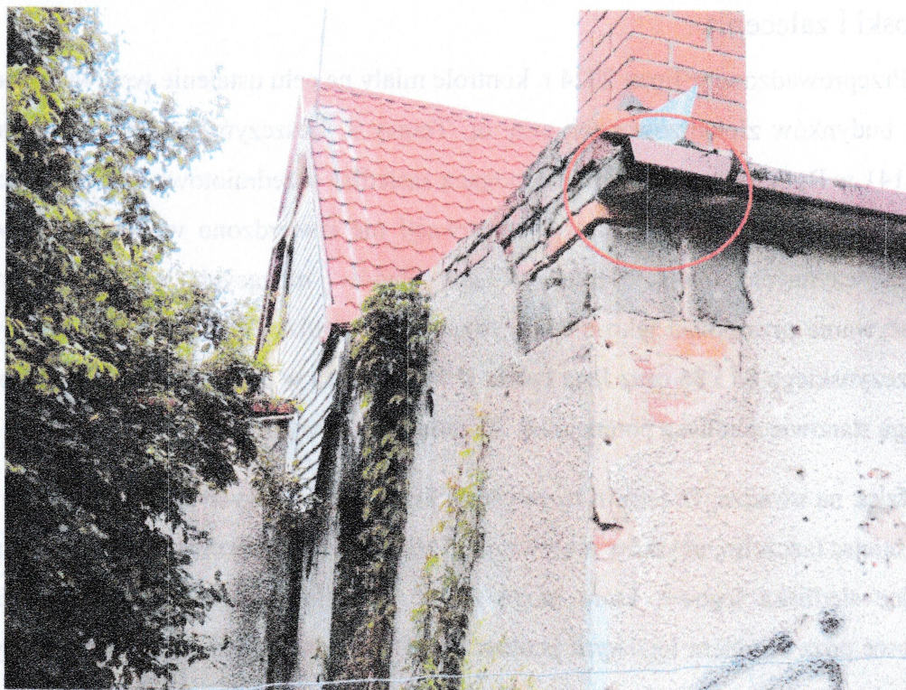
Fot. 16 Szczelina pod obróbką blacharską budynku mieszkalnego, która była niezasiedlona w trakcie prowadzenia obserwacji, mogąca stanowić siedliska potencjalne
