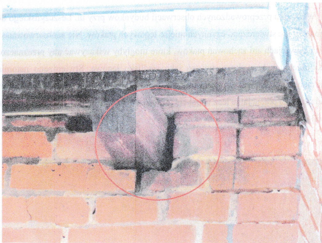
Fot. 11 Szczelina w ścianie budynku gospodarczego (od strony Leszczyńskiego 86)
