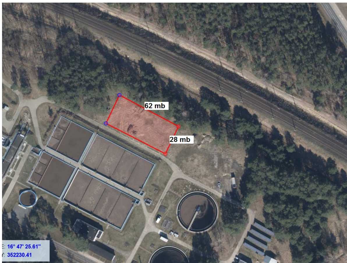
Rys. 1 Wydzielone miejsce do montażu elektrowni fotowoltaicznej.
