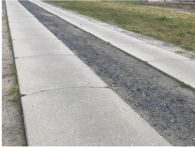
Rys. 4. Nawierzchnia z płyt drogowych na piór-wpust PDTP
