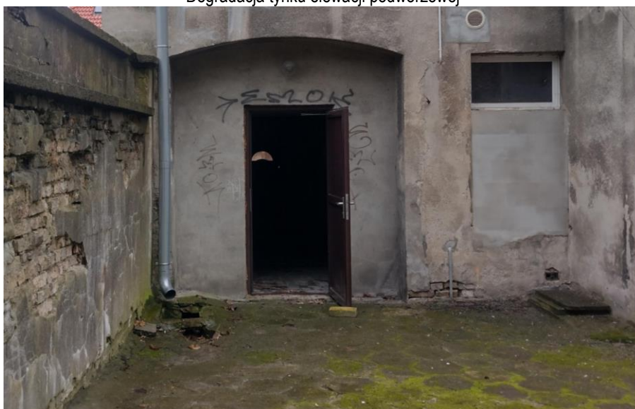
Elewacja podwórzowa – uszkodzenia muru granicznego i studni deszczowej
