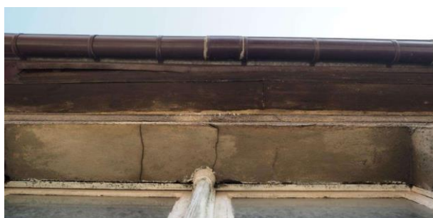
Elewacja frontowa – uszkodzenia nadproży (foto P.Antoniuk)
