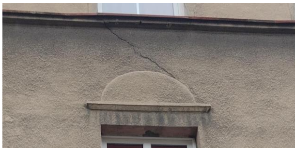
Elewacja frontowa – uszkodzenia tynku
