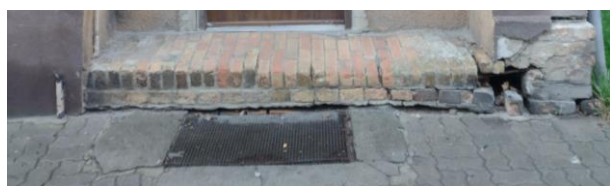
Elewacja frontowa – uszkodzenia podestu i wylotu kanału wodnego
