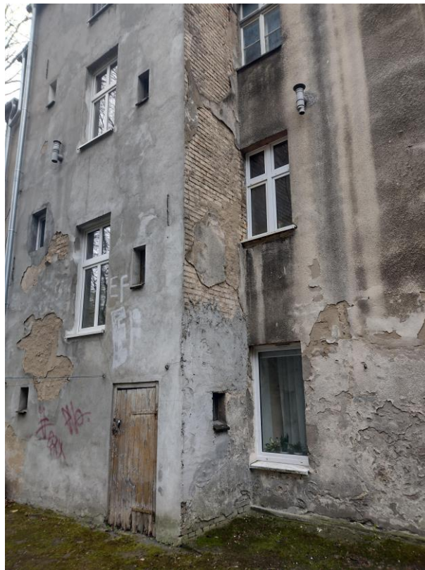
Degradacja tynku elewacji podwórzowej
