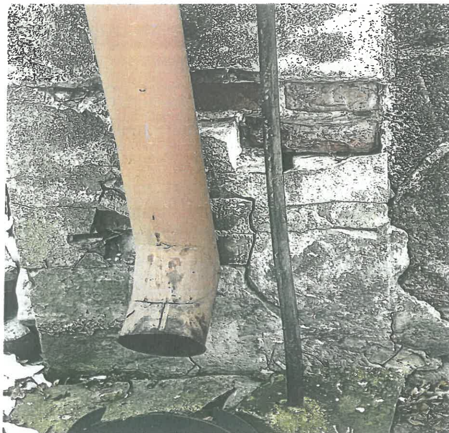
Zdjęcie 9 Degradacja narożnika cokołu – strona południowa
