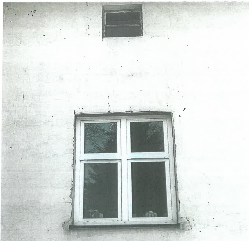
Zdjęcie 5 Degradacja tynków – strona południowa
