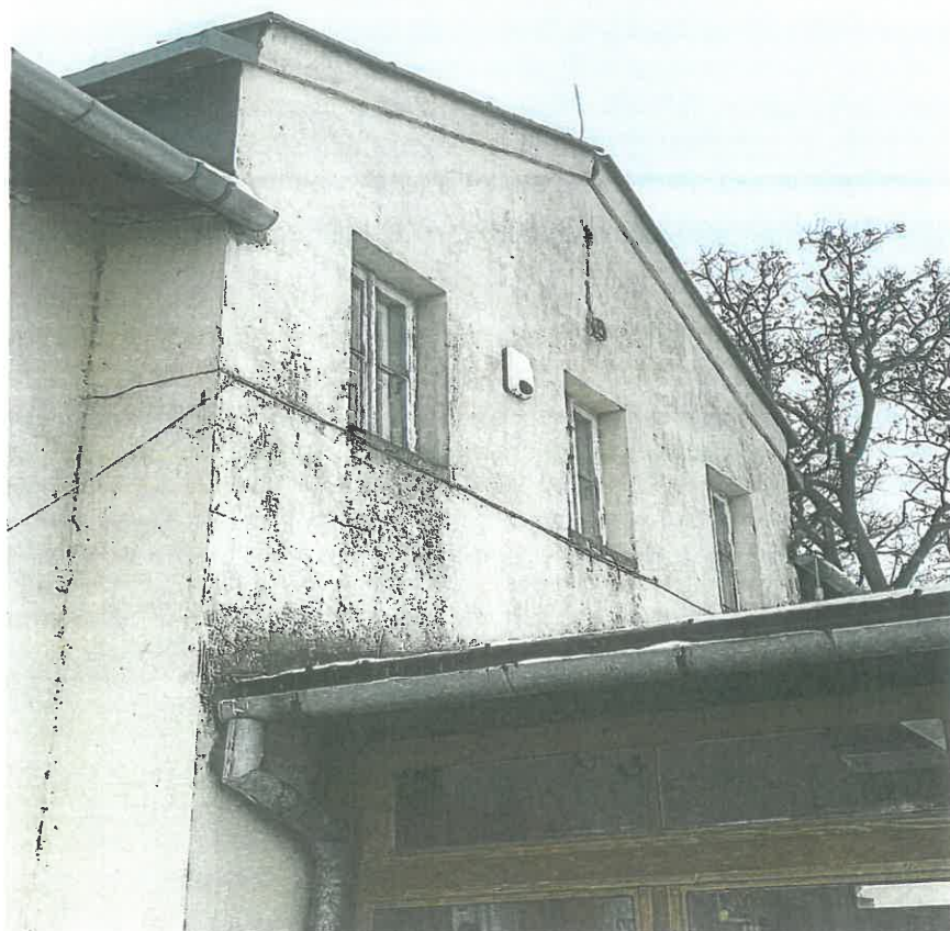
Zdjęcie 6 Degradacja tynków nad gankiem - strona północna
