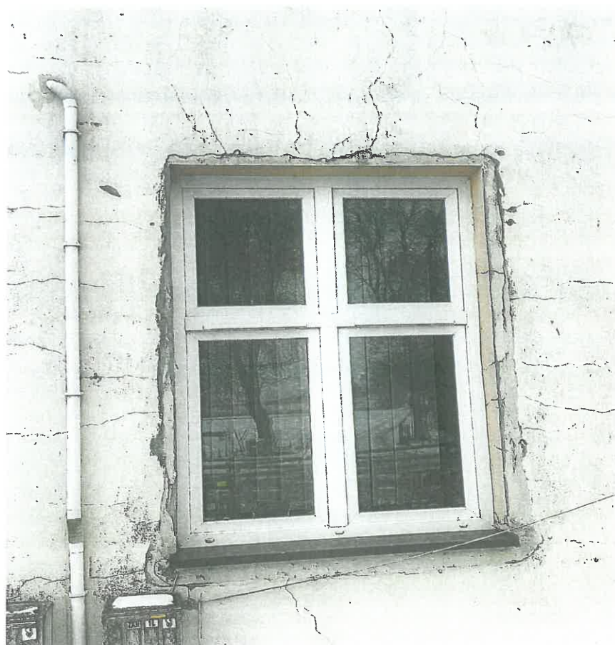
Zdjęcie 4 Degradacja tynków - strona północna
