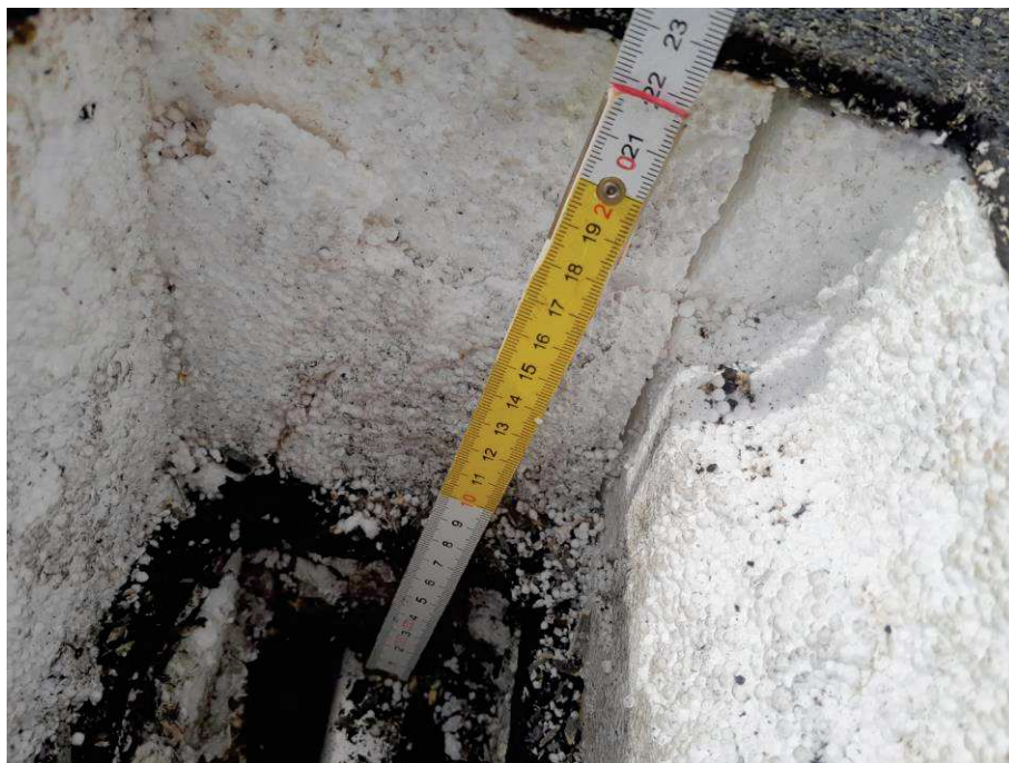
Fot. 4.33 Pomiar warstw pokrycia w lokalizacji nr 2
