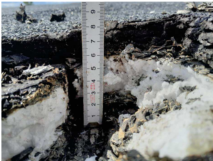
Fot. 4.35 Pomiar warstw pokrycia w lokalizacji nr 4
