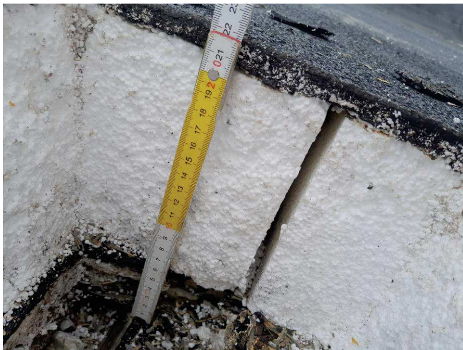
Fot. 4.31 Pomiar warstw pokrycia w lokalizacji nr 1
