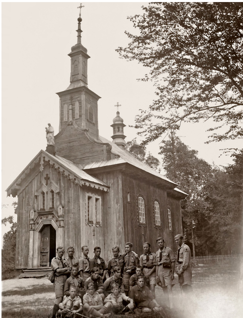
zdj. 6 Drewniana kaplica - 1937rok, zdjęcie zasoby ZHP, widoczne ogrodzenie drewniane sztachetkowe wzdłuż północnej części działki przykościelnej
