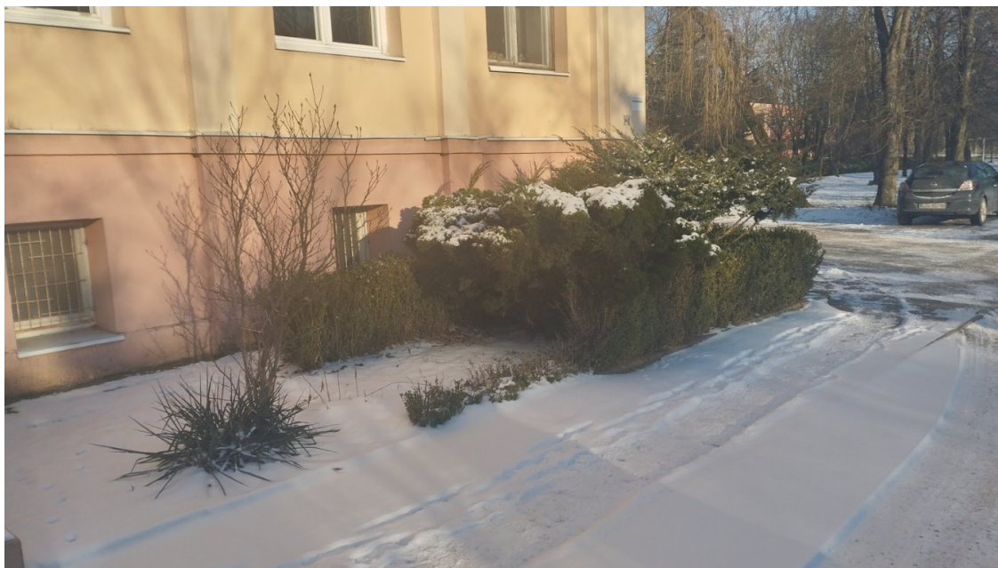
zdj.10 Rabata pod elewacją południową pałacu do przebudowy
