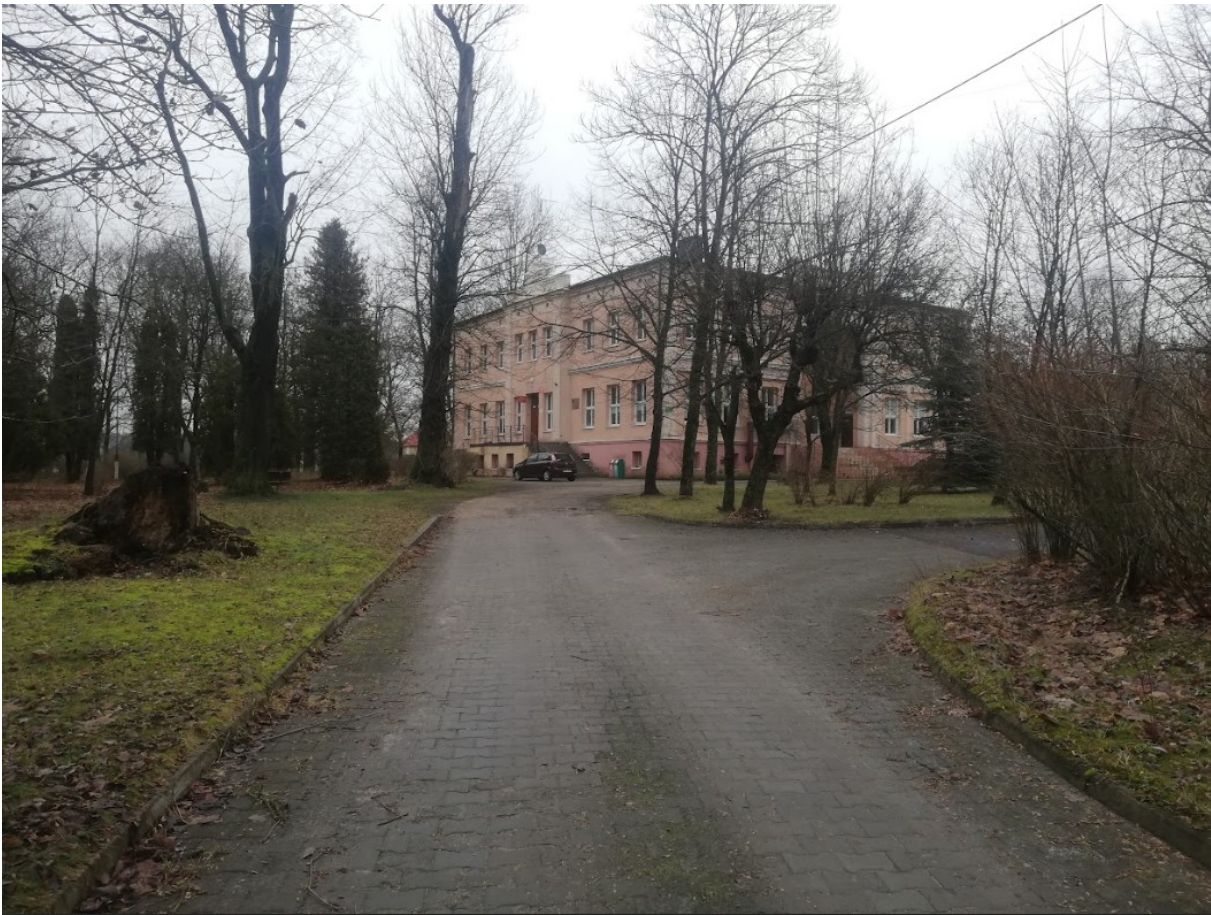
zdj. 2 Wygląd współczesny pałacu - widok od bramy wjazdowej
