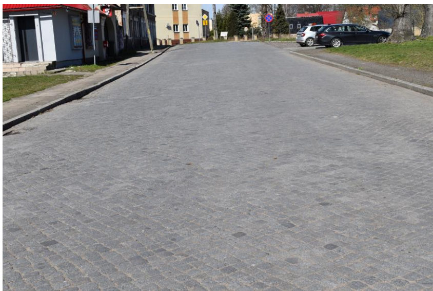
Zdj. 2. Nawierzchnia ul. Mieszka I – okolice skrzyżowania z ul. Dworcową.
