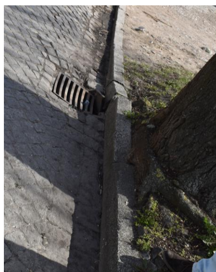
Zdj. 5-6. Uszkodzenia krawężników i jezdni przez korzenie drzew.
