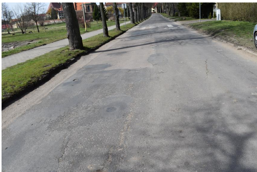
Zdj. 4. Nawierzchnia ul. Dworcowej – koniec opracowania.
