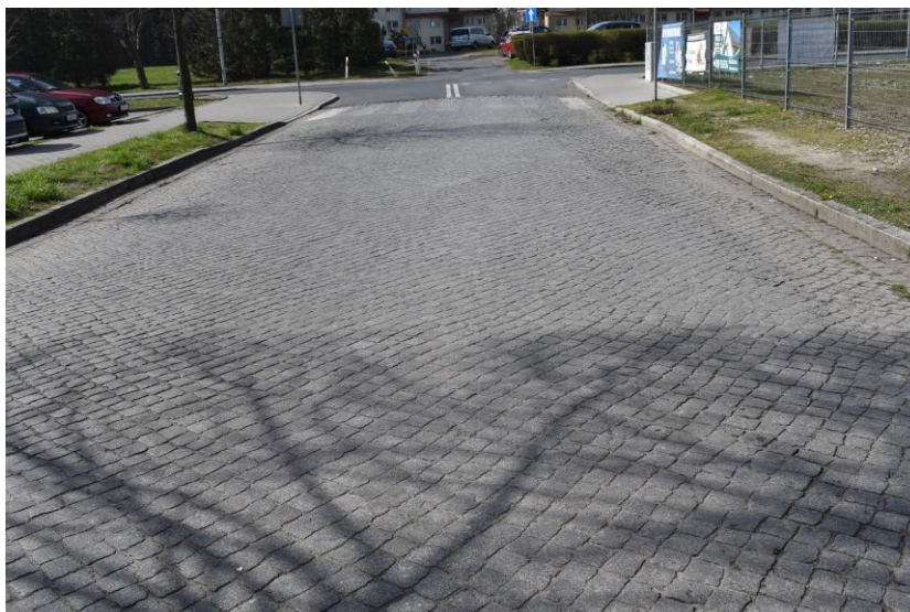
Zdj. 1. Nawierzchnia ul. Mieszka I – początek opracowania.
