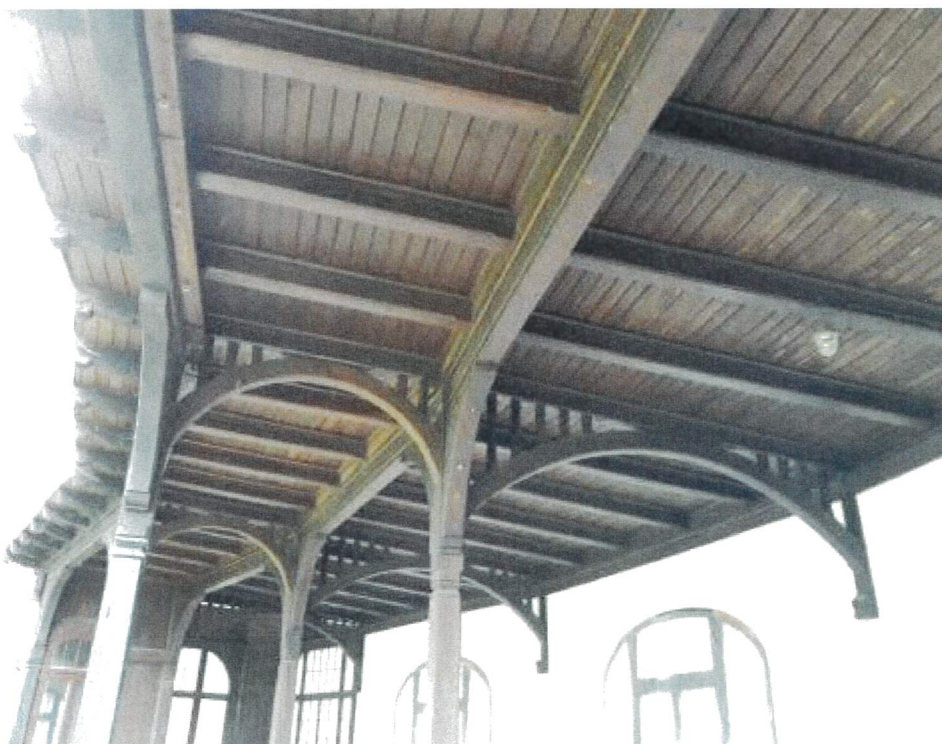
Fot.4 Patio. Drewniana konstrukcja stropodachu.
