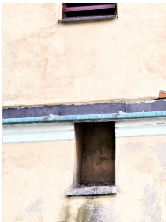
il..17.Wiskitki – kościół. Spadły tynk w rynnie dachu kościoła opadły z hełmu północnego; Elementy hełmu i attyki wieży południowej, 2024 . fot. J.Socha
