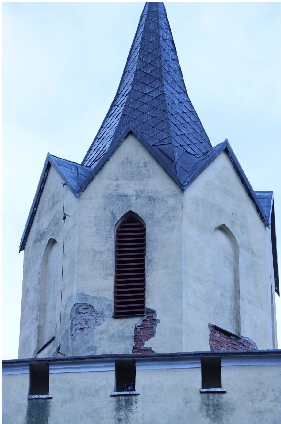
il.10. Wiskitki – Kościół. Stan awaryjny odpadających tynków i czarne zabrudzenia lica tynków od wody atmosferycznej z pyłami technicznymi. Stan 2023 (fot. ze zbiorów parafii)
