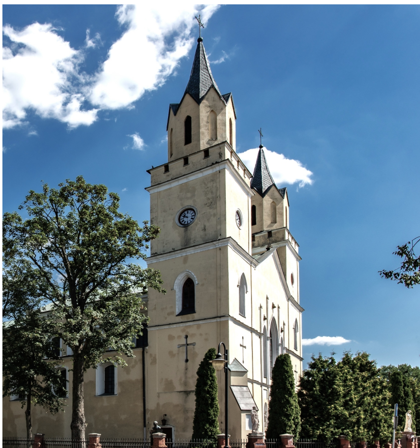
il.9. Wiskitki - Kościół. Elewacja północna i zachodnia wież fasady. Stan tynków elewacji północnej kościoła jest zły z powodu ingerencji w mury wody gruntowej i brudów środowiskowych w wodzie atmosferycznej. Tynki na hełmach wież i na attykach z blankowaniem, są w stanie awaryjnym.
