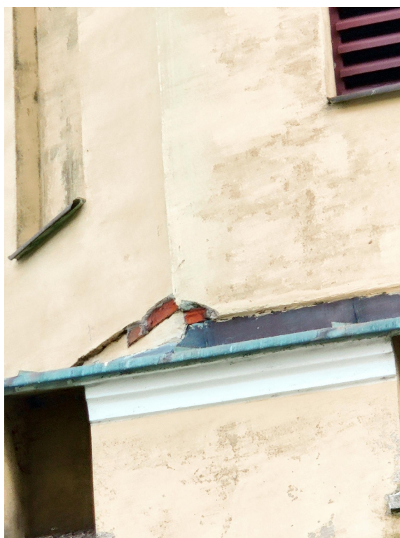
il..17.Wiskitki – kościół. Spadły tynk w rynnie dachu kościoła opadły z hełmu północnego; Elementy hełmu i attyki wieży południowej, 2024 . fot. J.Socha
