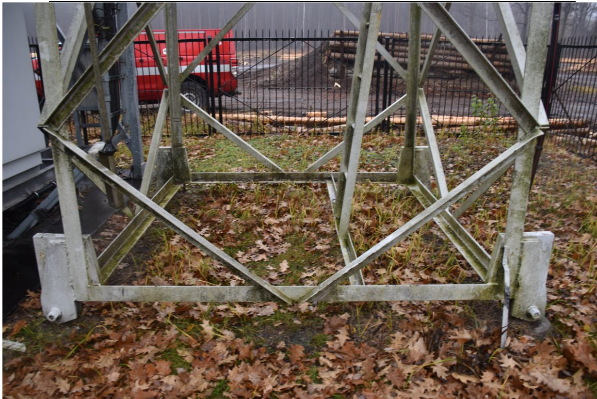
Rys. 2a. Podstawa wieży.
