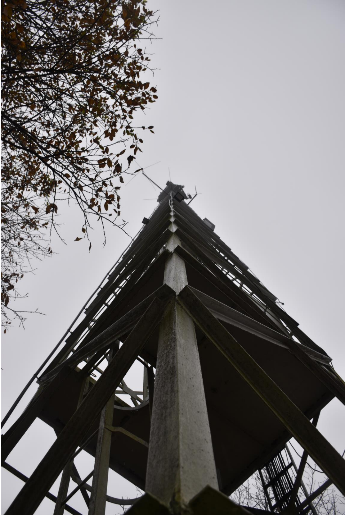
Rys.4c. Widok geometrii krawężników wieży ( nie stwierdzono istotnej nie prostoliniowości krawężników dostrzegalni) .
