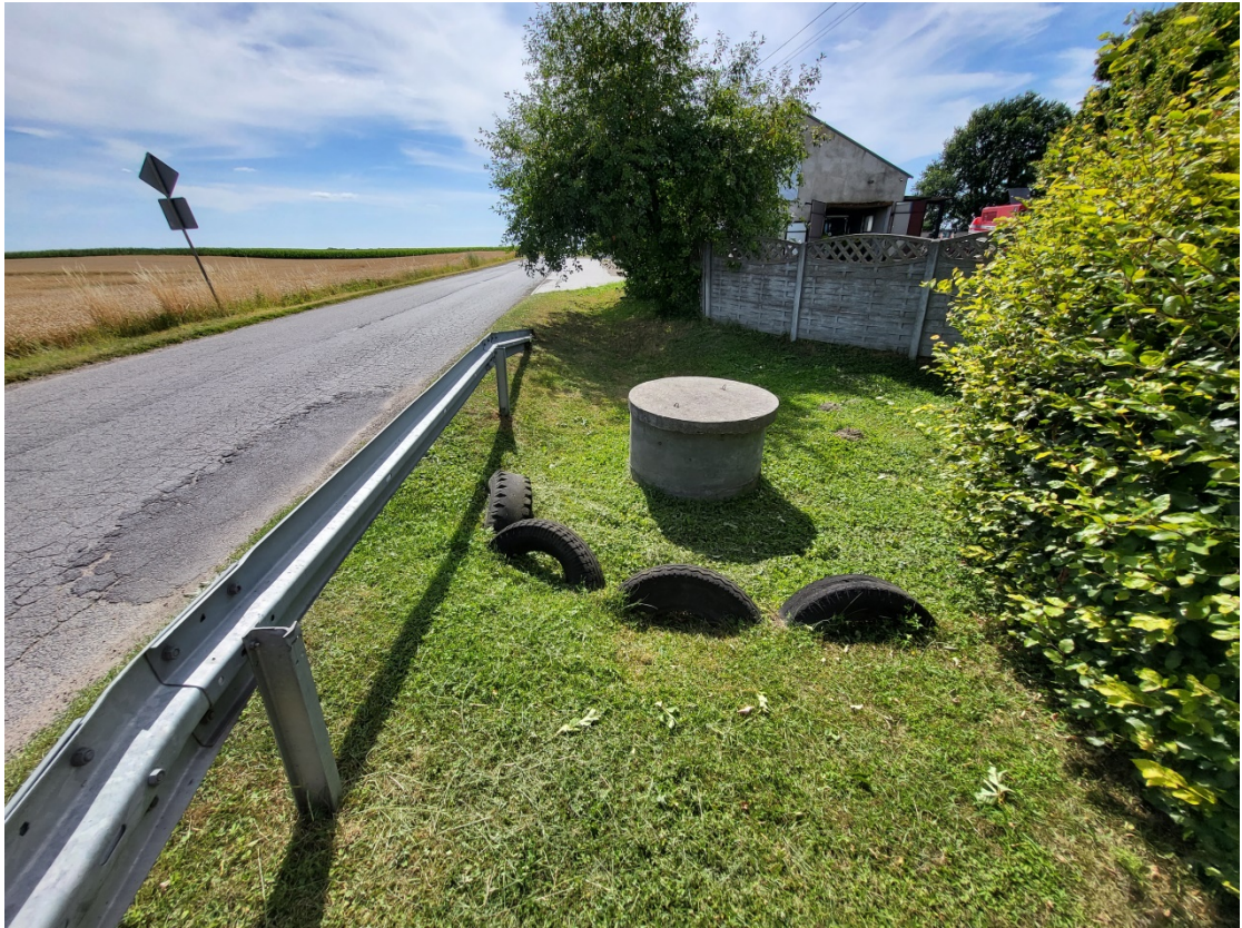
Fot. 2.2.11.3.3 Studnia na załamaniu trasy przepustu
