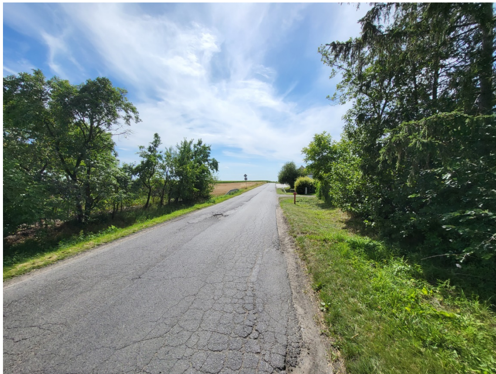
Fot. 2.2.11.3.1 Droga w rejonie przepustu
