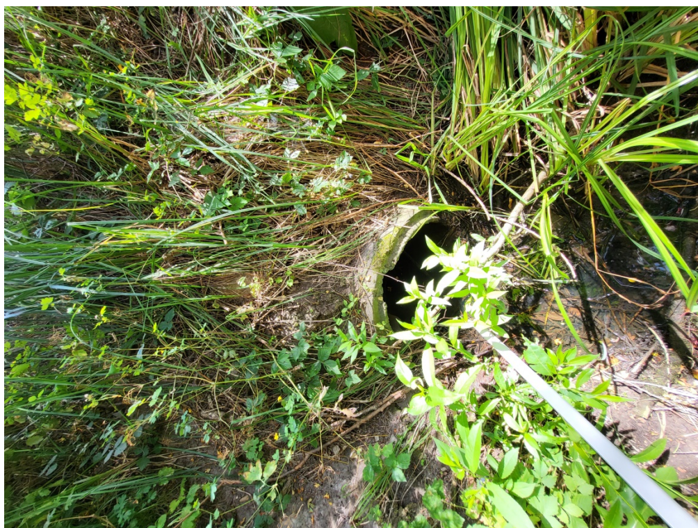
Fot. 2.2.11.2.2 Wlot przepustu
