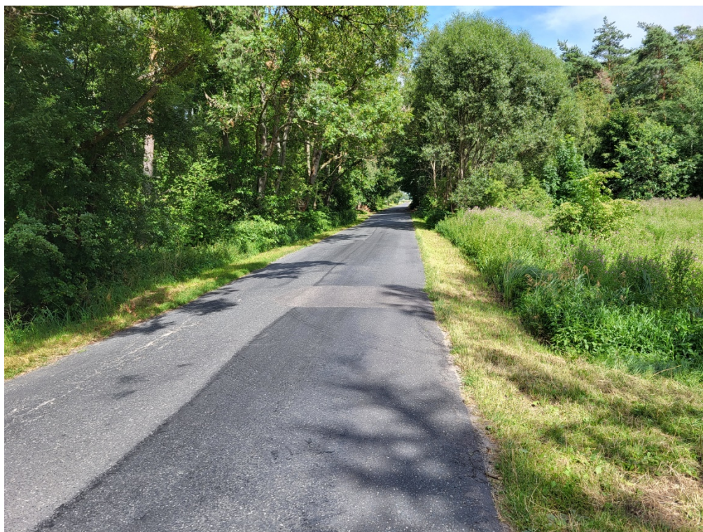
Fot. 2.2.11.1.1 Droga w rejonie przepustu
