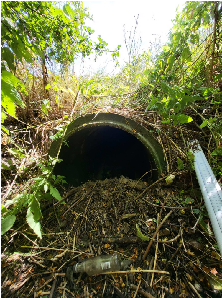
Fot. 2.2.11.2.3 Wylot przepustu
