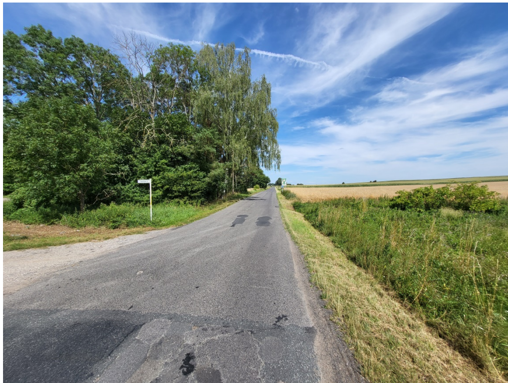
Fot. 2.2.11.2.1 Droga w rejonie przepustu
