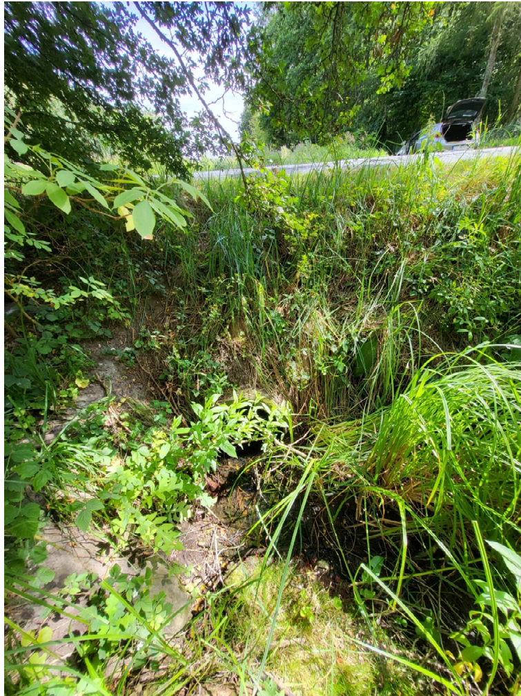
Fot. 2.2.11.1.2 Wlot przepustu
