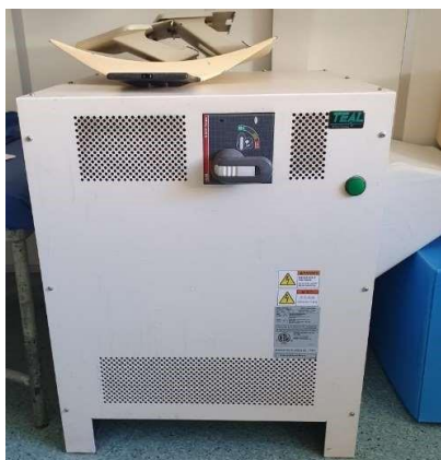
Układ zasilający tomograf komputerowy z oznakowaniem producenta
