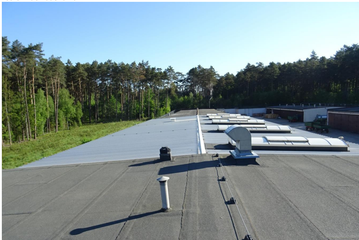
Fot. 3 widok dachu hali
