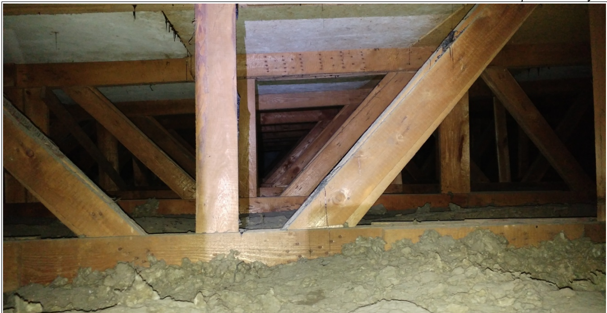
zdjęcie nr 7 – drewniana konstrukcja kratowa
