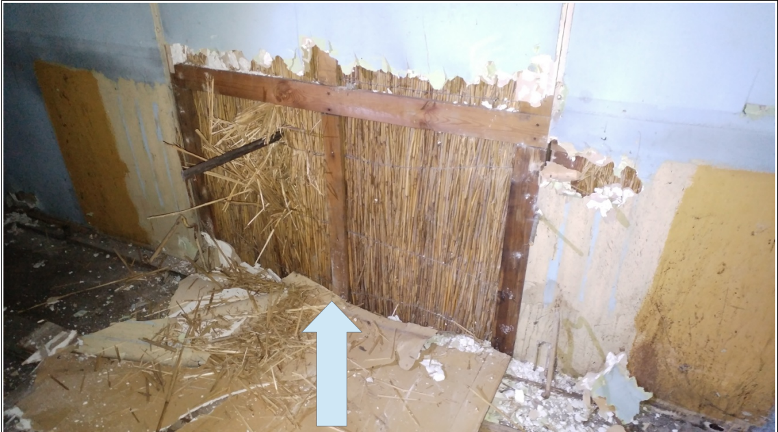
Zdjęcie nr 2 i 3 – szkieletowa, drewniana konstrukcja ścian budynku z widoczną wewnątrz matą słomianą jako dociepleniem
