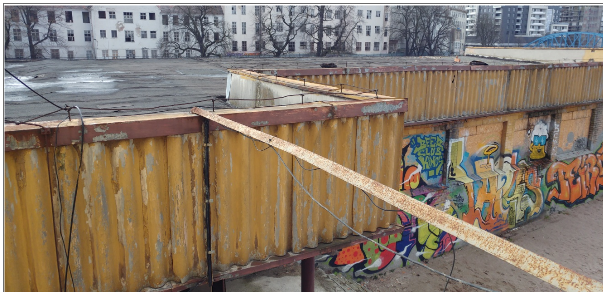
zdjęcie nr 8 – popękane i ułamane azbestowo-cementowe płyty płaskie ściany budynku od strony koryta rzeki Odry zdjęcie nr 9 – osłona części dachowej budynku (biegnąca po jego obwodzie), wykonana z azbestowo-cementowych płyt falistych
