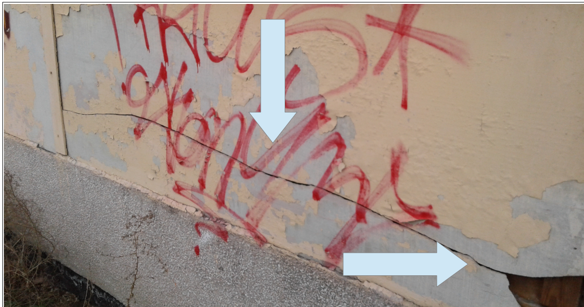
zdjęcie nr 8 – popękane i ułamane azbestowo-cementowe płyty płaskie ściany budynku od strony koryta rzeki Odry zdjęcie nr 9 – osłona części dachowej budynku (biegnąca po jego obwodzie), wykonana z azbestowo-cementowych płyt falistych
