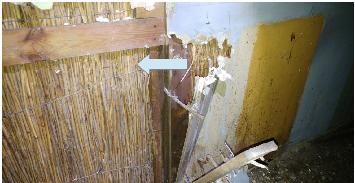
Zdjęcie nr 2 i 3 – szkieletowa, drewniana konstrukcja ścian budynku z widoczną wewnątrz matą słomianą jako dociepleniem
